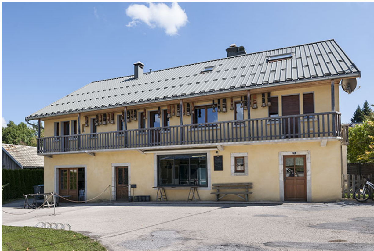
Façade ouest de l'atelier de fabrication.
