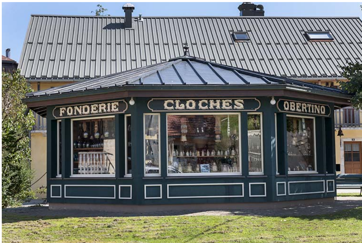
La boutique vue depuis l'ouest.
