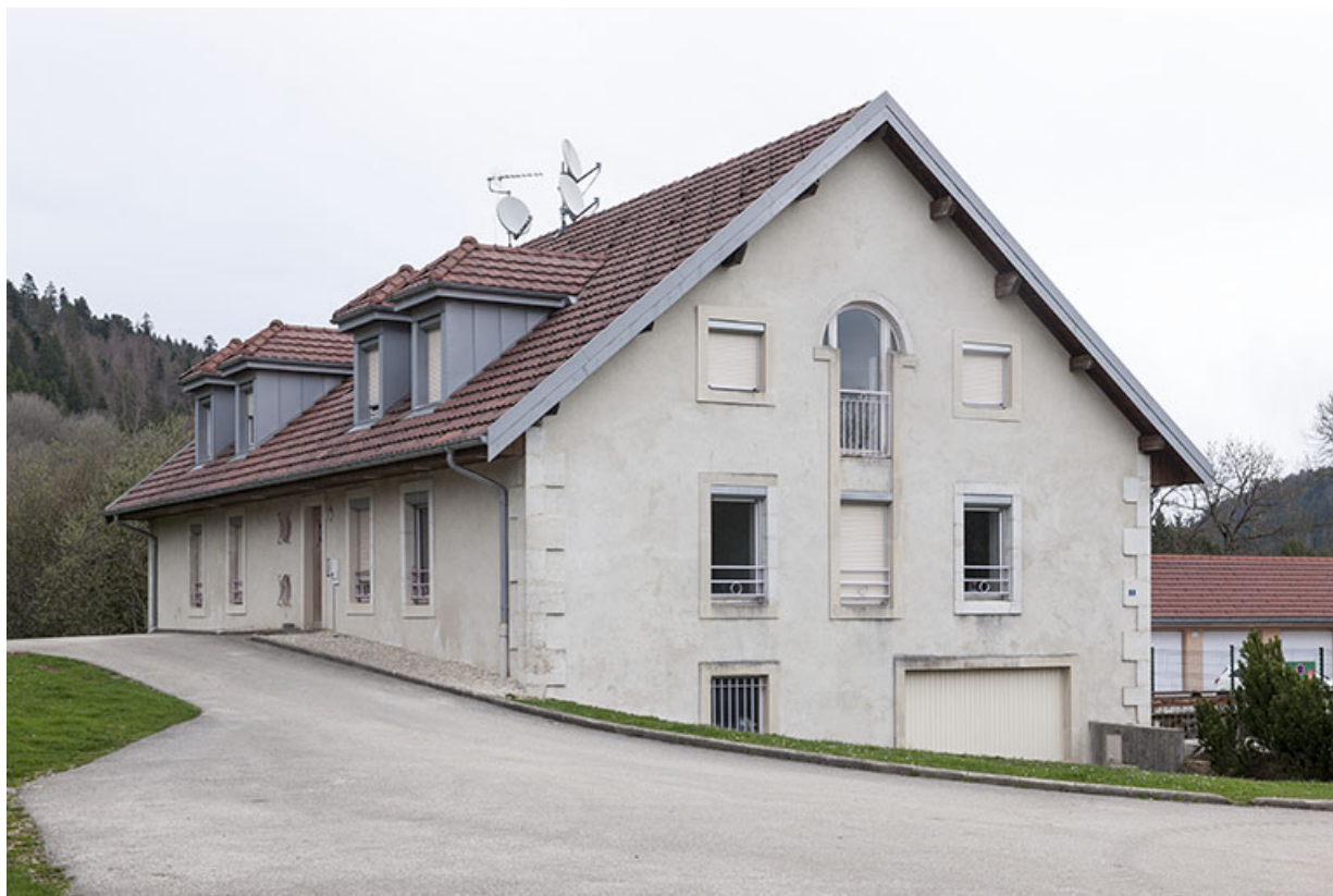
Vue depuis le sud-ouest.
