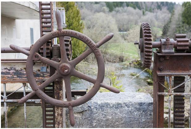
**Détail du mécanisme du vannage.** 25, Oye-et-Pallet, 3 rue de la Baignade
