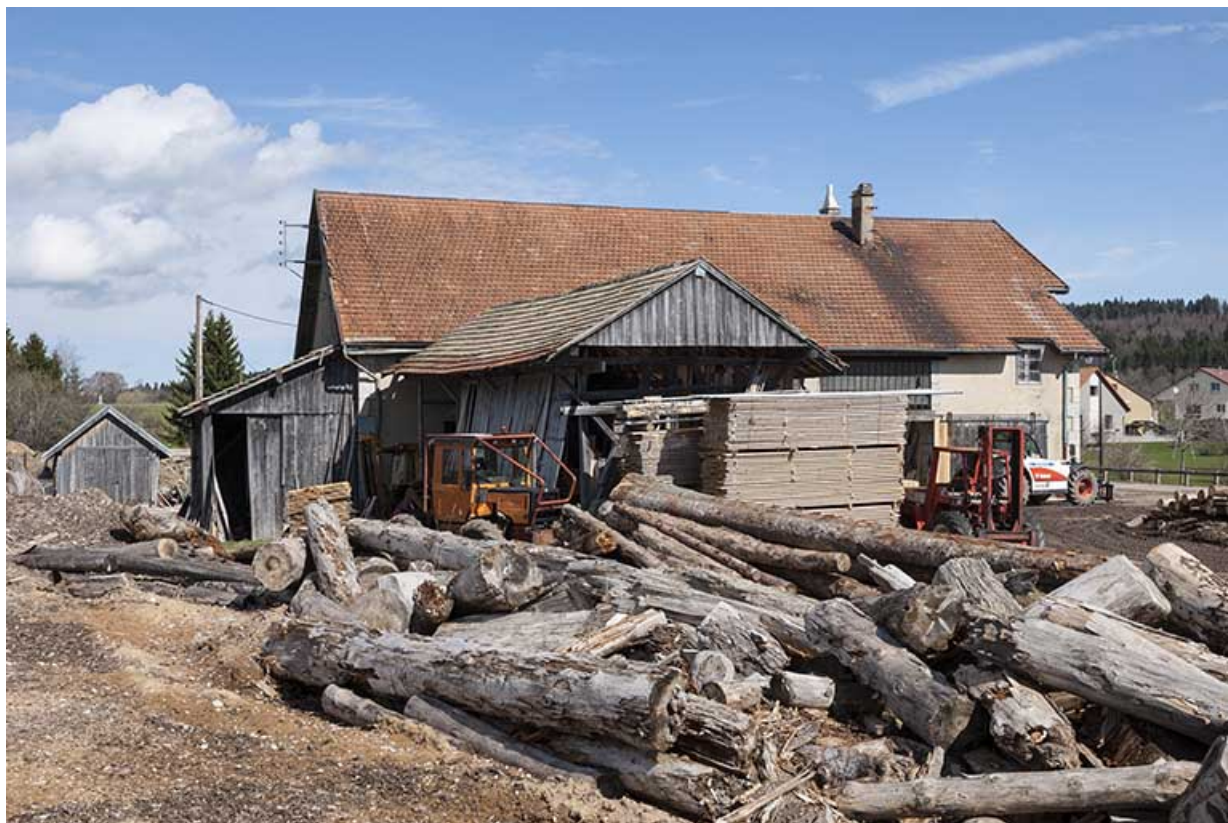
Vue depuis le sud.
