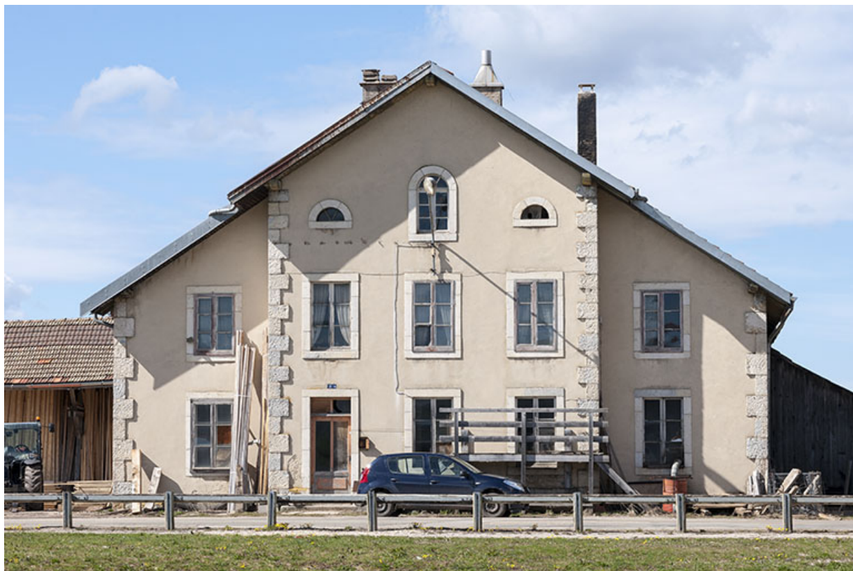
Façade antérieure vue de face.
