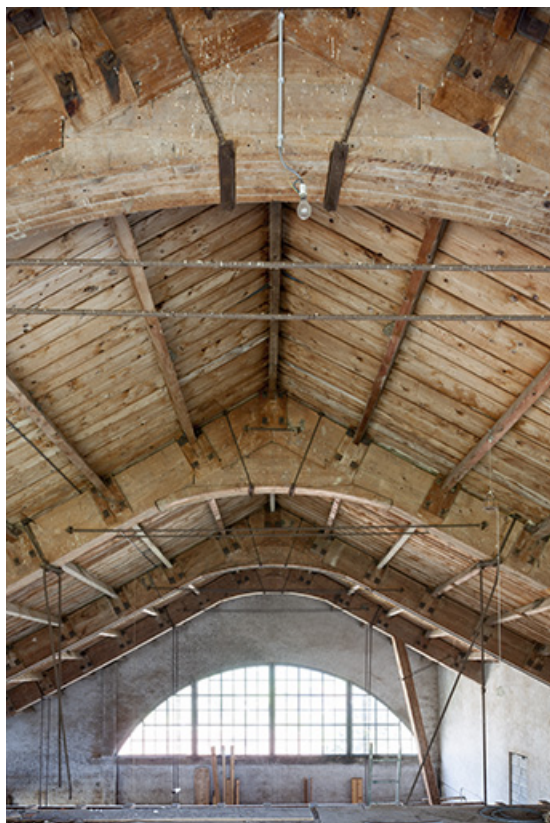
Vue axiale de la charpente, depuis l'ouest.
