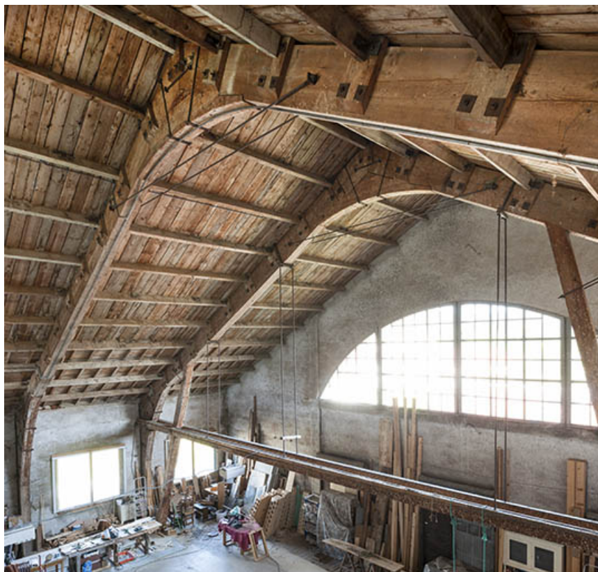
Vue d'ensemble de la charpente.
