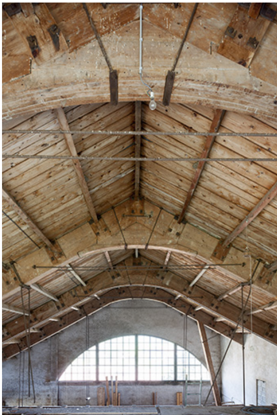
Vue axiale de la charpente, depuis l'ouest.
