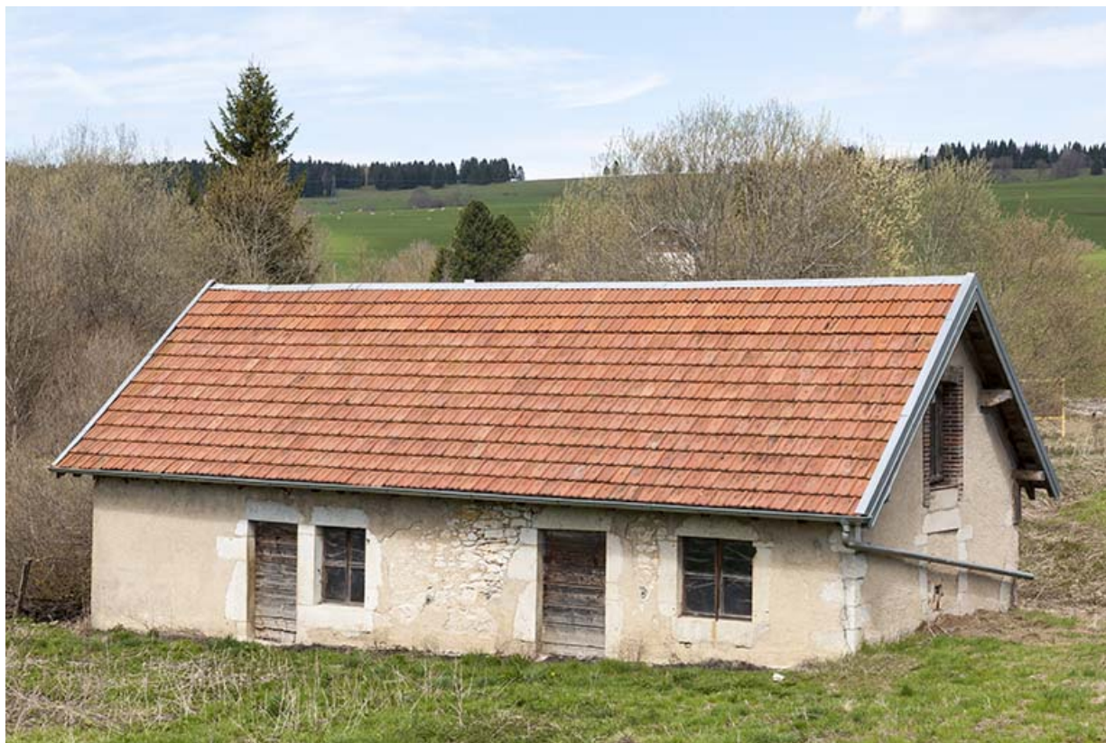
Ancien atelier de forge. Façade sud.
