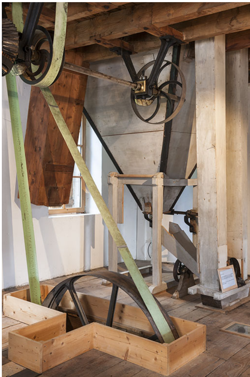
Deuxième étage. Détail du système de transmission par poulies et courroies. 25, Métabief, 36 rue du Village
