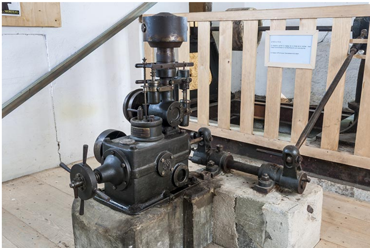
Rez-de-chaussée. Régulateur (SACM) de la turbine Laurent et Collot. 25, Métabief, 36 rue du Village
