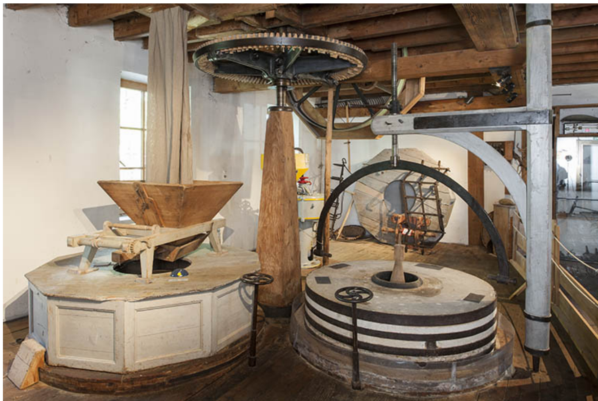
Premier étage. Meules, potence et transmission.
