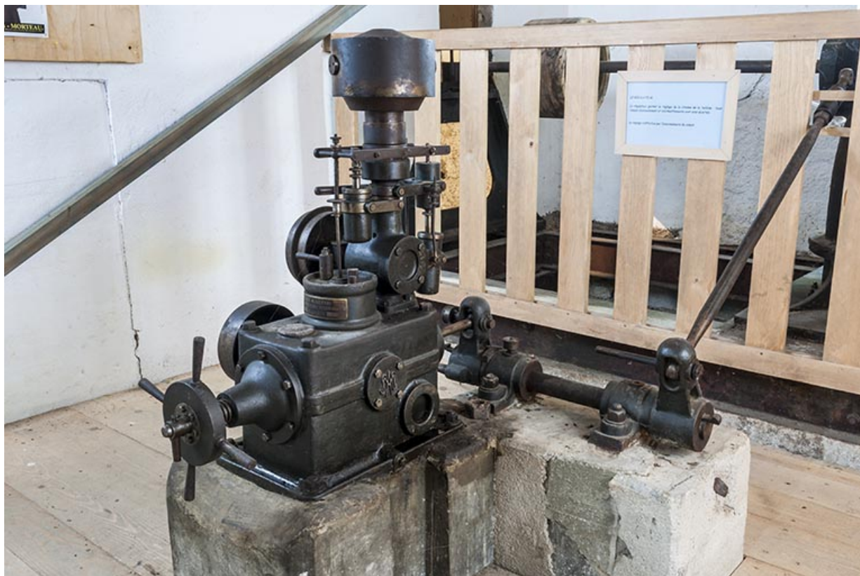
Rez-de-chaussée. Régulateur (SACM) de la turbine Laurent et Collot. 25, Métabief, 36 rue du Village
