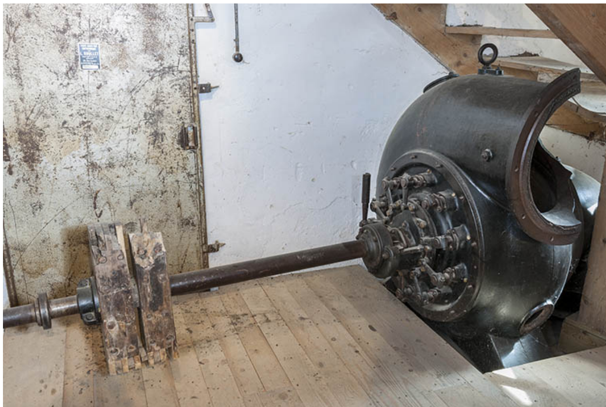
Fragment de la turbine de la scierie (déplacée).
