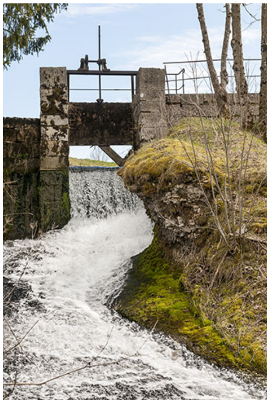
Vanne de décharge sur le Bief Rouge.
