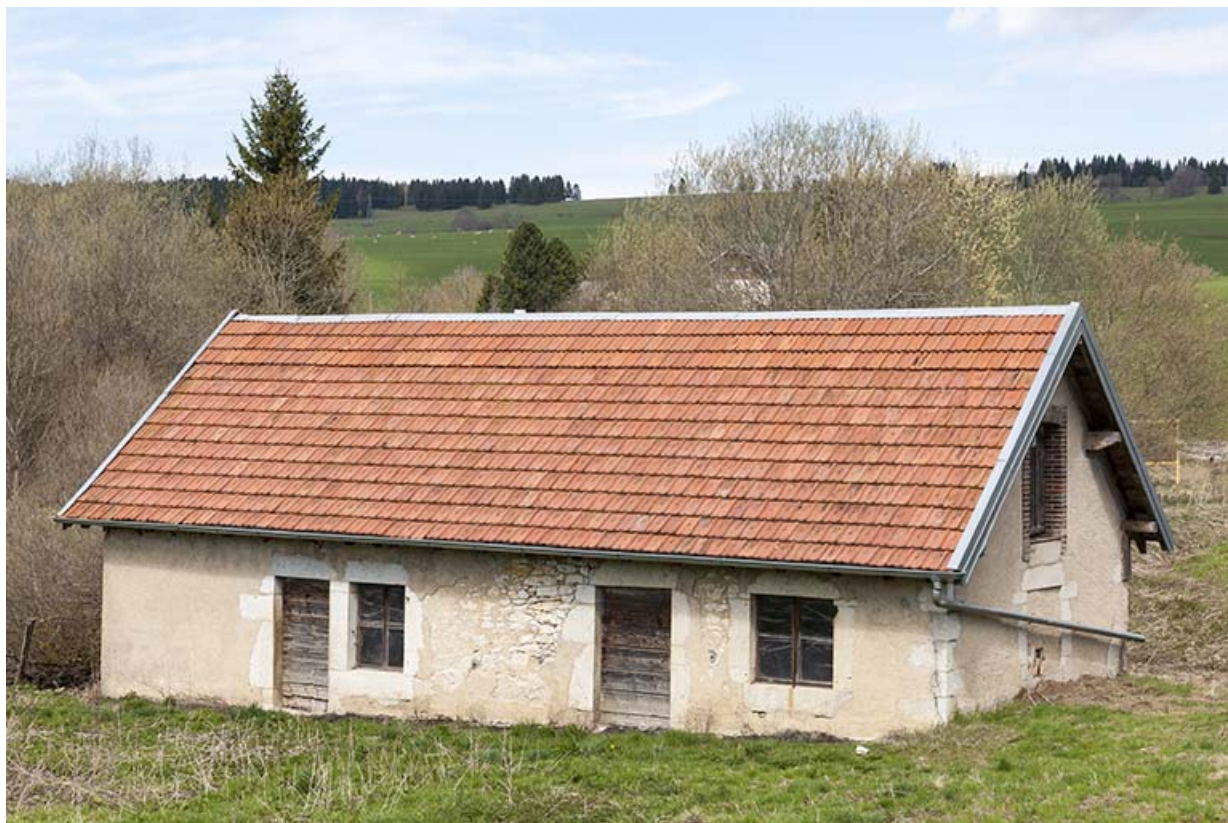
Ancien atelier de forge. Façade sud.
