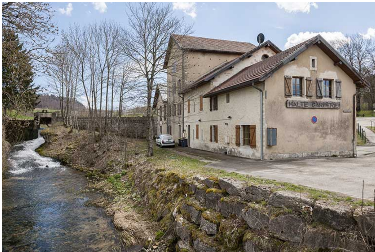
Vue depuis l'ouest : le Bief Rouge et le moulin.
