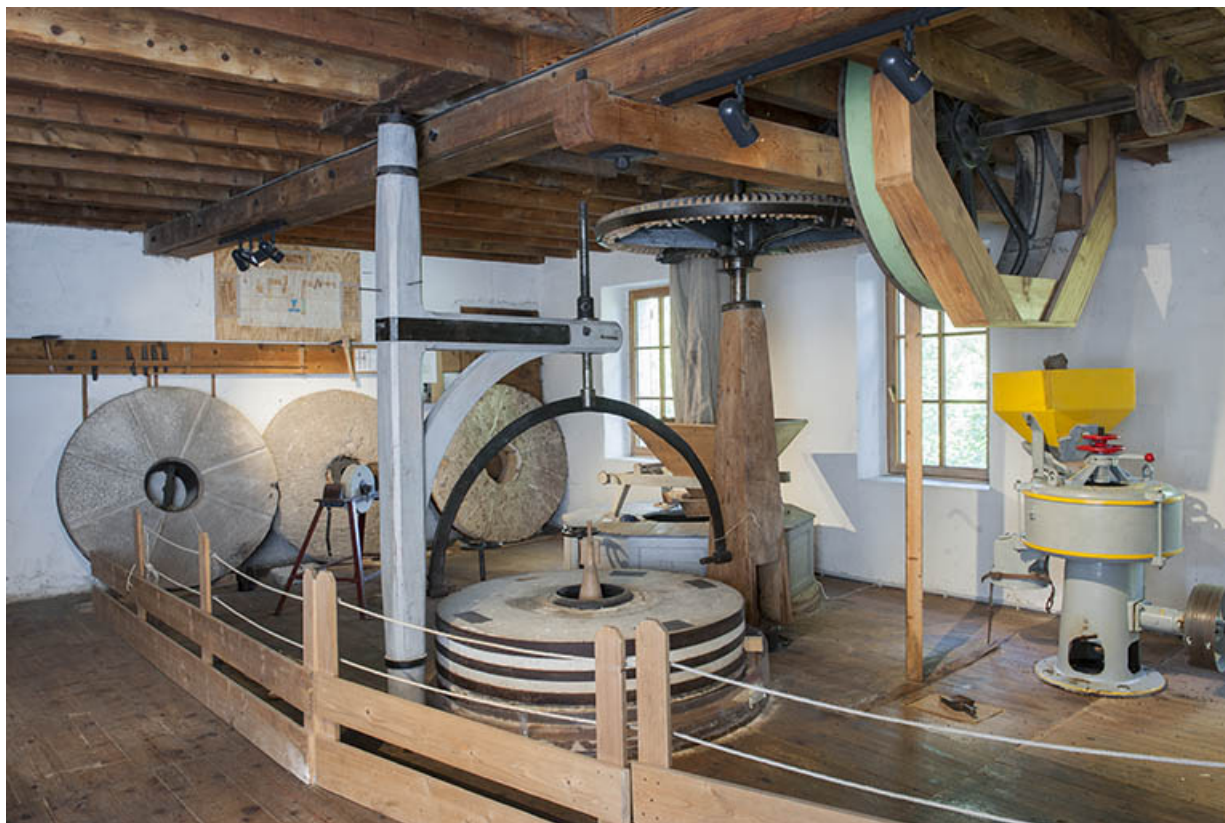
Premier étage. Vue d'ensemble depuis le nord-est. 25, Métabief, 36 rue du Village
