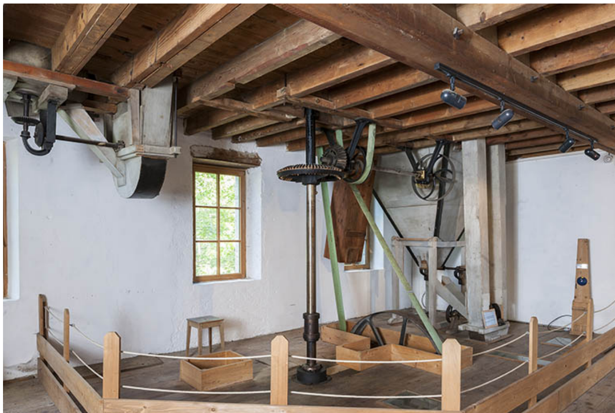
Deuxième étage. Vue d'ensemble.
