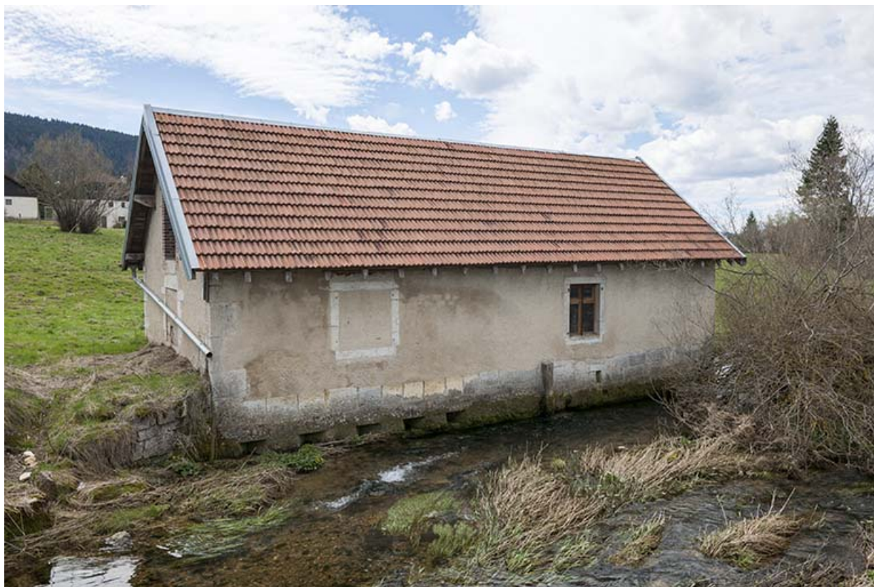
Ancienne forge. Façade nord. 25, Métabief, 36 rue du Village
