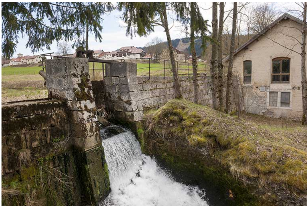
Vue depuis le nord. Vanne de décharge et pignon de l'atelier de scierie. 25, Métabief, 36 rue du Village
