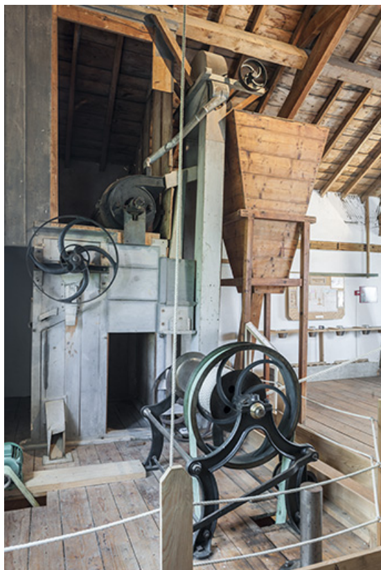
Deuxième étage. Silo, trémie et treuil du monte-sac. 25, Métabief, 36 rue du Village
