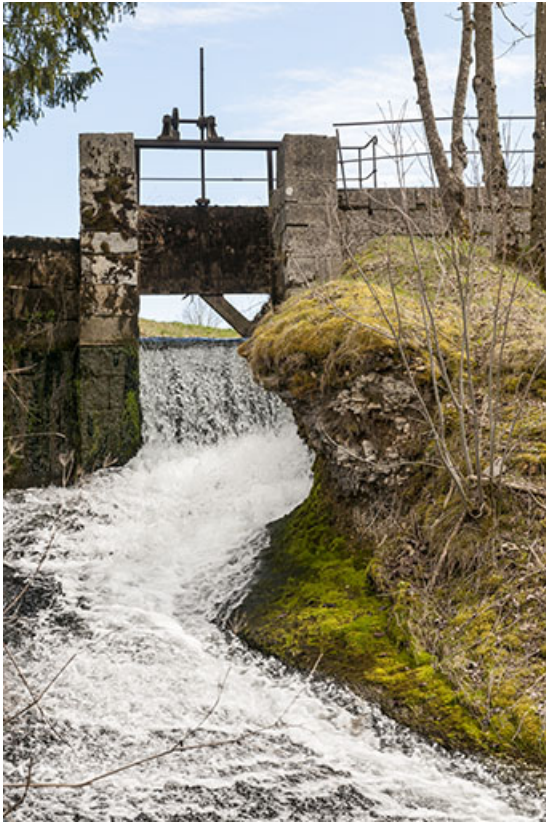
Vanne de décharge sur le Bief Rouge.
