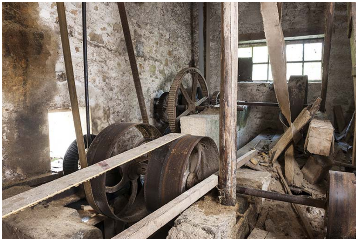
Etage de soubassement. Axe de transmission de la turbine et poulies de renvoi. 25, Chapelle-des-Bois, lieudit : Les Mortes
