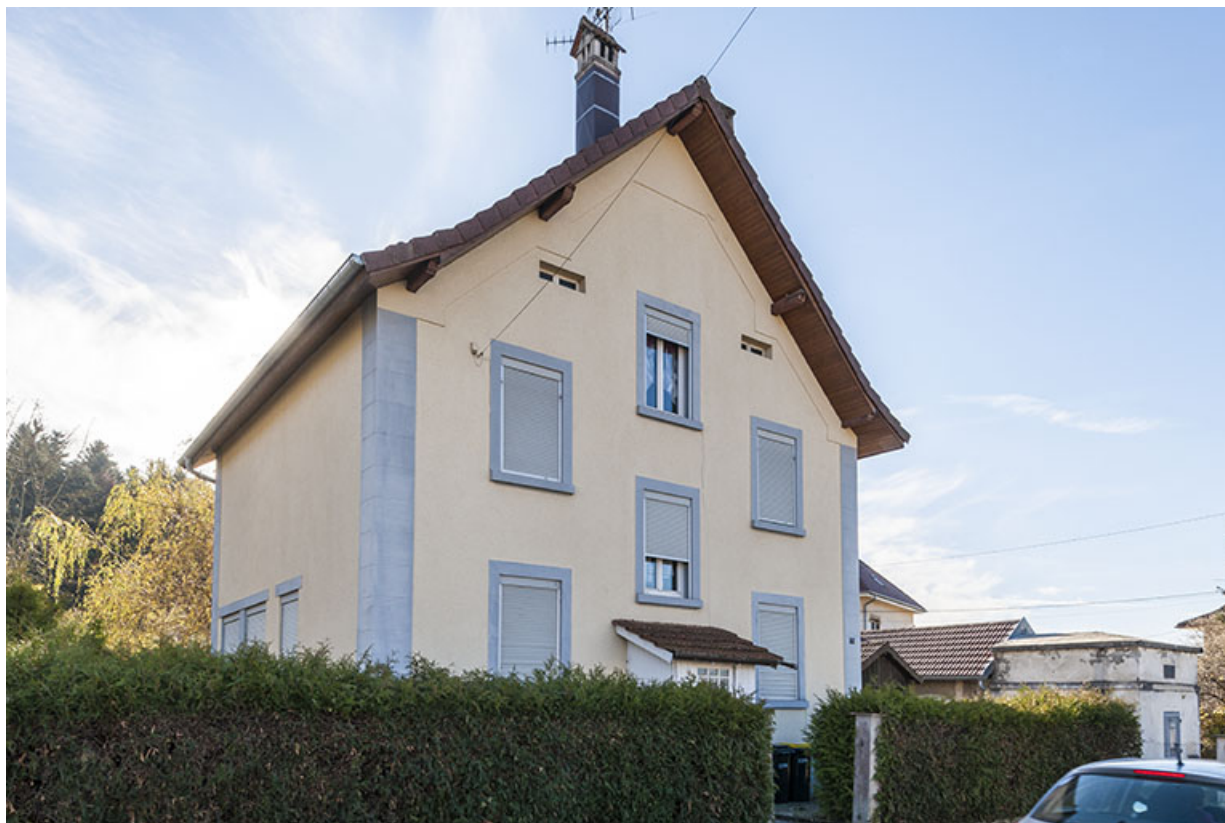
Façades antérieure et latérale gauche.
