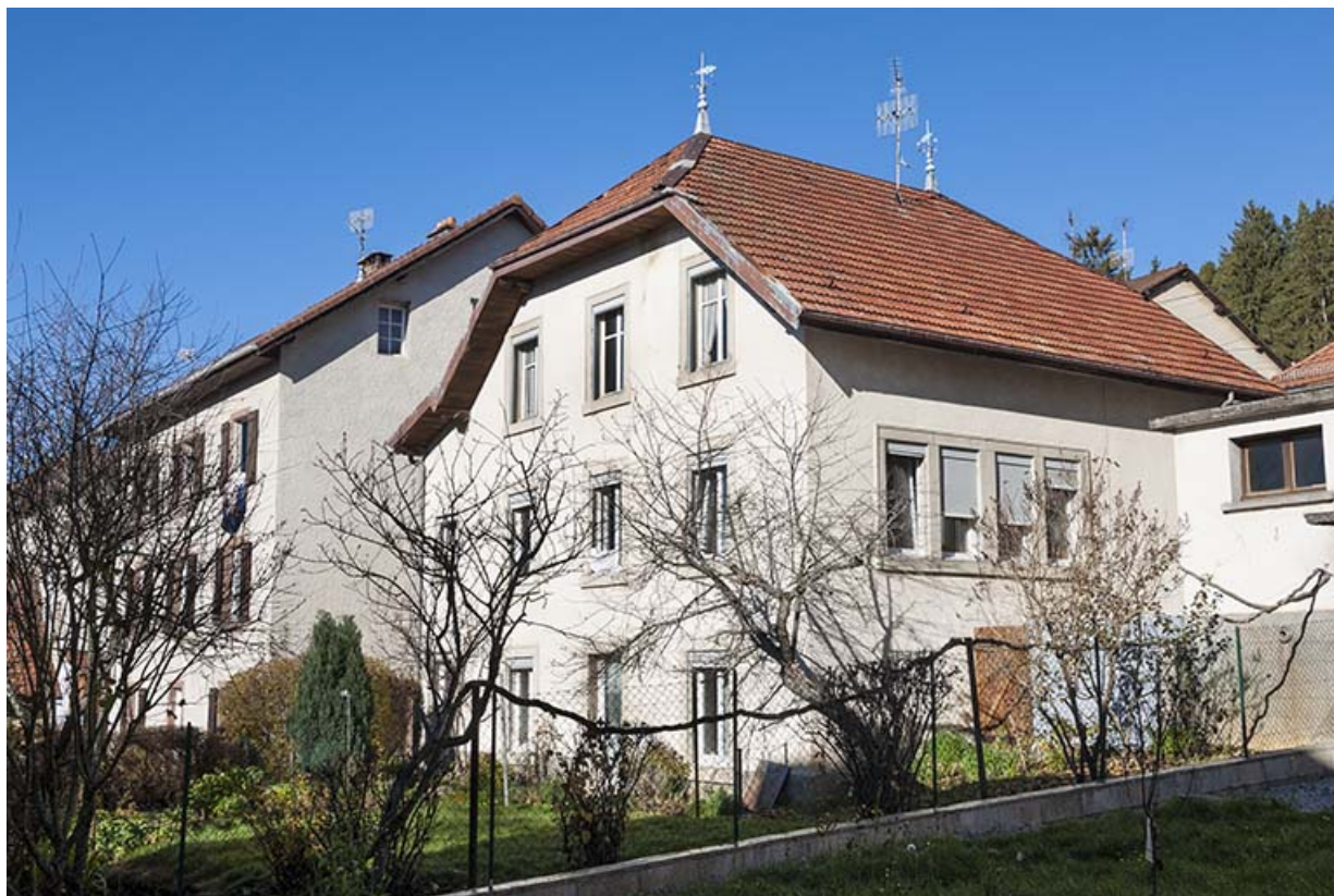
Façades postérieure et latérale gauche.
