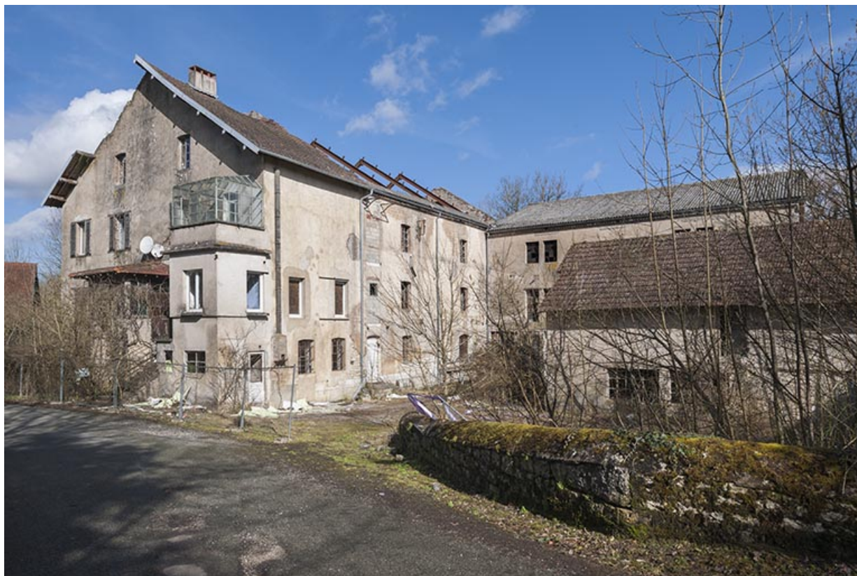
Vue d'ensemble depuis la rue du Canal.
