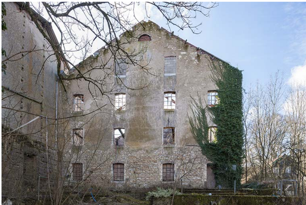
Pignon nord de l'atelier de minoterie.
