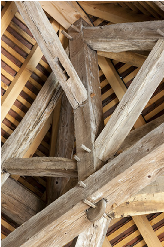
Assemblage de la ferme de la croupe. Détail. 25, Vaire-le-Petit chemin de Roche
