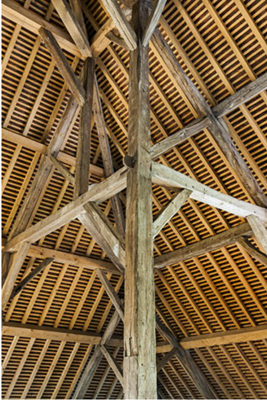
Charpente du séchoir. Détail de la croupe.
