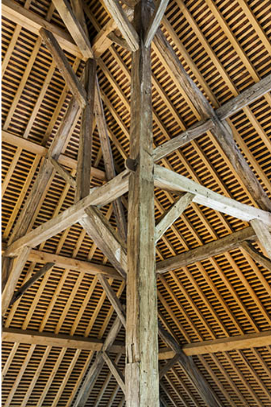
Charpente du séchoir. Détail de la croupe.
