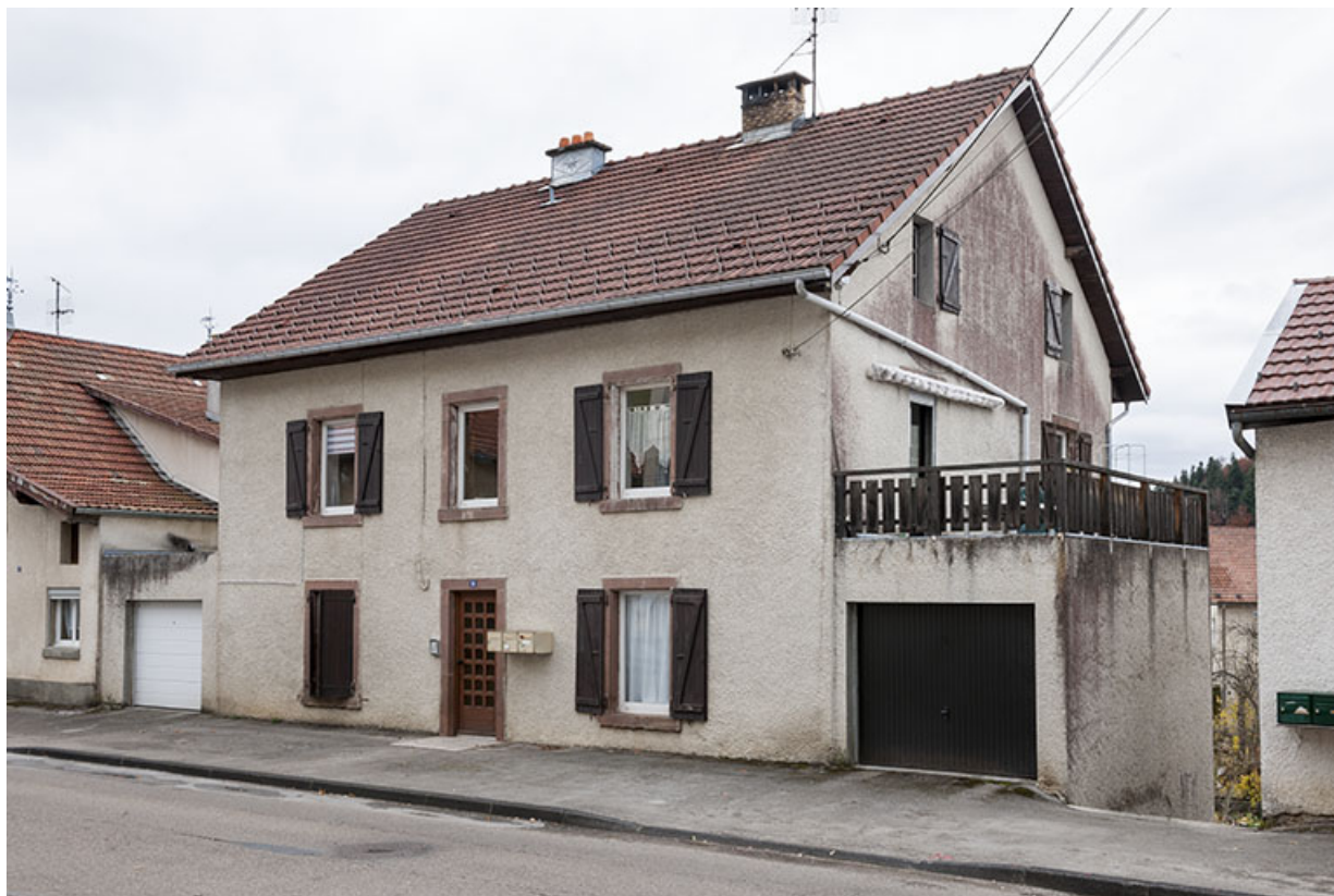
Façades antérieure et latérale droite.
