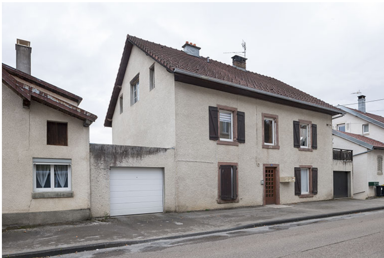
Façades antérieure et latérale gauche.
