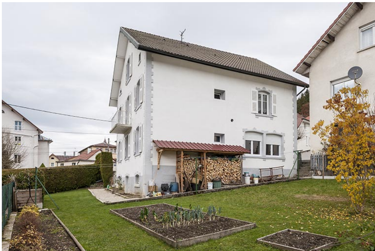
Façade postérieure, de trois quarts gauche.
