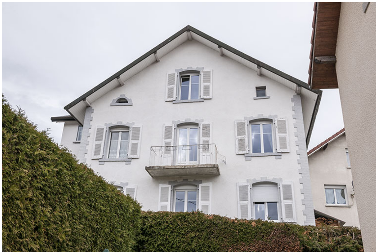
Façade latérale droite, vue en contre-plongée.
