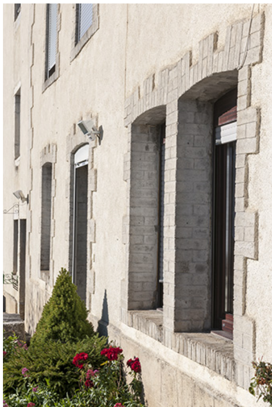
Atelier : fenêtre horlogère de la façade antérieure, vue en enfilade. 25, Maîche, 15 rue Saint-Michel
