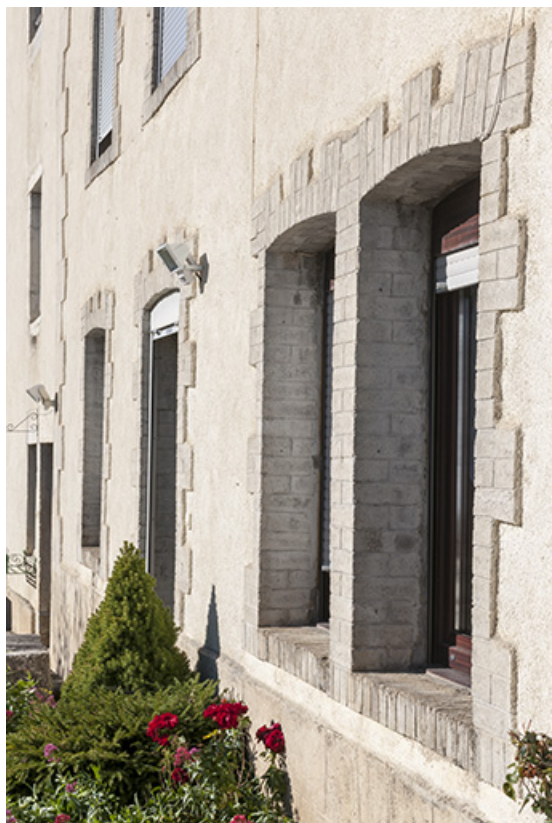
Atelier : fenêtre horlogère de la façade antérieure, vue en enfilade. 25, Maîche, 15 rue Saint-Michel
