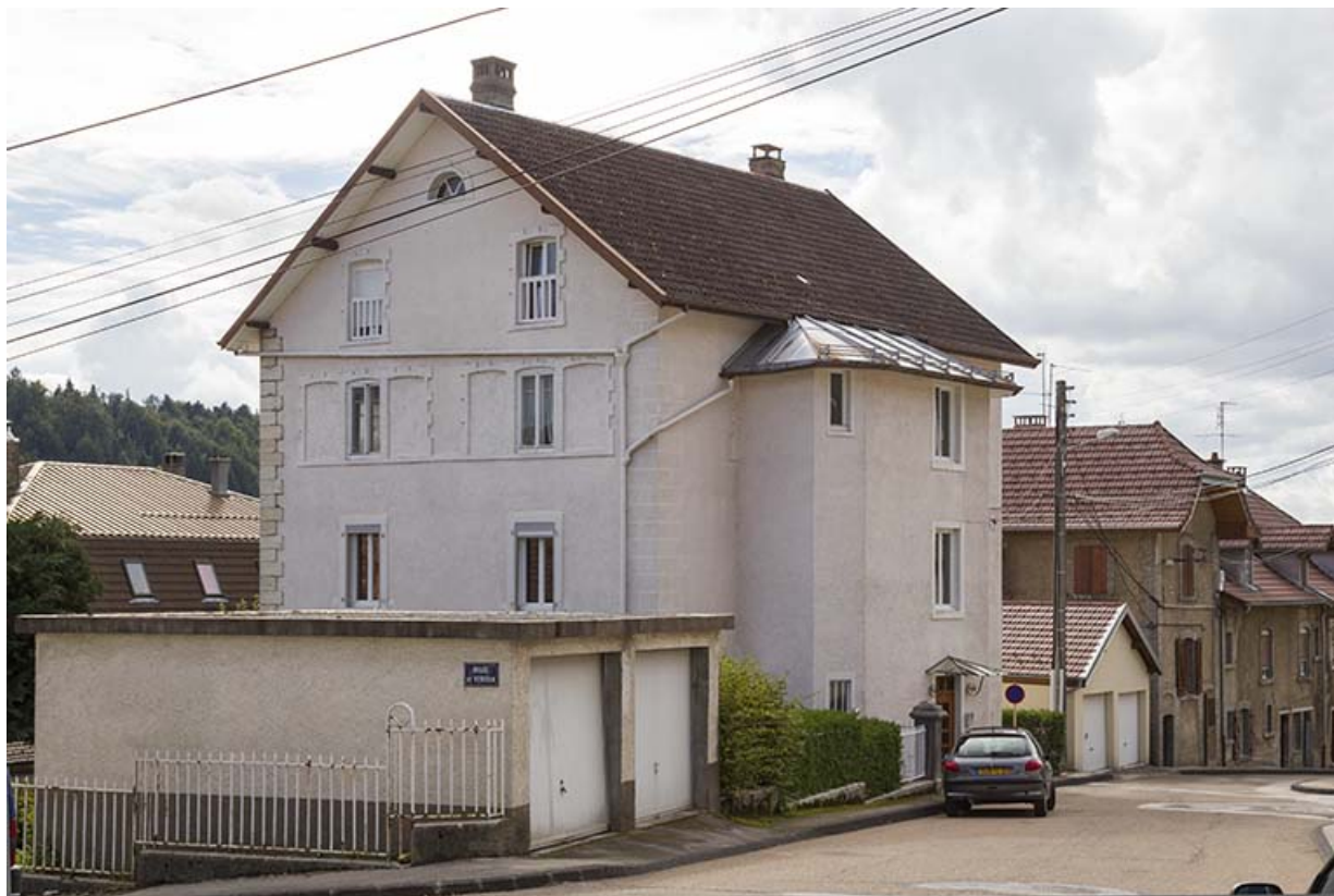
Façades antérieure et latérale gauche.
