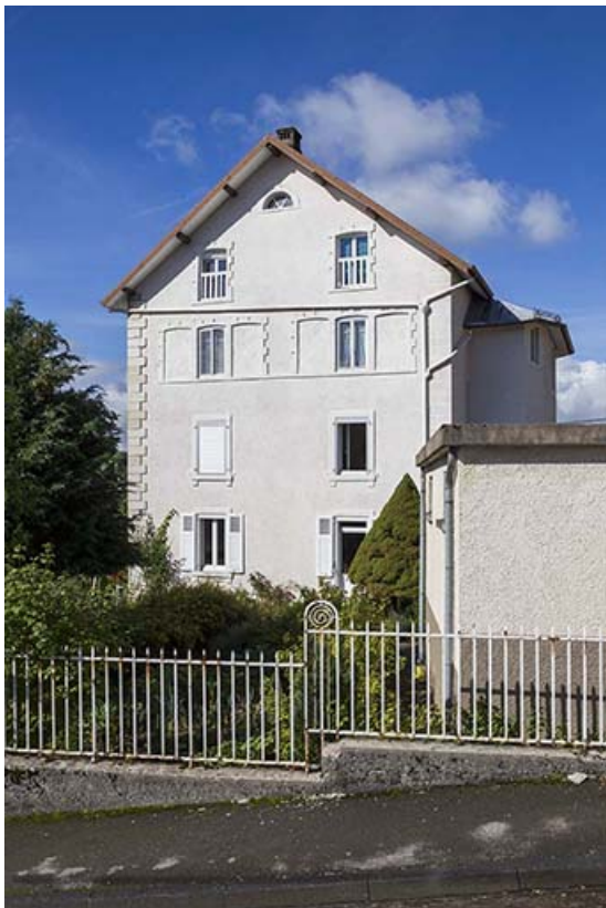
Les Mauvais, une famille d'horlogers entreprenants : l'immeuble de Paul (vers 1900) et son atelier, au 10 rue du Mont. 25, Maîche, 10 rue du Mont
