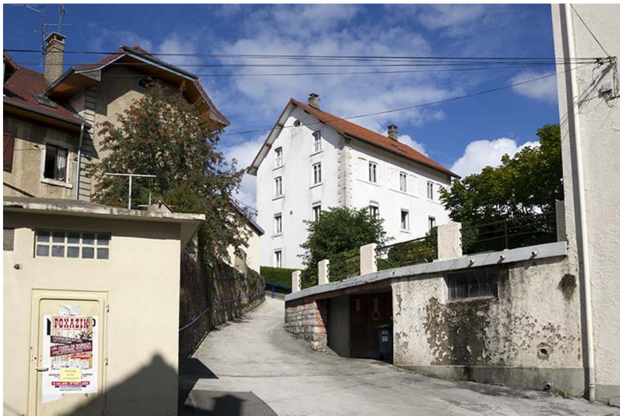
Façades postérieure et latérale droite.
