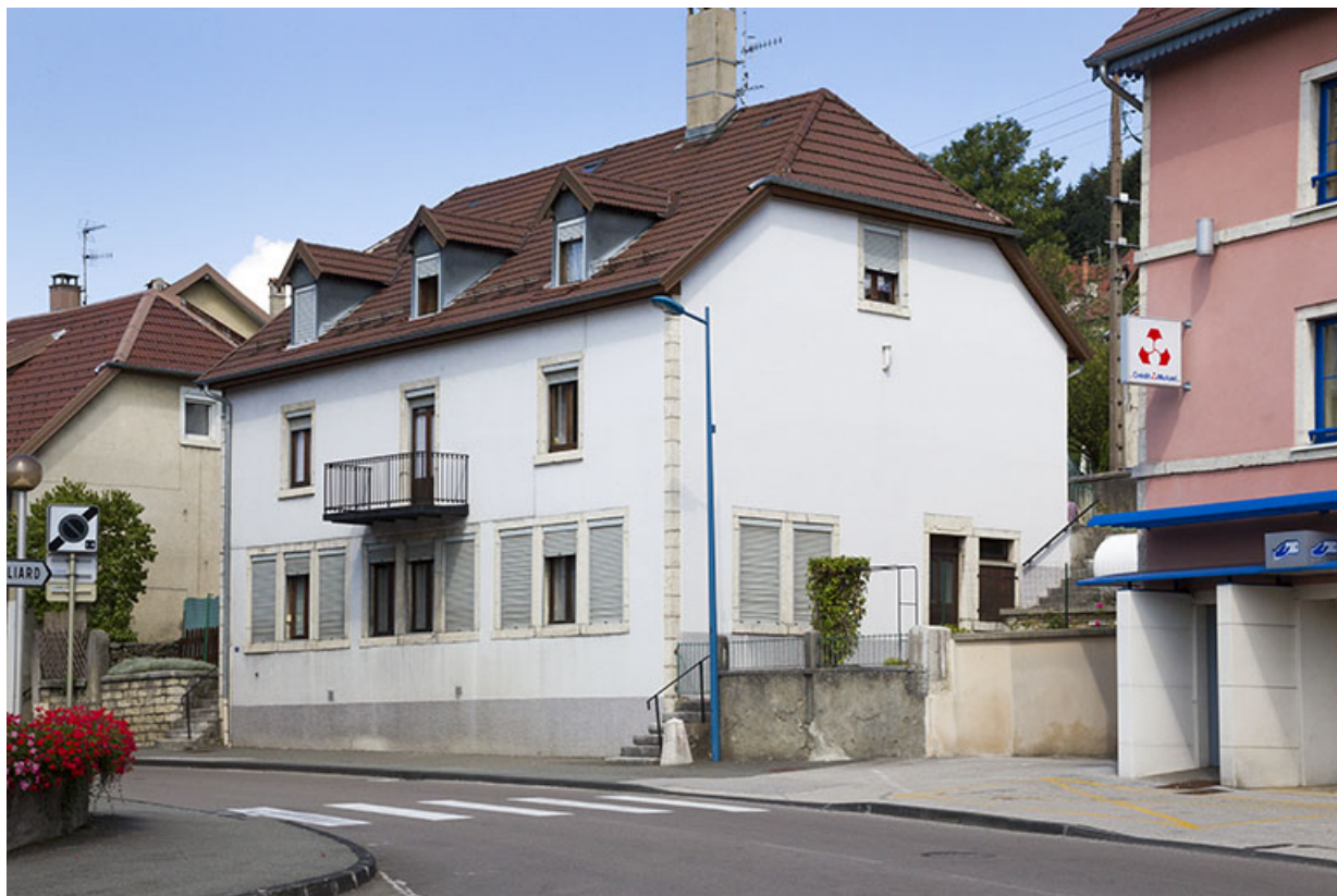
Réutilisation d'un bâtiment existant (1866) : la fabrique d'échappements à cylindre Delacour Frères, au 4 rue de Saint-Hippolyte. 25, Maîche
