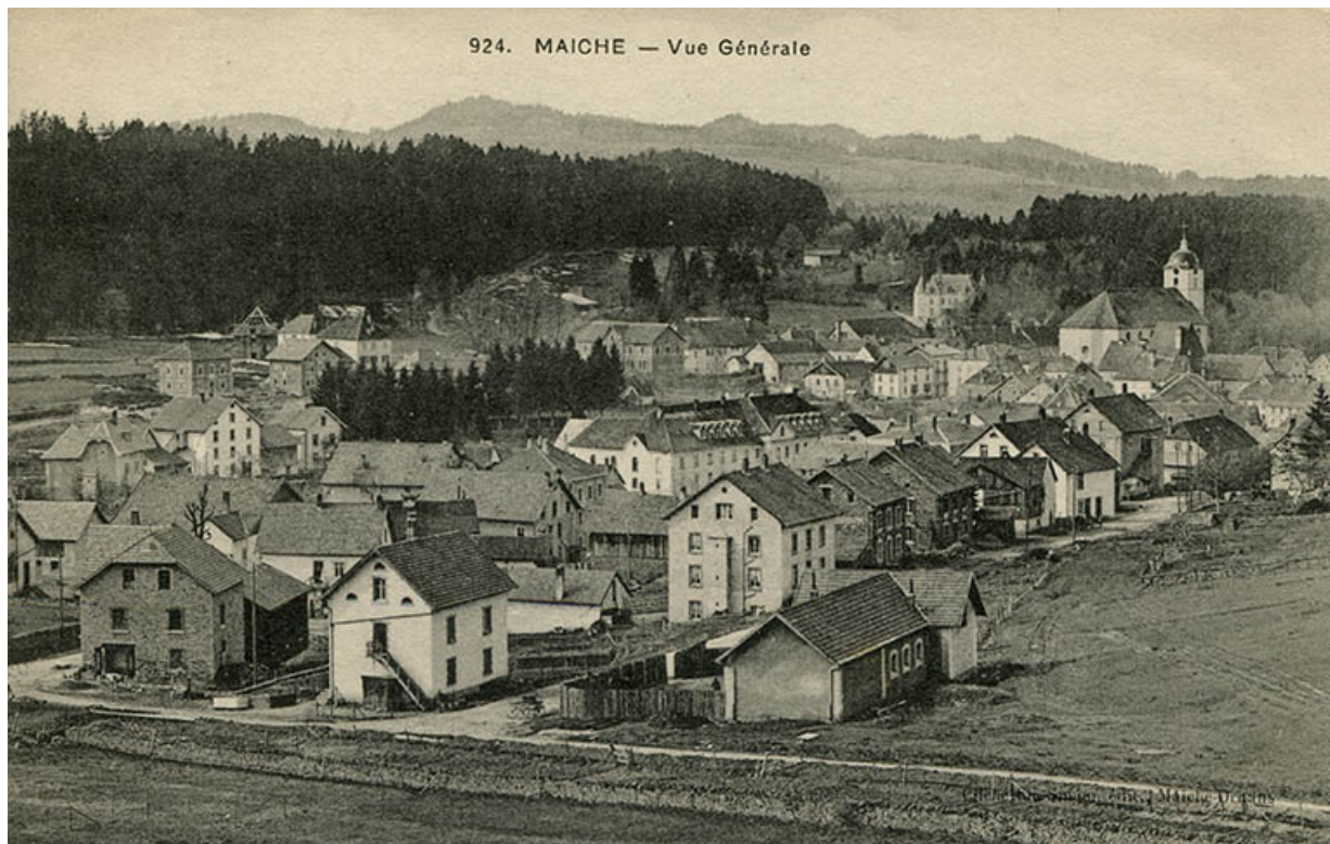
924. Maïche - Vue générale [à l'angle des rues de Goule et du Mont], vers 1911. Le bâtiment est visible à gauche. 25, Maïche, 29 rue du Mont-Miroir
