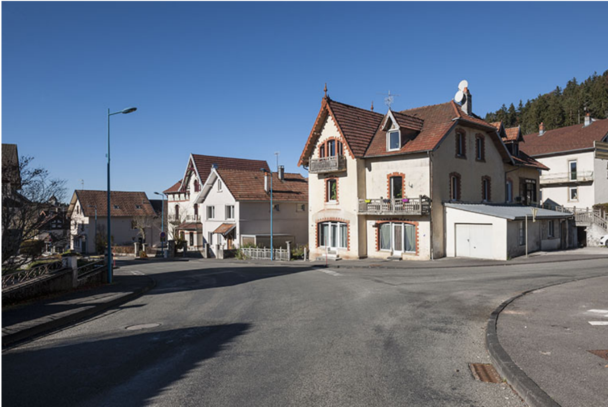
La rue du Mont-Miroir, à son carrefour avec la rue de Goule. De droite à gauche : maison et café Grux puis atelier de l'horloger Amédée Mairot (au n° 29), usine d'assortiments à cylindre de Paul et Robert Mauvais (au n° 27) et villa de l'architecte Langlois puis de Paul Mauvais (au n° 25).
