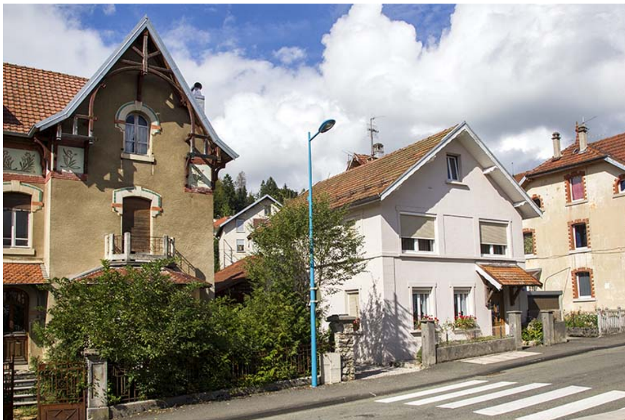
Vue d'ensemble depuis le sud-ouest, avant rénovation de la maison. 25, Maîche, 25 et 27 rue du Mont-Miroir
