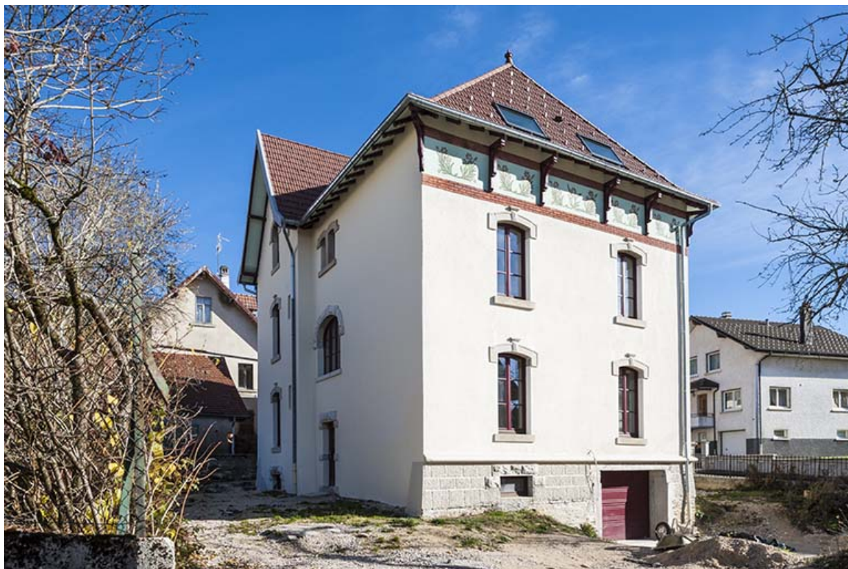
Maison : façades postérieure et latérale gauche.
