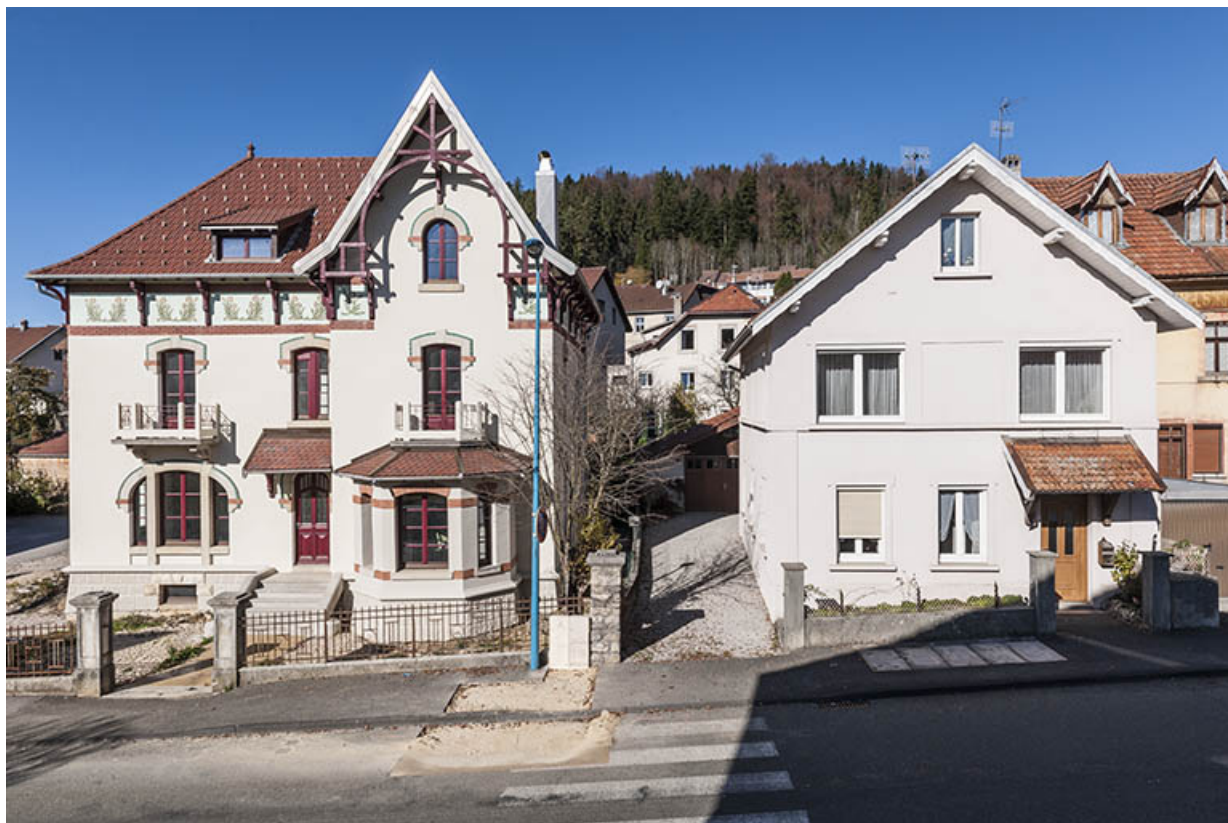
Les Mauvais, une famille d'horlogers entrepreneurs : rue du Mont-Miroir, la villa de Paul (vers 1913) au n° 27 et son usine (vers 1932-1935) au n° 29.
