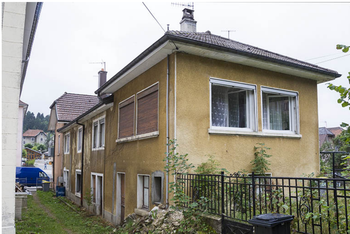
Atelier au 3 rue du Bélvédère et façade orientale. 25, Maîche, 17 et 19 rue Montalembert
