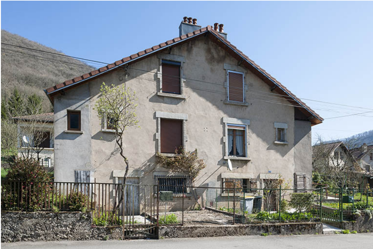
Façade antérieure d'une maison jumelée.
