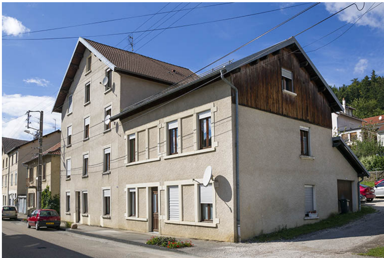
Façades antérieure et latérale droite.
