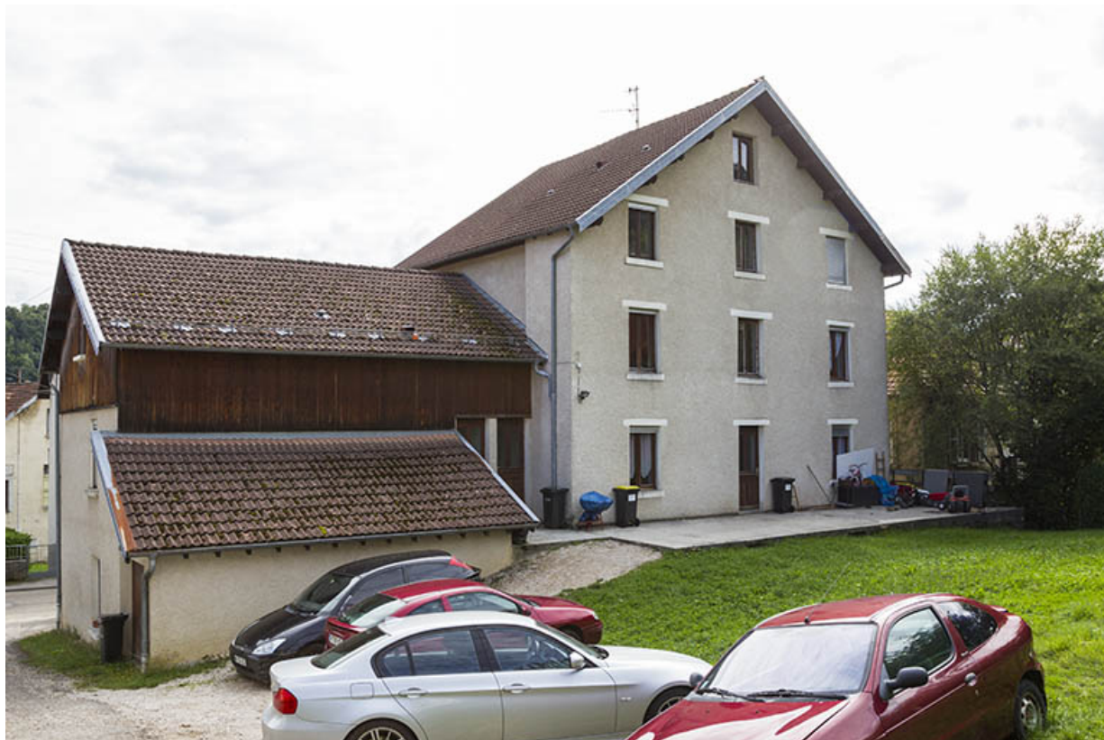
Façades postérieure et latérale droite.
