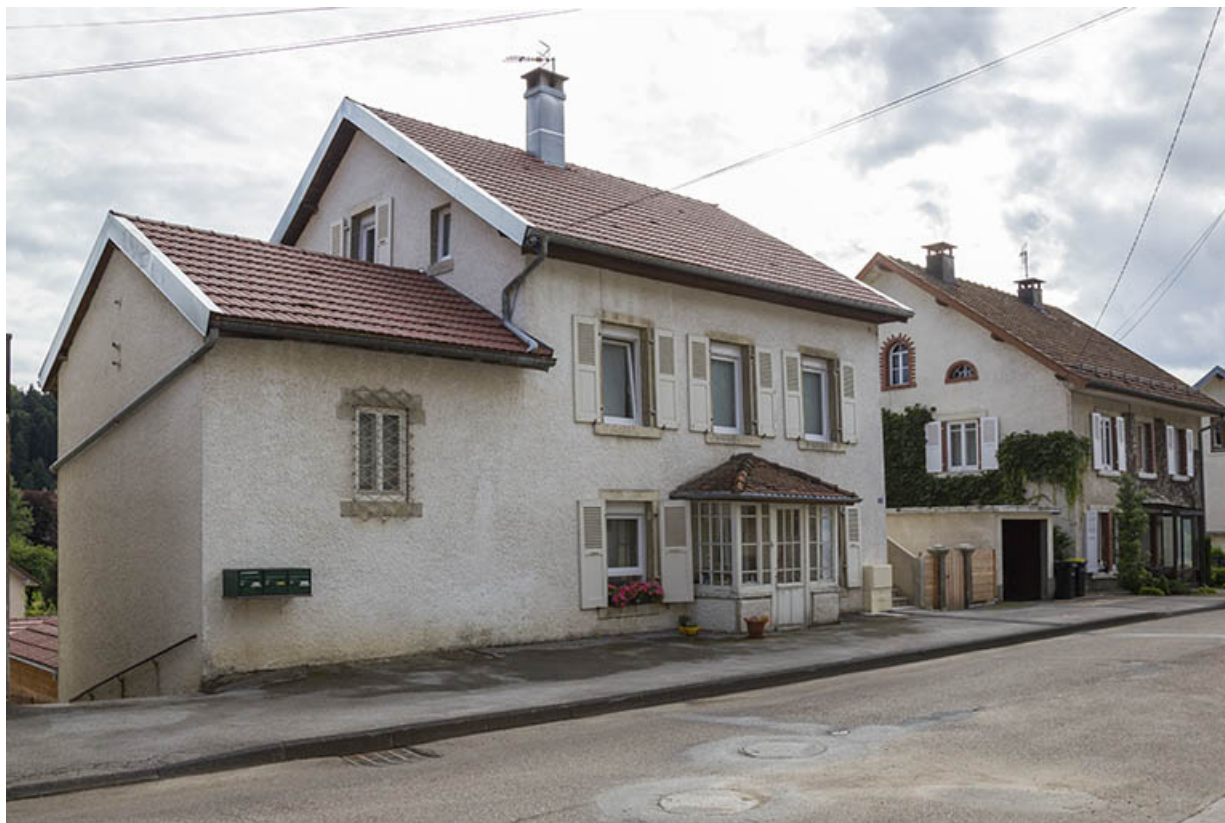
Façades antérieure et latérale gauche.
