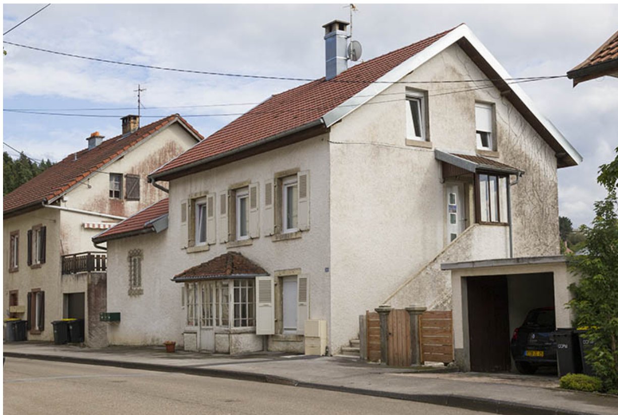
Façades antérieure et latérale droite.
