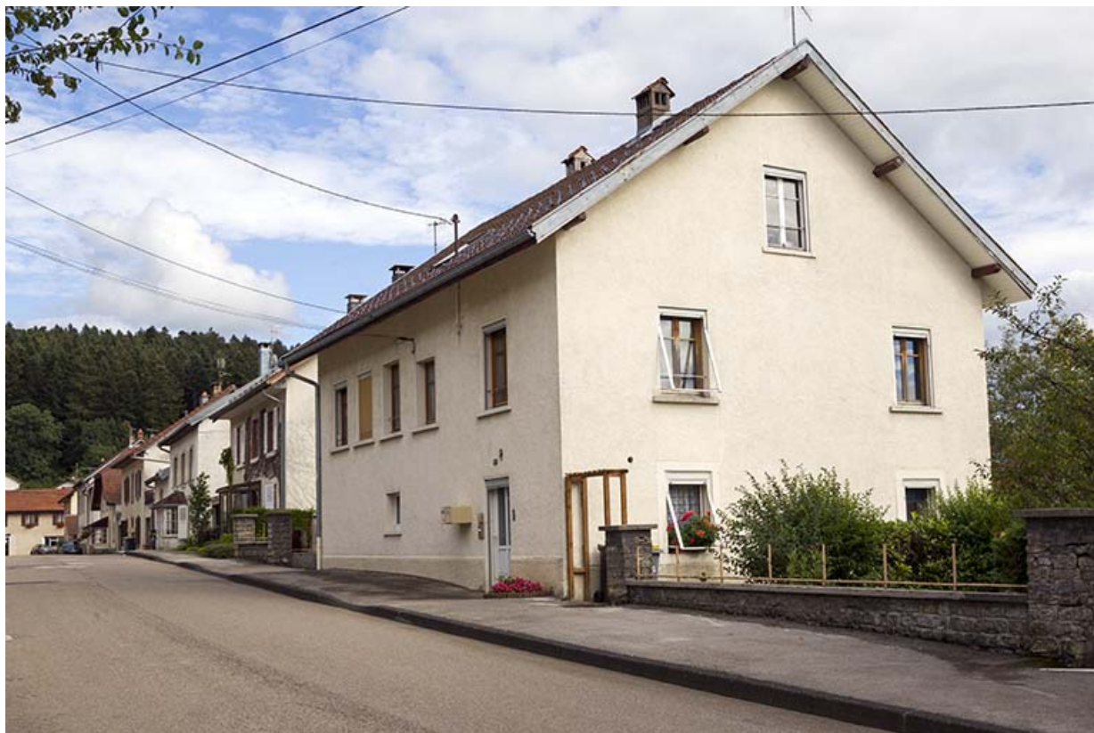
Façades antérieure et latérale droite.
