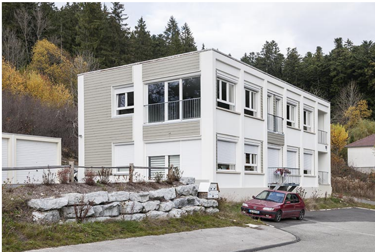
Façades antérieure et latérale gauche, après la transformation en immeuble. 25, Maîche, 13 rue Paul Monnot
