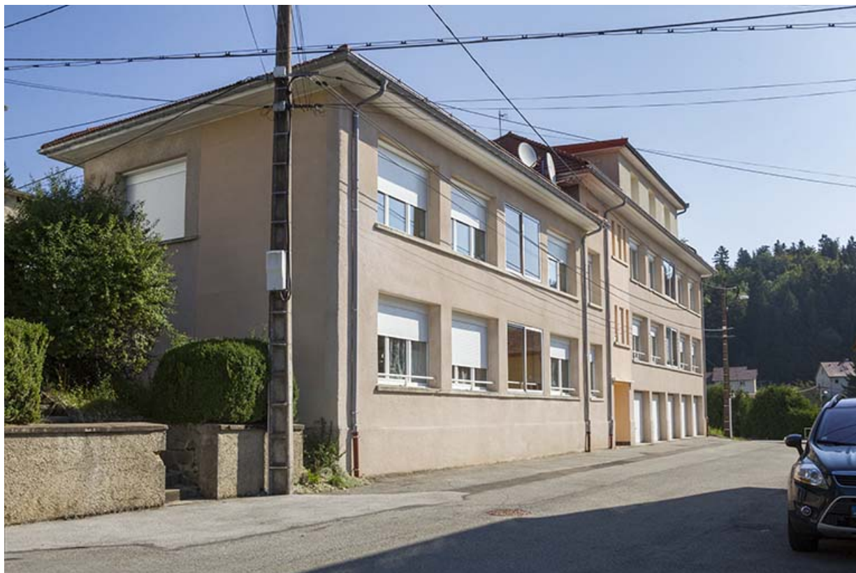
Vue d'ensemble, depuis l'ouest (façades antérieure et latérale gauche). 25, Maîche, 7 rue Paul Monnot
