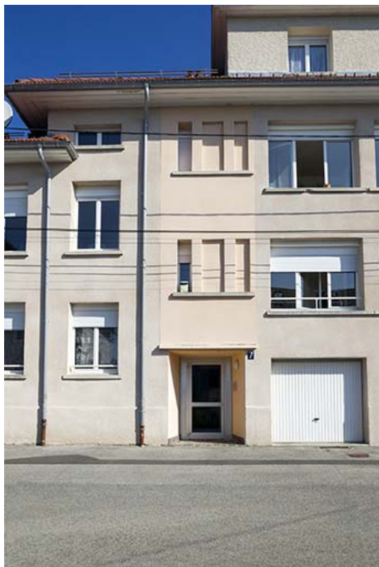
Façade antérieure : entrée.
