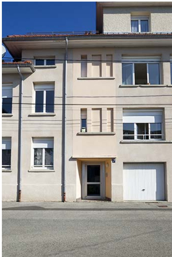
Façade antérieure : entrée.
