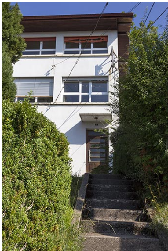
Usine : entrée sur la façade antérieure.
