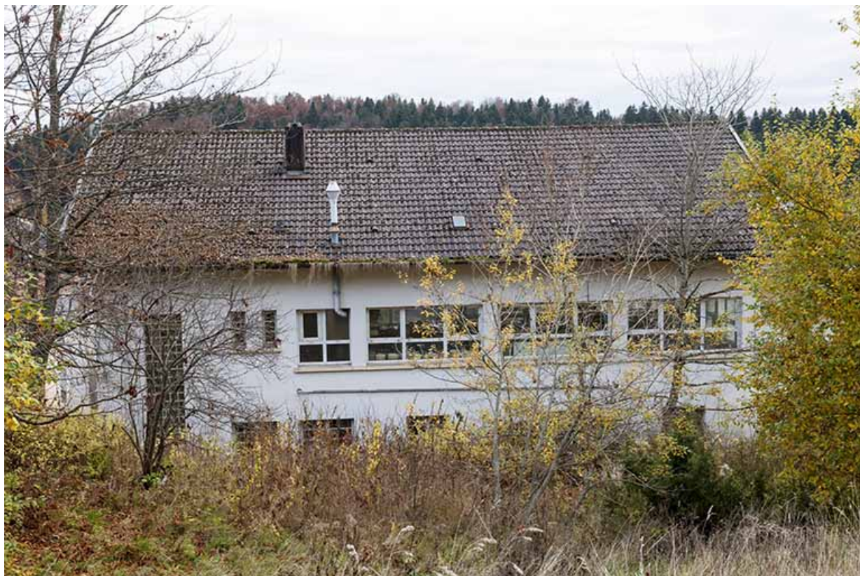
Usine : façade postérieure.
