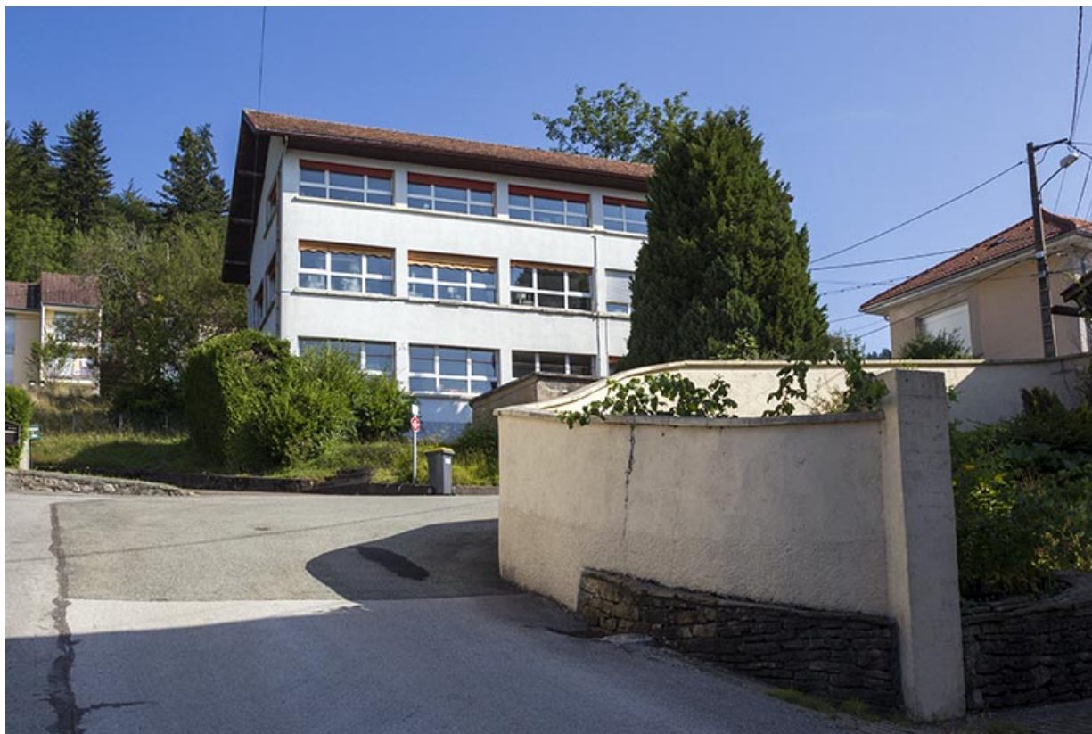
Usine : vue d'ensemble, depuis le sud.
