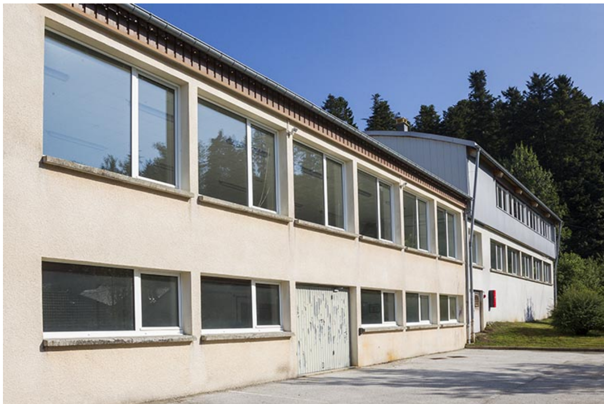
Façade latérale gauche, vue en enfilade.
