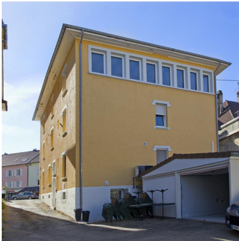
Façades postérieure et latérale droite.
