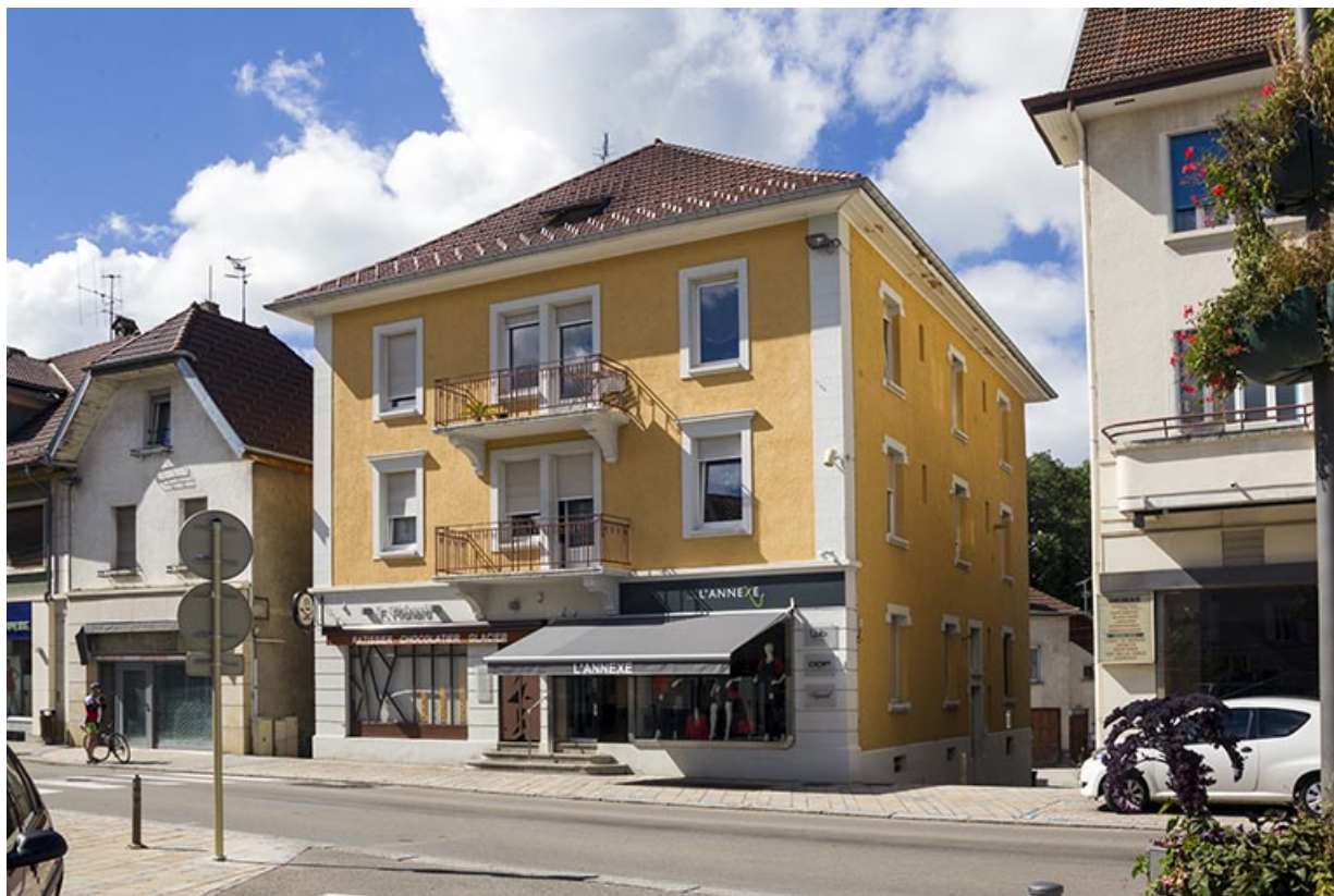
Vue d'ensemble, depuis l'est (façades antérieure et latérale droite). 25, Maîche, 13 rue du Général de Gaulle
