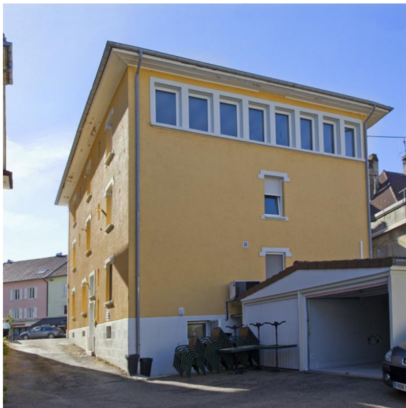
Façades postérieure et latérale droite.
