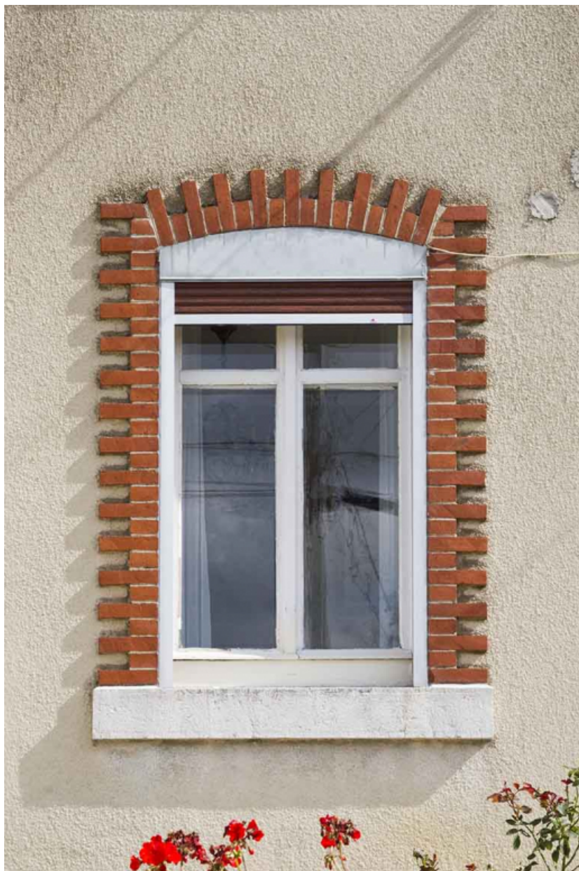
Maison, façade antérieure : fenêtre à encadrement en briques et arc segmentaire. 25, Maîche, 22 rue du Belvédère
