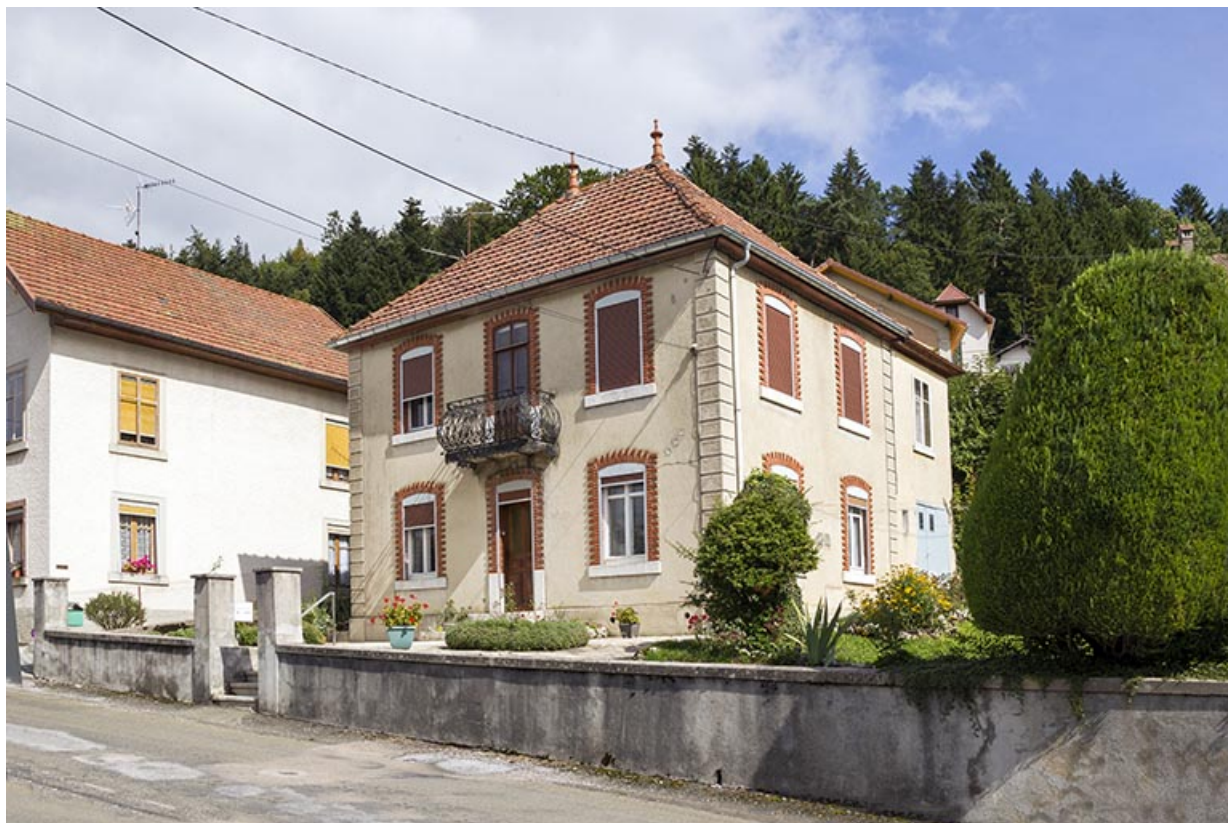
Vue d'ensemble, depuis le sud-ouest (façades antérieure et latérale droite). 25, Maîche
