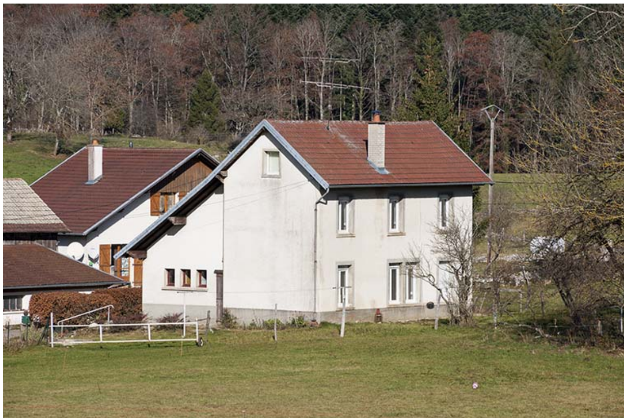
Atelier : façades sud et ouest. L'ancienne fenêtre multiple est visible au rez-de-chaussée. 25, Maîche, lieudit : Grand Vau
