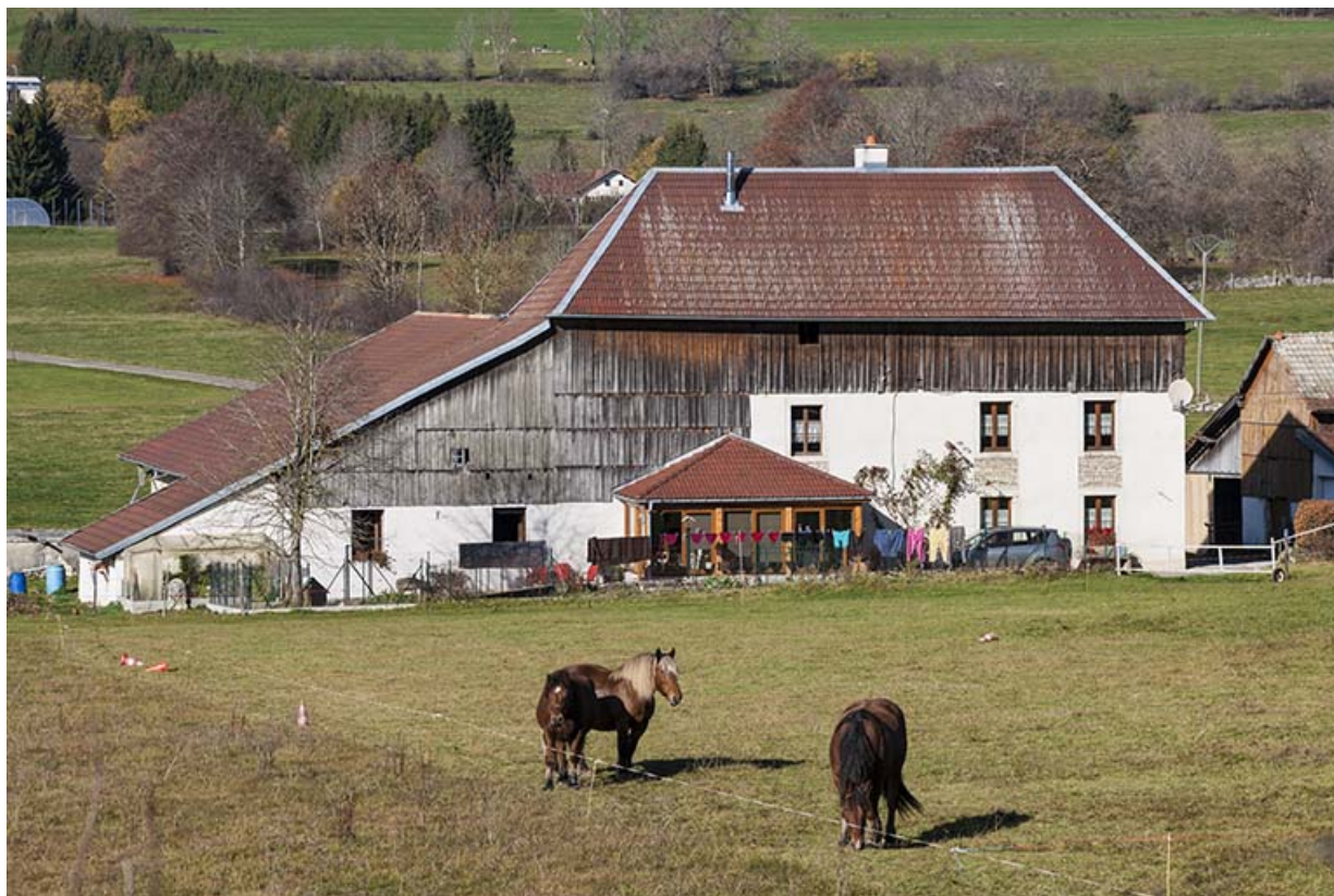
Ferme : façade sud.
