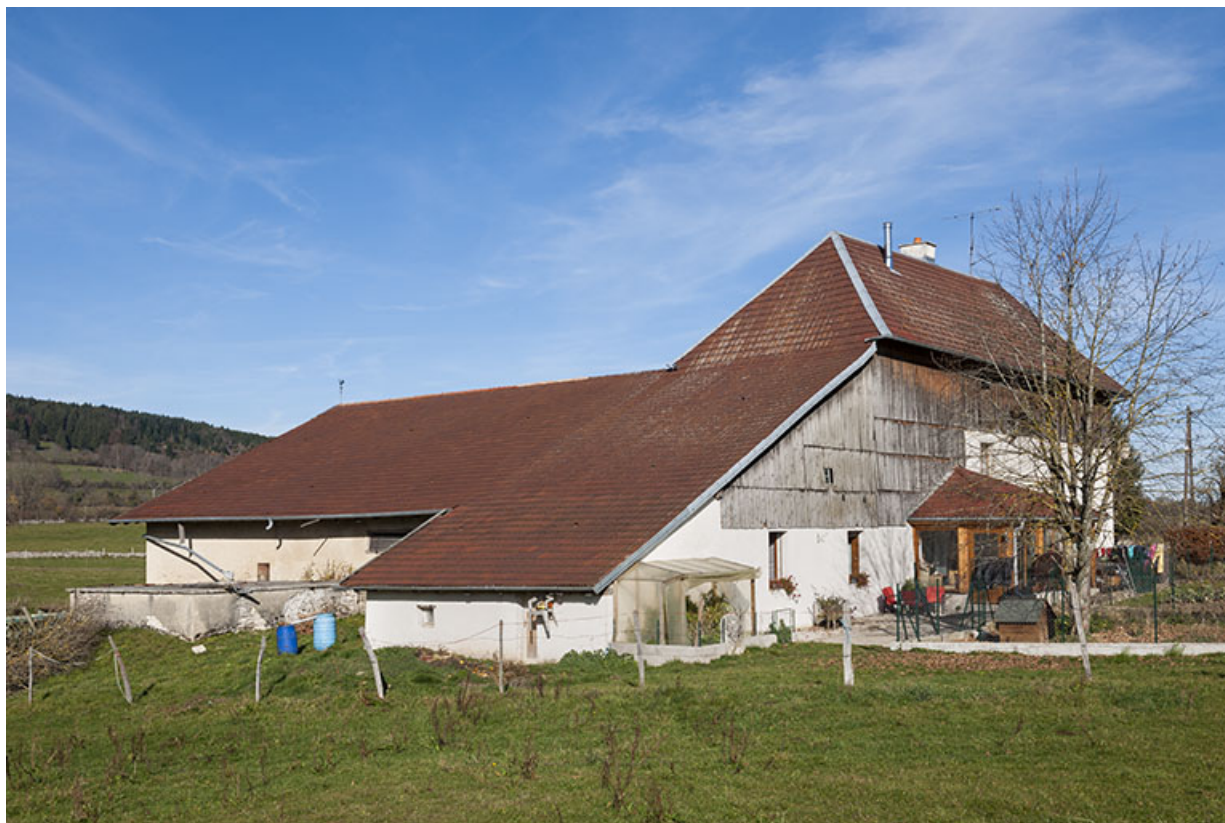
Ferme : façades sud et ouest.
