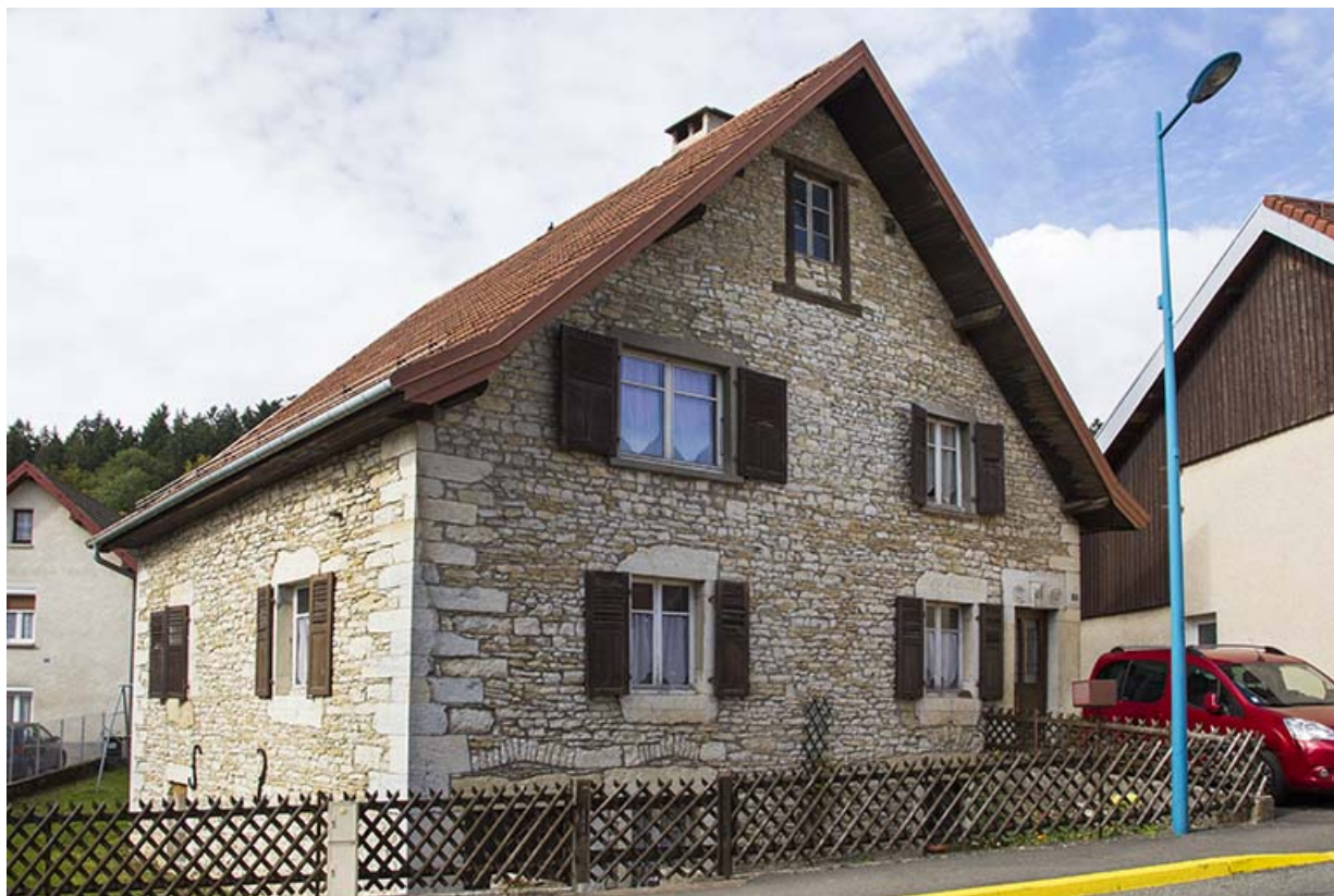
Maison : façades antérieure et latérale gauche.
