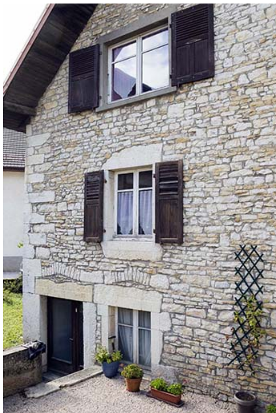
Maison, façade antérieure : accès à l'étage de soubassement. 25, Maîche, 19 rue du Mont Miroir
