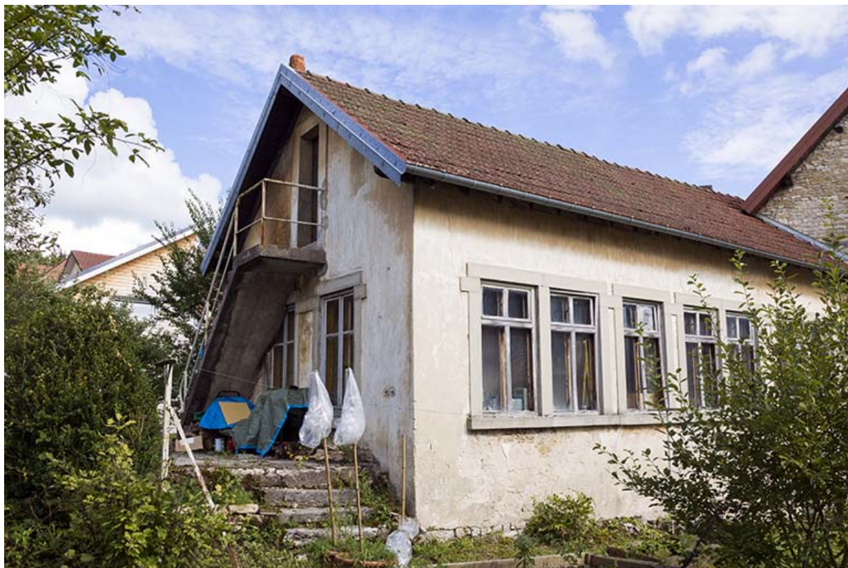
Usine : façades postérieure et latérale droite.
