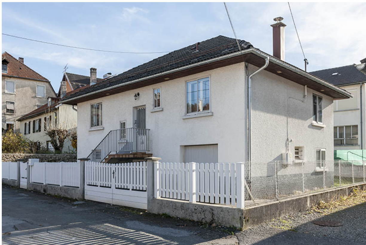
Façades antérieure et latérale droite. L'atelier se trouvait au rez-de-chaussée dans l'angle à droite. 25, Maîche, 1 rue Joseph Aubert
