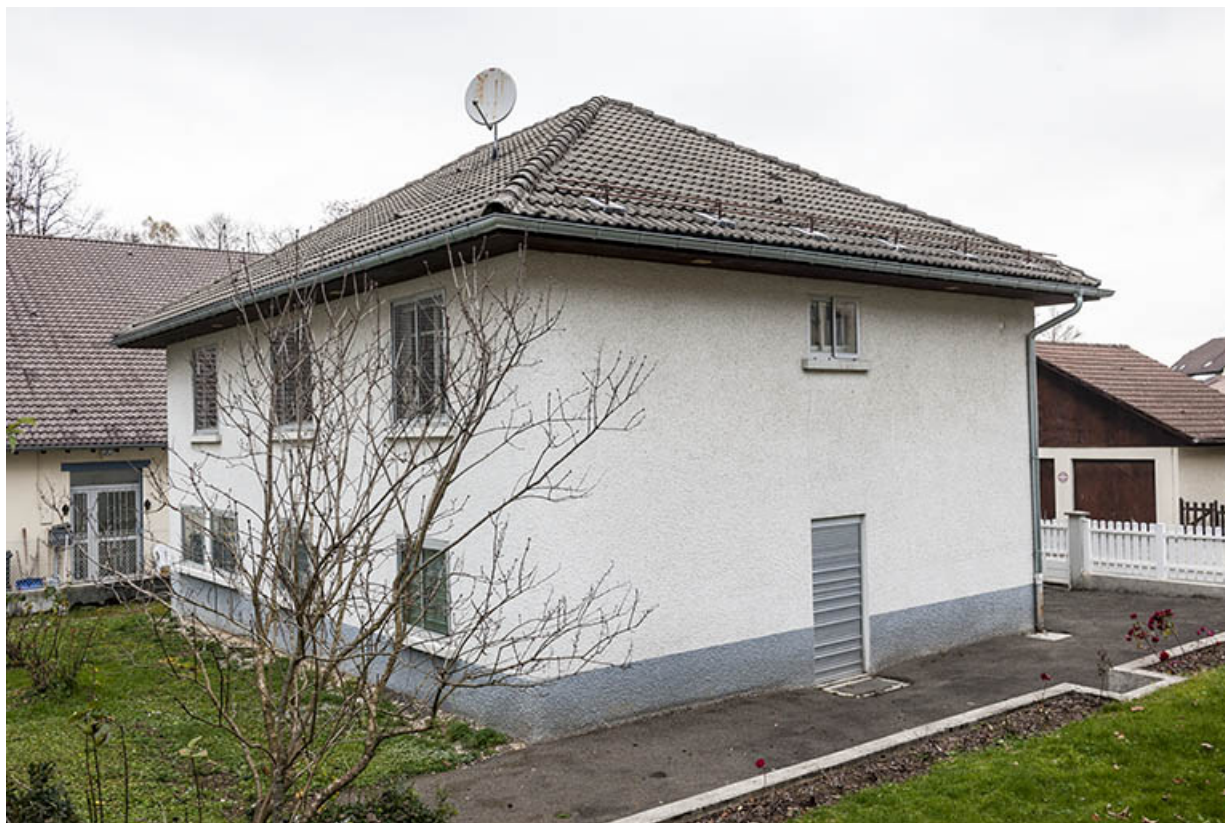
Façades postérieure et latérale gauche. L'atelier se trouvait au rez-de-chaussée dans l'angle à gauche. 25, Maîche, 1 rue Joseph Aubert
