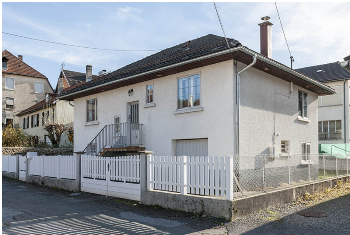
Façades antérieure et latérale droite. L'atelier se trouvait au rez-de-chaussée dans l'angle à droite. 25, Maîche, 1 rue Joseph Aubert
