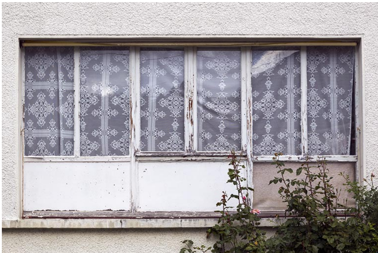
Façade antérieure : fenêtre d'atelier au rez-de-chaussée.
