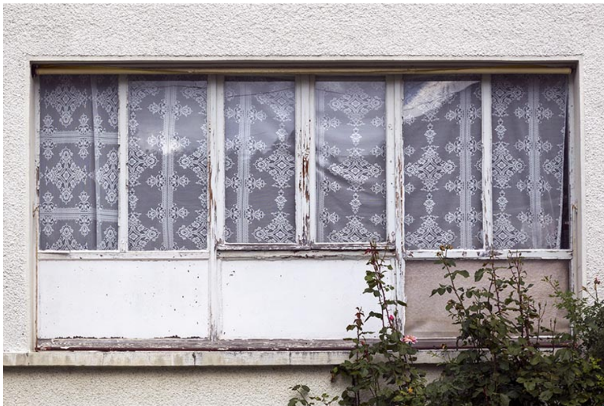
Façade antérieure : fenêtre d'atelier au rez-de-chaussée.
