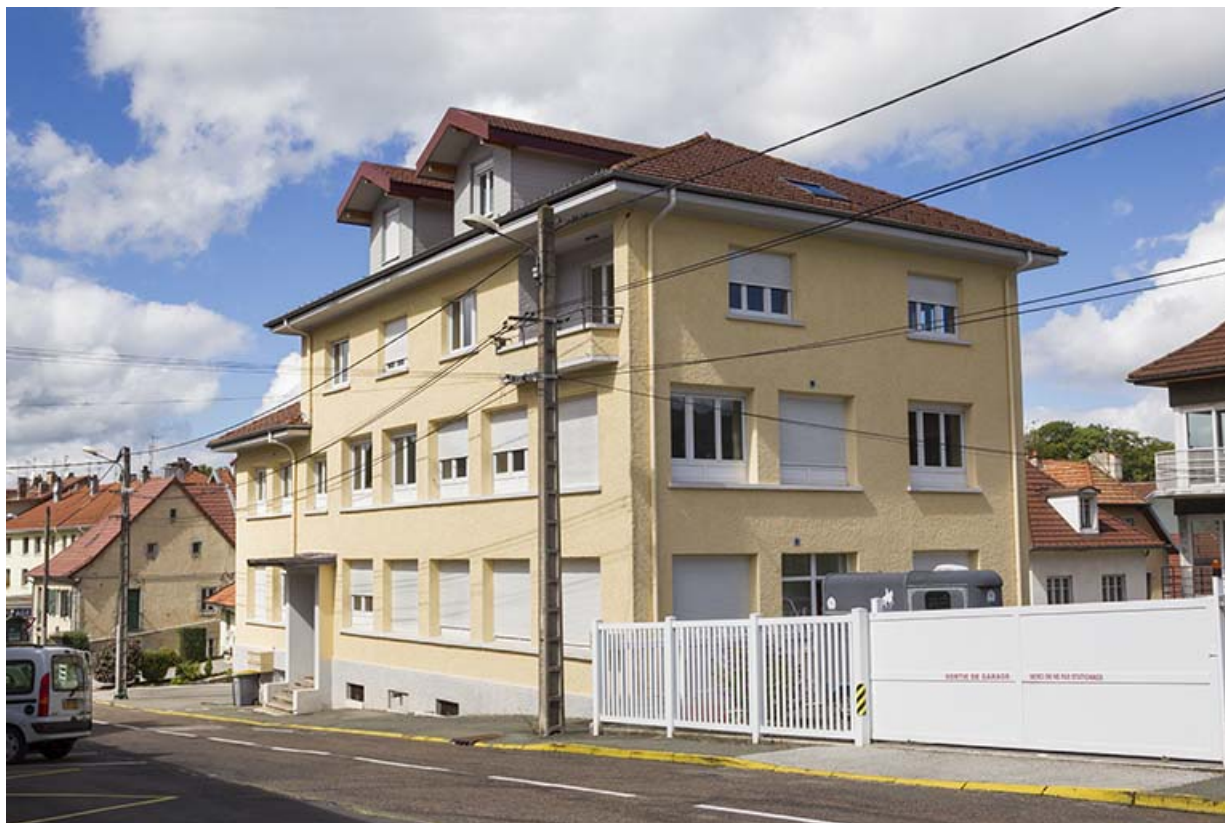
Façades antérieure et latérale droite.
