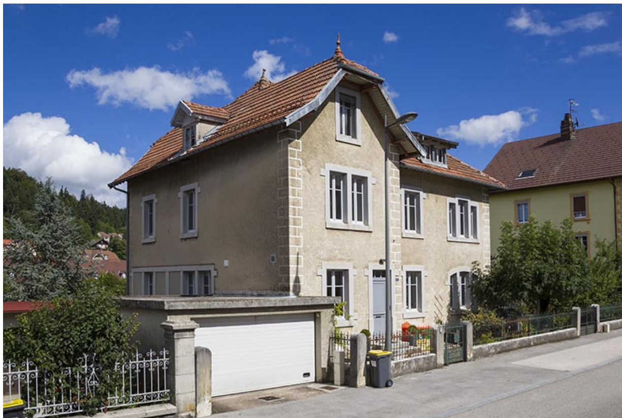
Façades antérieure et latérale gauche.
