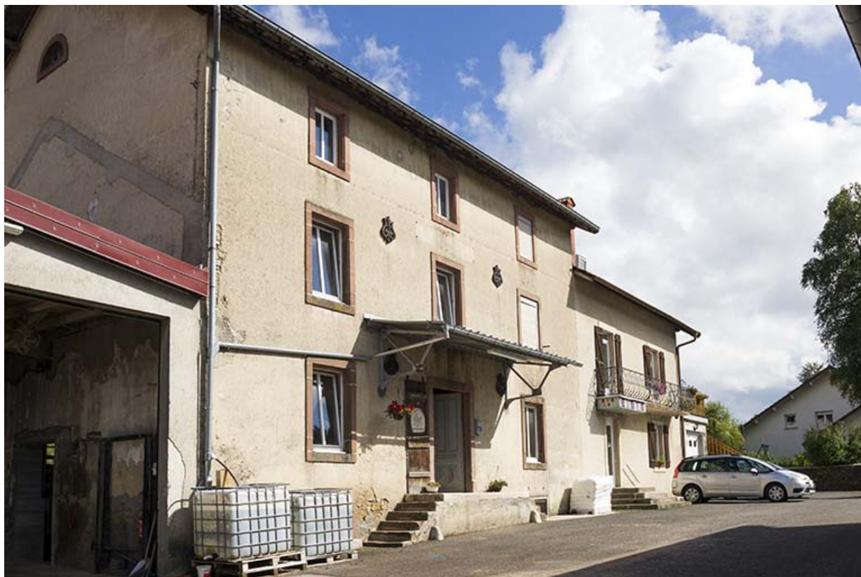
Minoterie et logement patronal : façade antérieure, de trois quarts gauche. 25, Maîche, 12 et 14 rue du Mont Miroir
