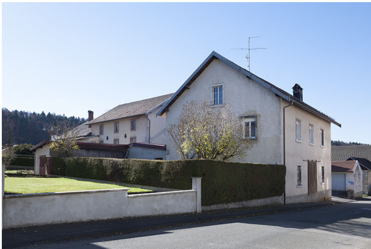
Vue d'ensemble, depuis le nord-est (entrepôt de vin à droite, minoterie à gauche). 25, Maîche, 12 et 14 rue du Mont Miroir
