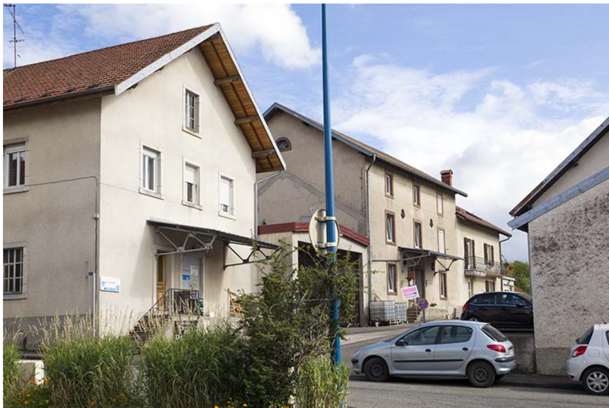
Entrepôt de vin, garage, minoterie et logement patronal, depuis la rue du Mont Miroir. 25, Maîche, 12 et 14 rue du Mont Miroir
