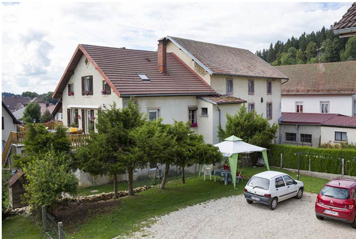
Vue d'ensemble, depuis le sud-est (logement patronal, minoterie, garage et entrepôt de vin). 25, Maîche, 12 et 14 rue du Mont Miroir
