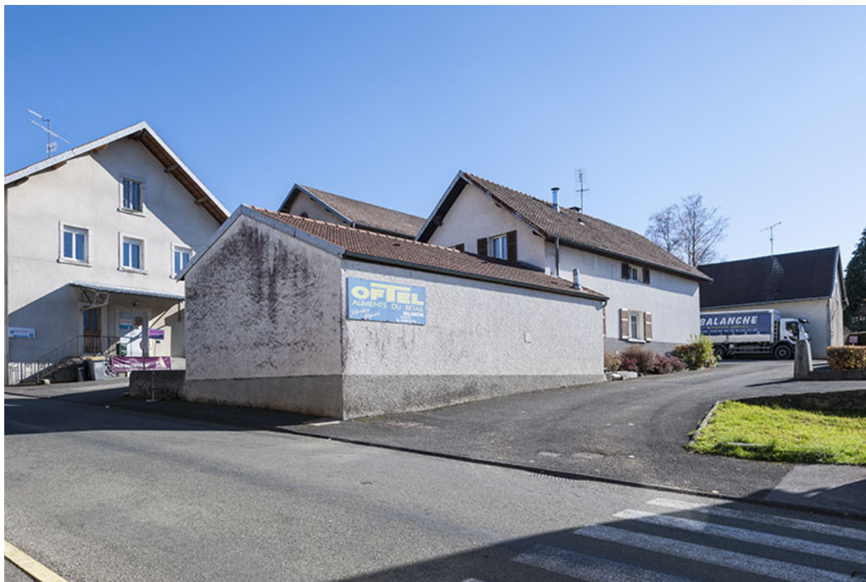
Vue d'ensemble, depuis le nord-ouest : garages, ancien atelier de réparation et ancienne écurie. 25, Maîche, 12 et 14 rue du Mont Miroir
