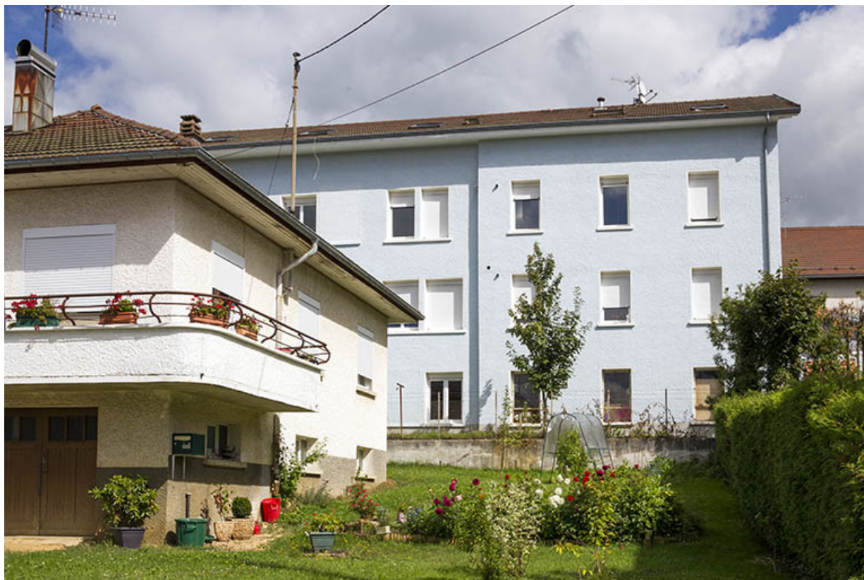
Façade postérieure (partie droite).
