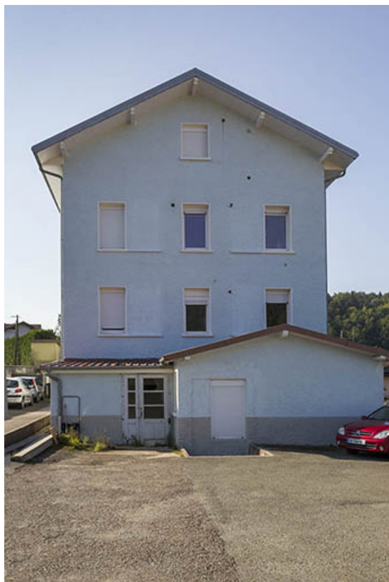
Façade latérale droite.
