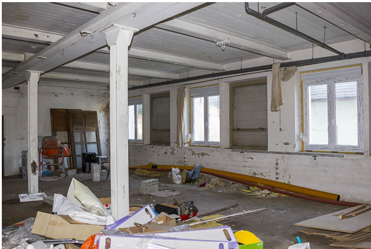
Atelier au rez-de-chaussée. 25, Maîche, 4 rue de la Gare
