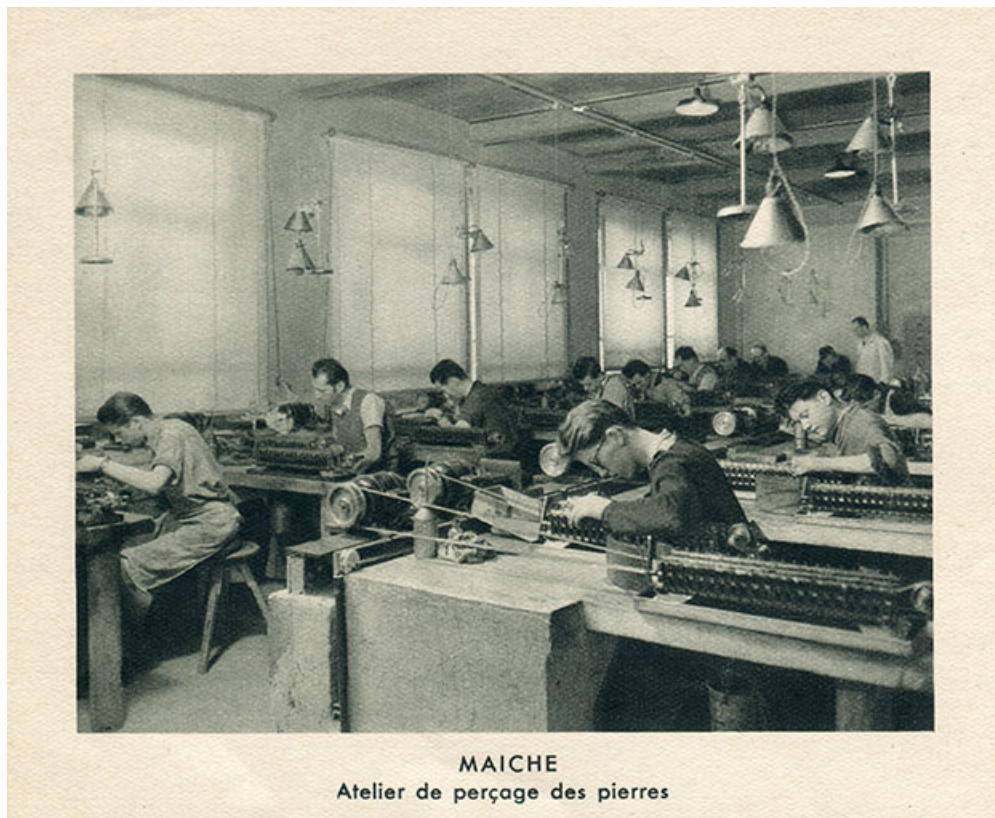
Maïche. Atelier de perçage des pierres, 1950.
