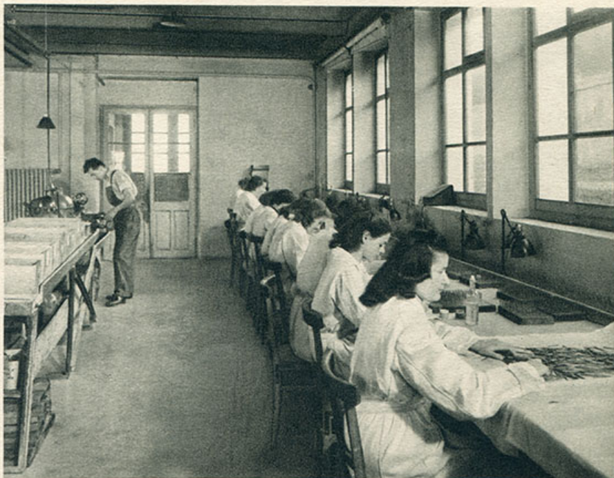
MAICHE Préparation des pierres pour le perçage
