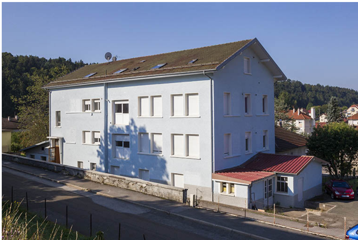
Usine n° 3 (Technic Ebauche dans l'ancienne fabrique Mauvais et Rondot), au 4 rue de la Gare à Maîche. 25, Maîche, 4 rue de la Gare
