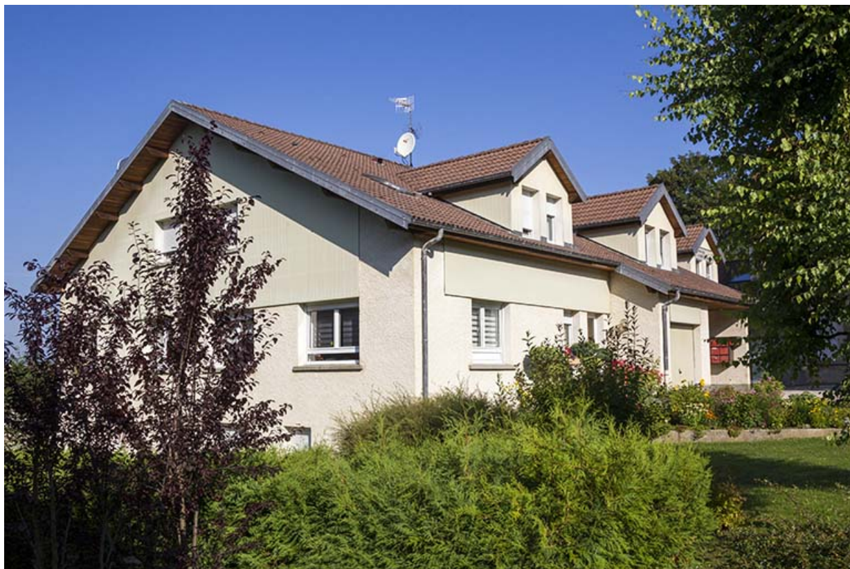
Ateliers de fabrication : façades antérieure et latérale gauche.
