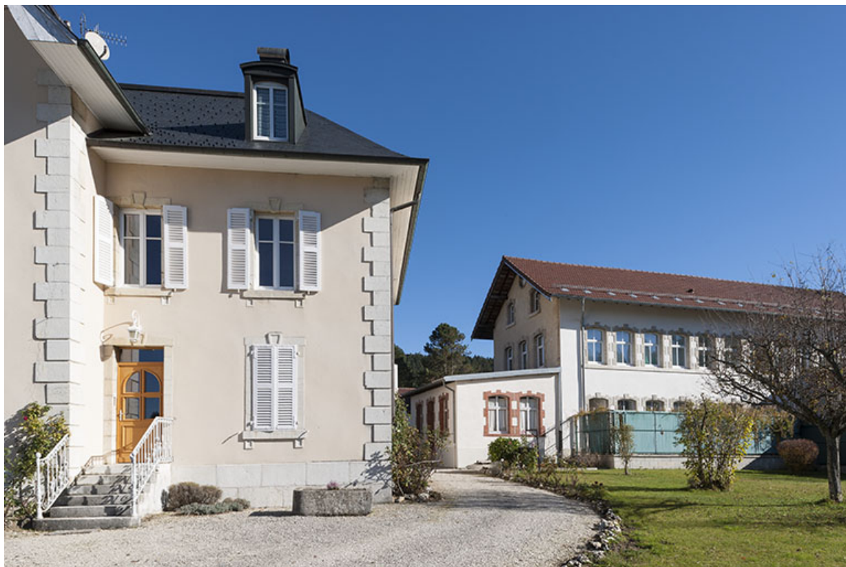
Logement patronal (corps d'entrée) et bâtiment d'origine, depuis la rue Sainte-Anne. 25, Maîche, 1 rue Guynemer
