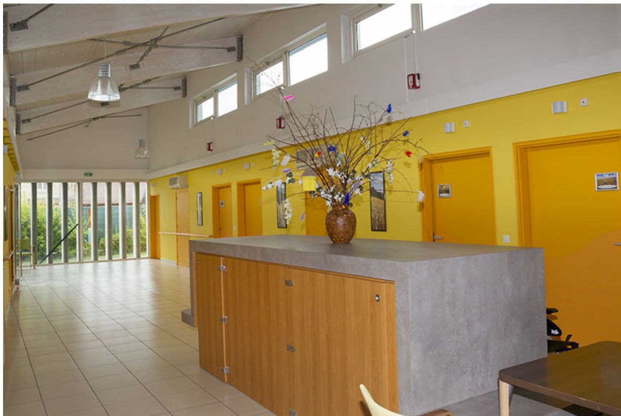
Bâtiments récents, intérieur : hall avec charpente en lamellé-collé apparente. 25, Maîche, 1 rue Guynemer
