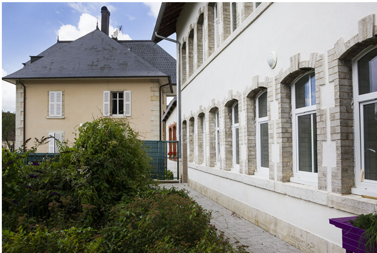
Atelier d'origine : façade occidentale, vue en enfilade. En arrière-plan, la villa. 25, Maîche, 1 rue Guynemer
