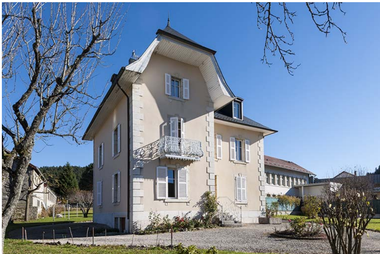
Logement patronal : façades antérieure et latérale gauche.
