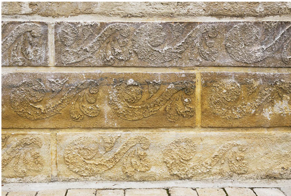
Façade antérieure : décor de l'enduit en partie basse.
