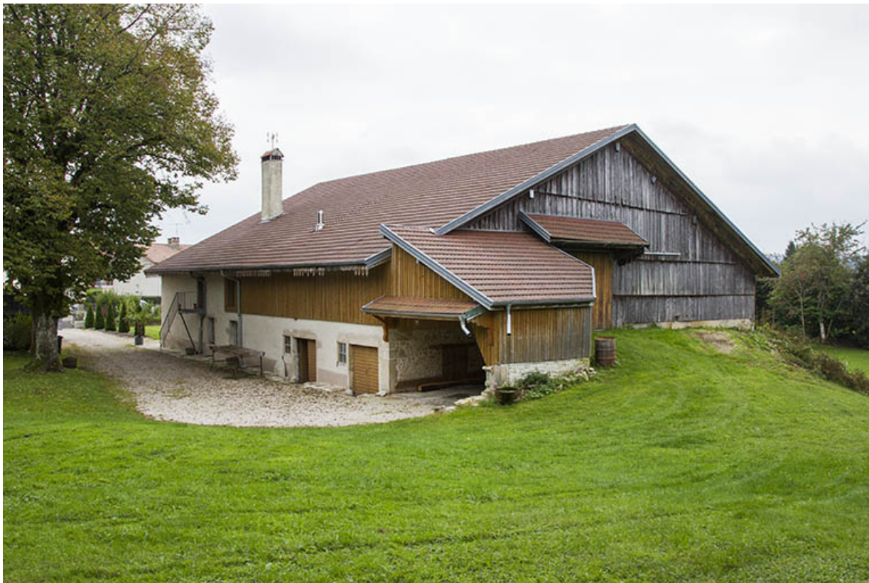
Ferme (au n° 8) : vue d'ensemble, depuis le nord (façades postérieure et latérale droite). 25, Maîche, 6 et 8 rue des Combes
