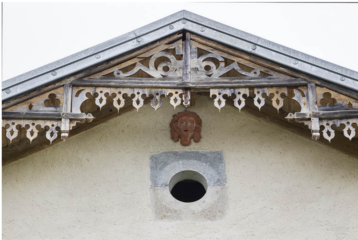
Façade antérieure : lambrequin et oculus du 2e étage de comble.
