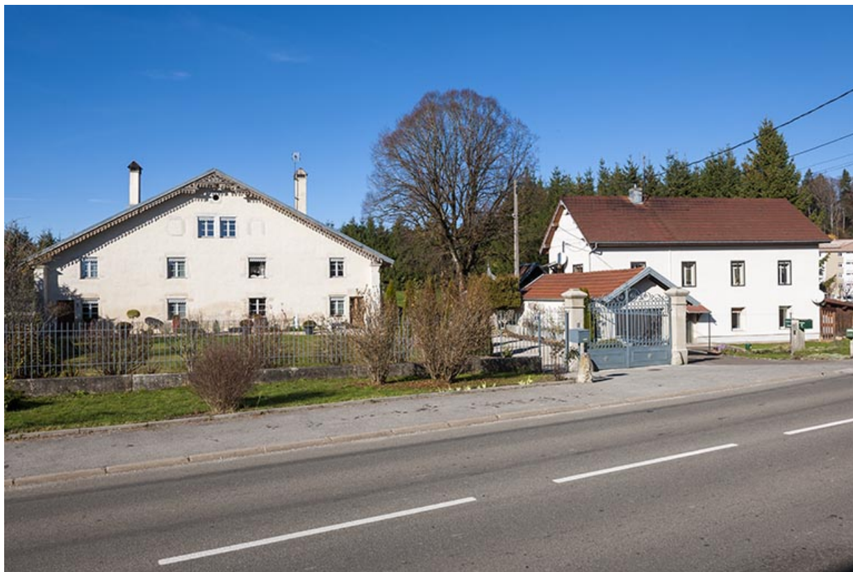
Vue d'ensemble, depuis la rue des Combes à l'est : ferme à gauche (au n° 8), atelier de fabrication à droite (au n° 6). 25, Maîche
