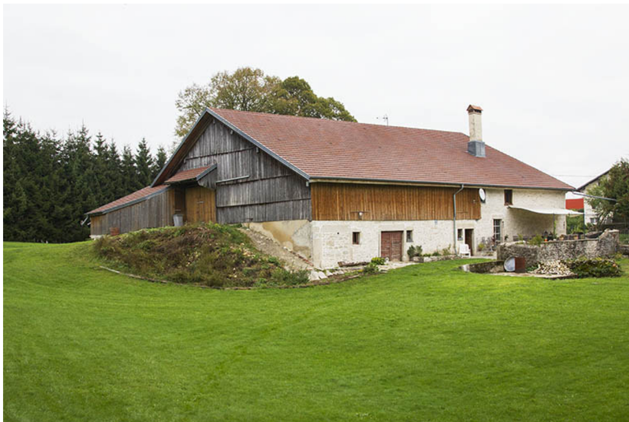
Ferme (au n° 8) : vue d'ensemble, depuis l'ouest (façades postérieure et latérale gauche). 25, Maîche, 6 et 8 rue des Combes
