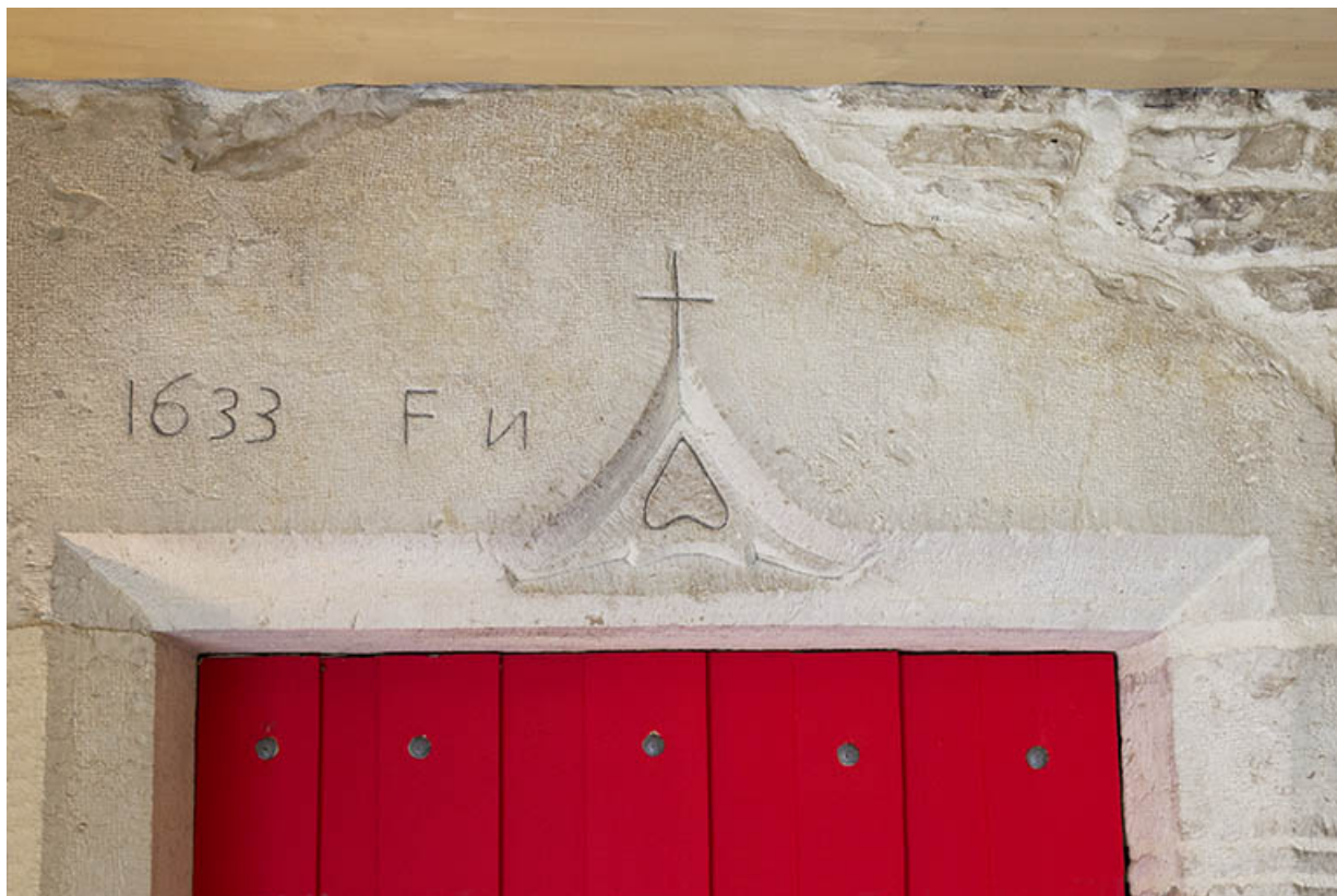
Linteau portant la date 1633, intégré au bâtiment.
