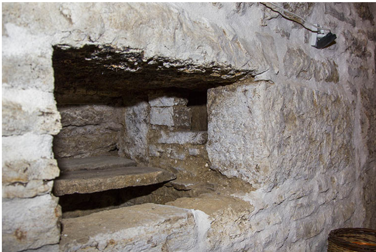
Cellier : niche dans le mur et sa cache.
