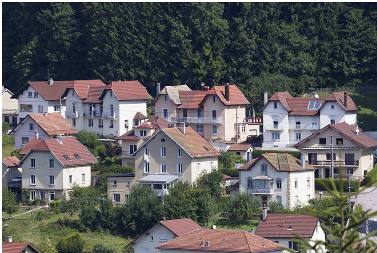
Vue d'ensemble des trois immeubles orientaux (n° 1 à 7 rue Montjoie), depuis le sud. 25, Maîche
