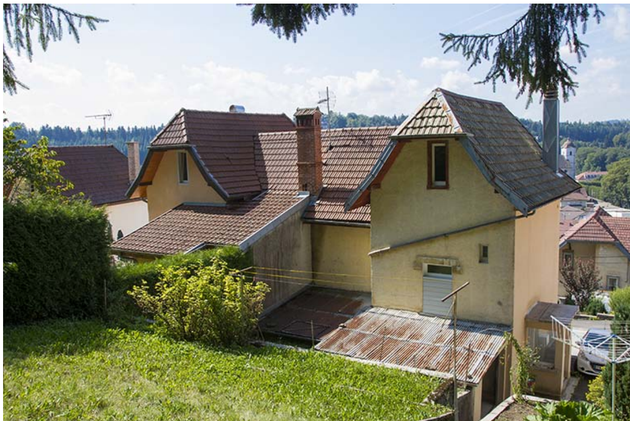
Immeuble au n° 3 : façade côté mont (est), de trois quarts droite.
