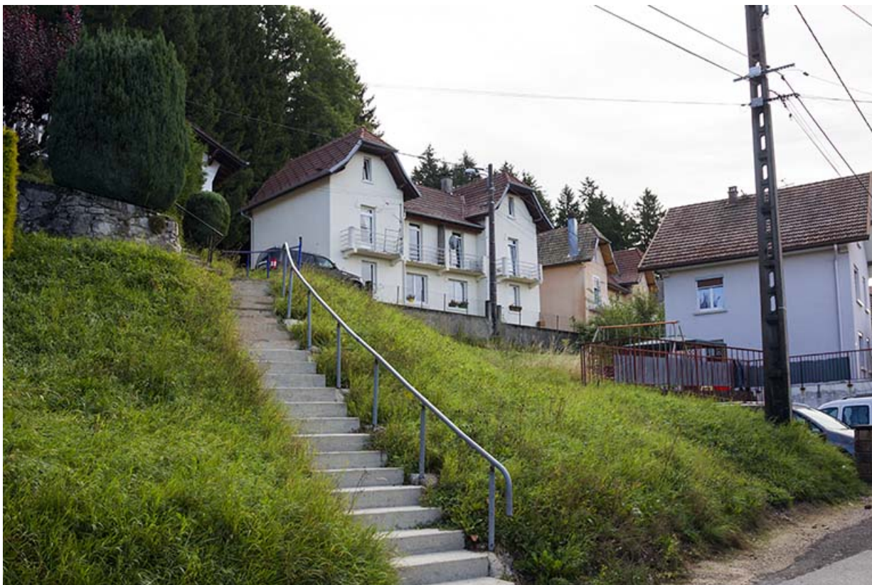
Immeuble au n° 1 : façade côté vallée (ouest), de trois quarts gauche. 25, Maîche, 1, 3-7 rue Montjoie
