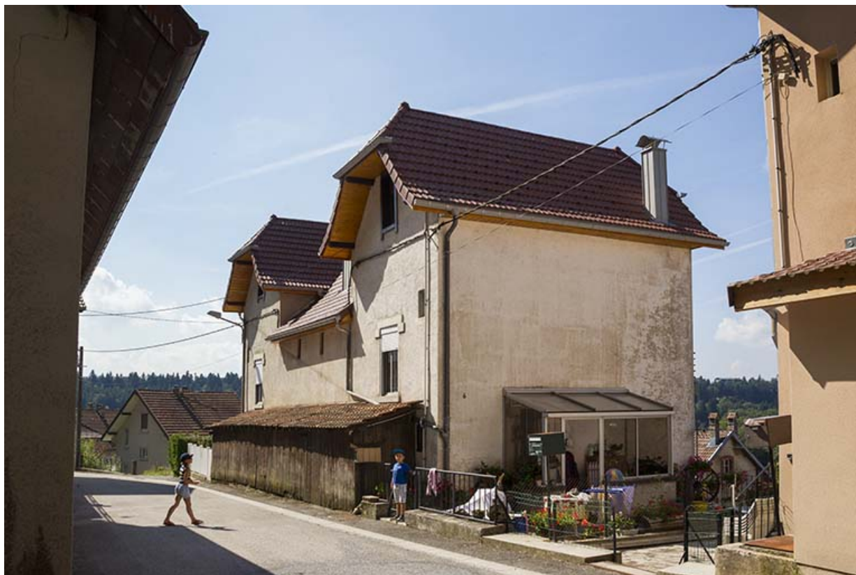
Immeuble n° 6 : façades nord et est (côté rue). 25, Maîche, 1, 3-7 rue Montjoie
