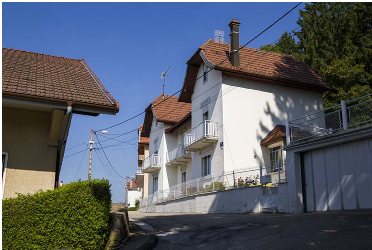
Immeuble aux n° 5-7 : façade côté vallée (ouest), de trois quarts droite. 25, Maîche, 1, 3-7 rue Montjoie
