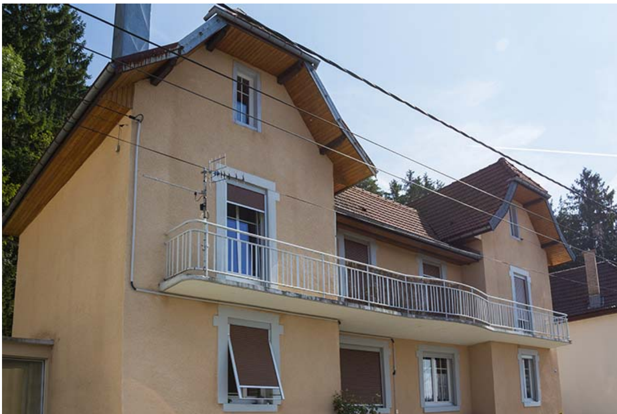
Immeuble au n° 3 : façade côté vallée (ouest), de trois quarts gauche. 25, Maîche, 1, 3-7 rue Montjoie
