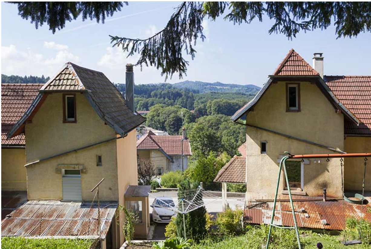
Immeubles aux n° 1 (à droite) et 3 (à gauche) : mur pignon des corps d'extrémité côté mont (est). 25, Maîche, 1, 3-7 rue Montjoie
