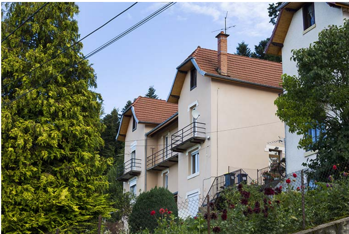
Immeuble n° 4 : façade côté vallée (ouest), de trois quarts droite. 25, Maîche, 1, 3-7 rue Montjoie
