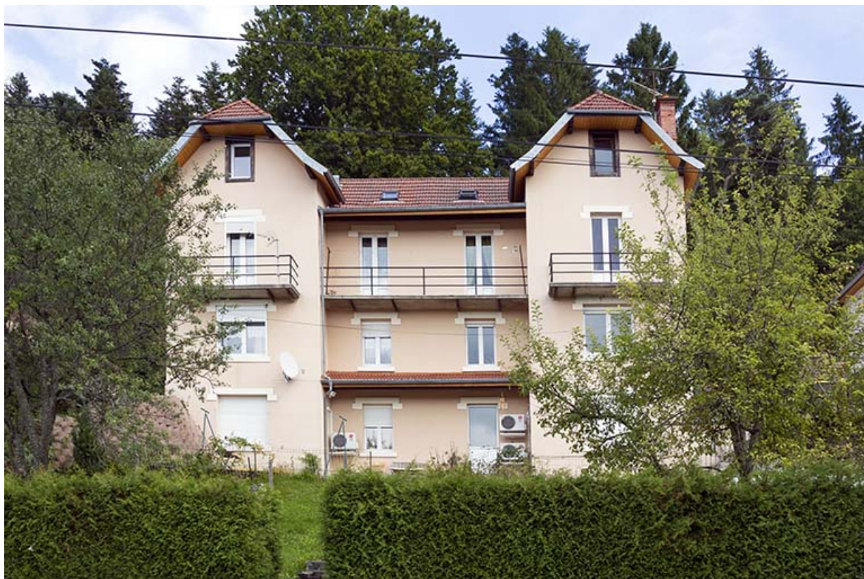
Immeuble n° 4 : façade côté vallée (ouest). 25, Maîche, 1, 3-7 rue Montjoie
