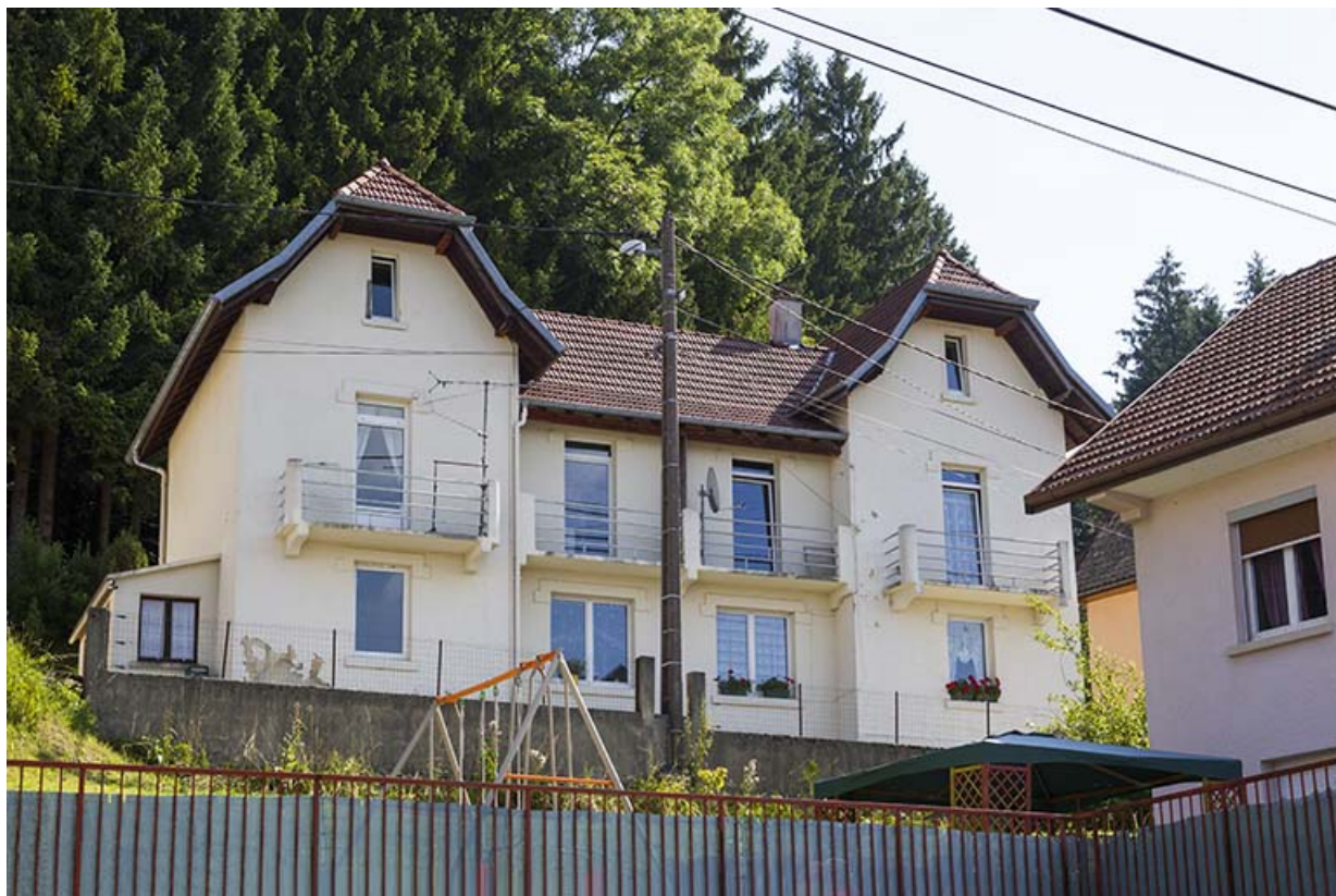
Immeuble au n° 1 : façade côté vallée (ouest).
