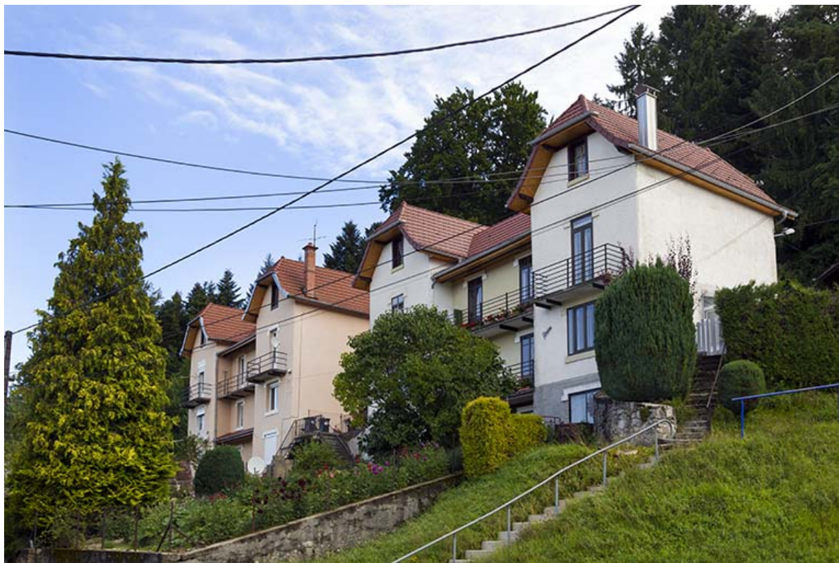
Immeubles n° 4 et 6 : façades côté vallée (ouest), de trois quarts droite. 25, Maîche, 1, 3-7 rue Montjoie
