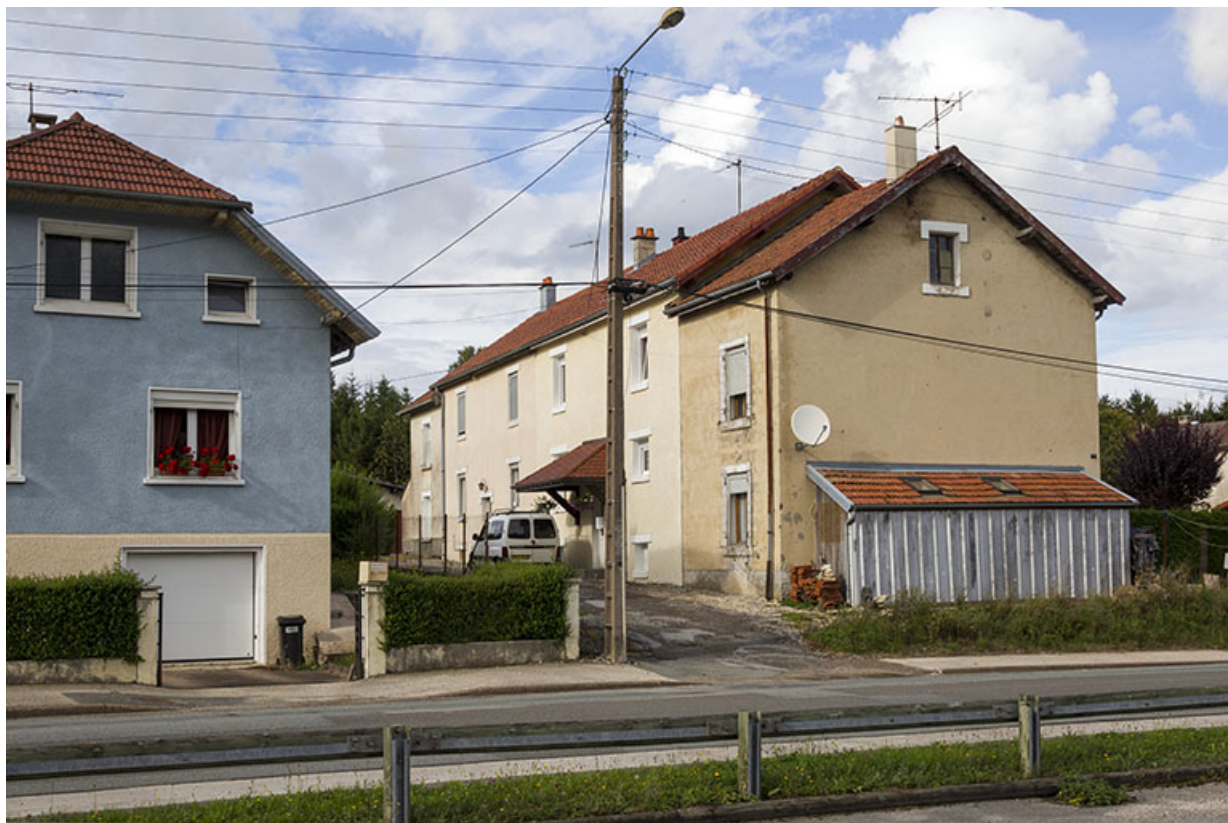
Immeuble au n° 7 avenue du Maréchal Leclerc : vue d'ensemble, depuis le sud-ouest.
