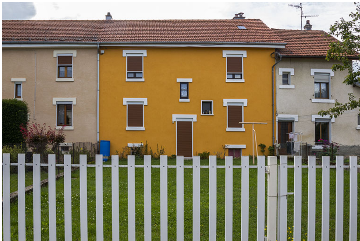
Immeuble au n° 9 : détail de travées à l'est. 25, Maîche, 7-11 avenue du Maréchal Leclerc
