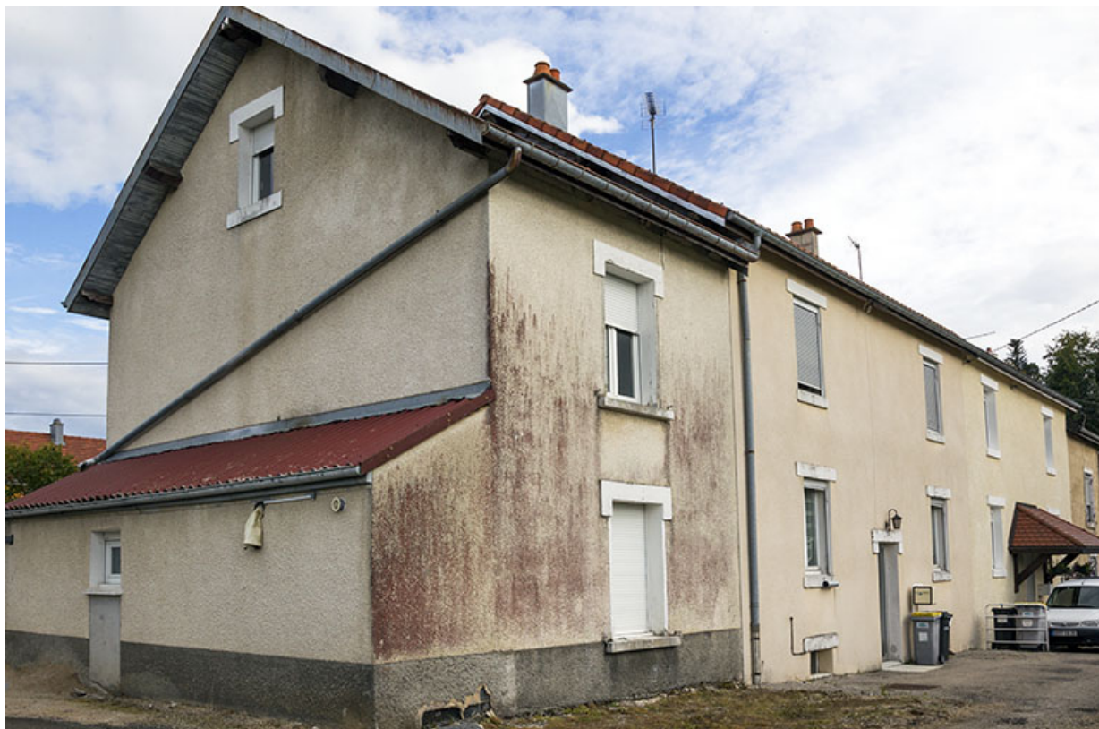
Immeuble au n° 7 : vue d'ensemble, depuis le nord-ouest.
