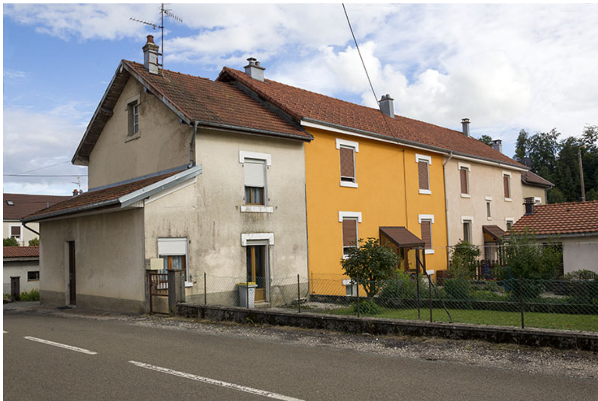
Immeuble au n° 9 : vue d'ensemble, depuis le nord-ouest.
