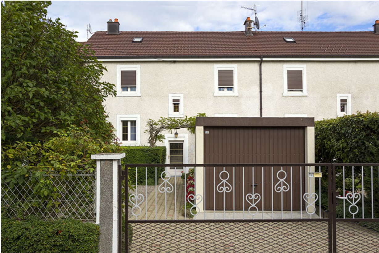
Immeuble au n° 11 : détail de travées à l'ouest.
