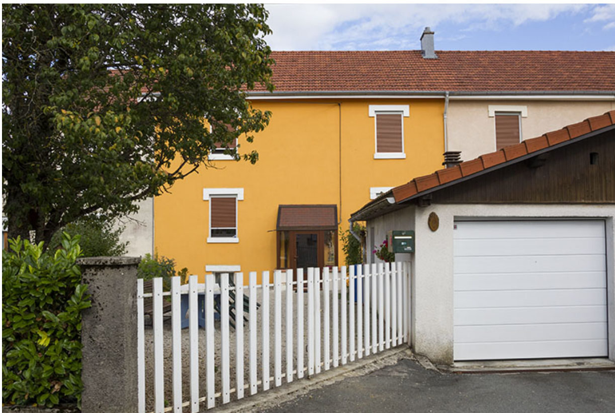
Immeuble au n° 9 : détail de travées à l'ouest.
