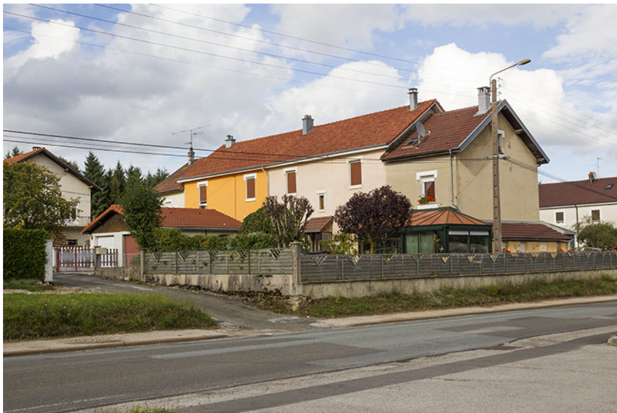
Immeuble au n° 9 avenue du Maréchal Leclerc : vue d'ensemble, depuis le sud-ouest.
