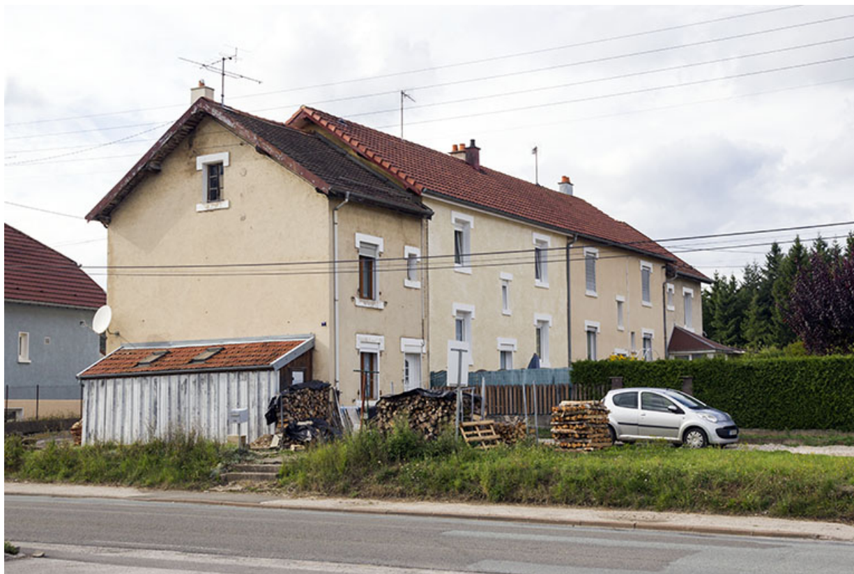
Immeuble au n° 7 : vue d'ensemble, depuis le sud-est.
