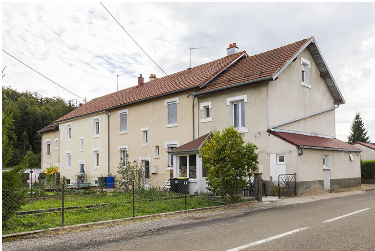
Immeuble au n° 7 : vue d'ensemble, depuis le nord-est. 25, Maîche
