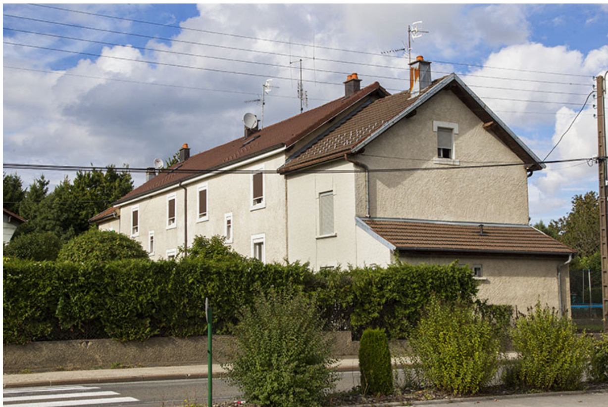
Immeuble au n° 11 avenue du Maréchal Leclerc : vue d'ensemble, depuis le sud-ouest.
