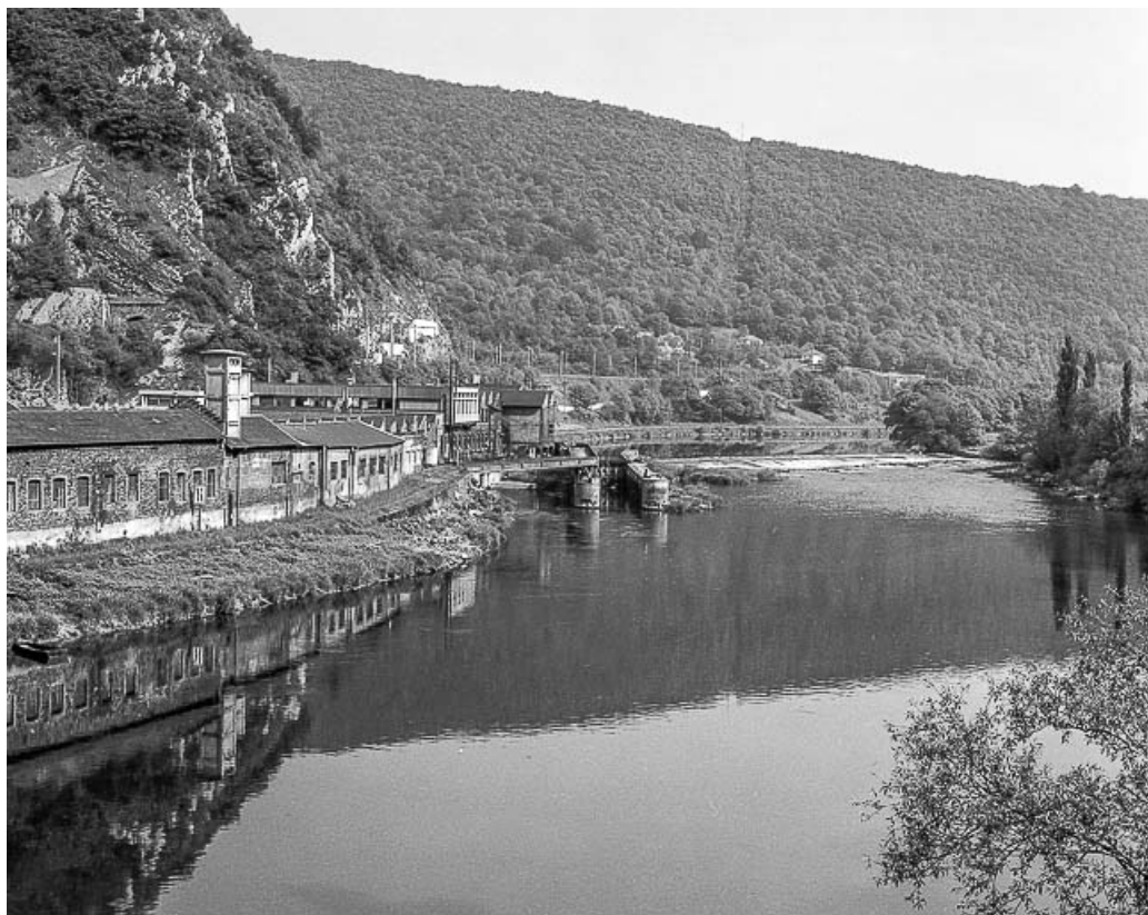
Vue d'ensemble depuis le pont.
