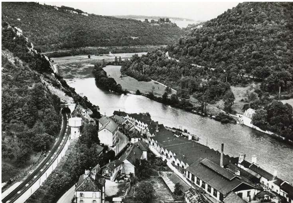
Vue aérienne de l'usine depuis le sud, carte postale, s.d. [vers 1950]. 25, Laissey rue Elysée Bost
