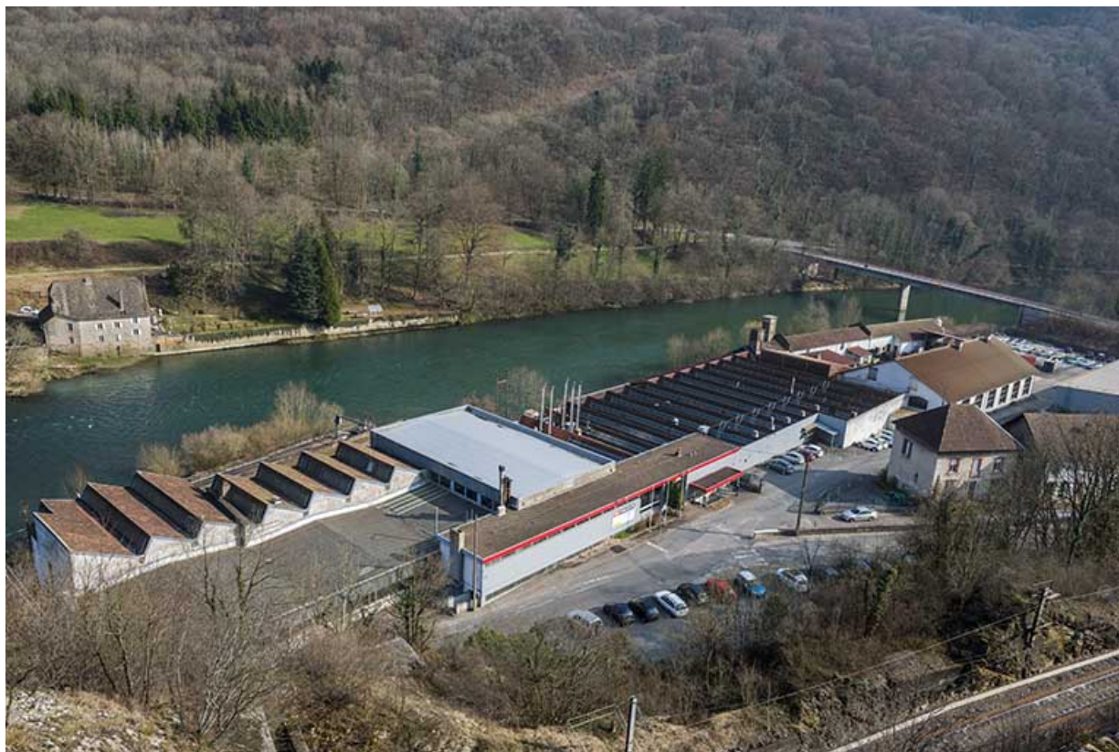
Vue plongeante depuis le nord-ouest.
