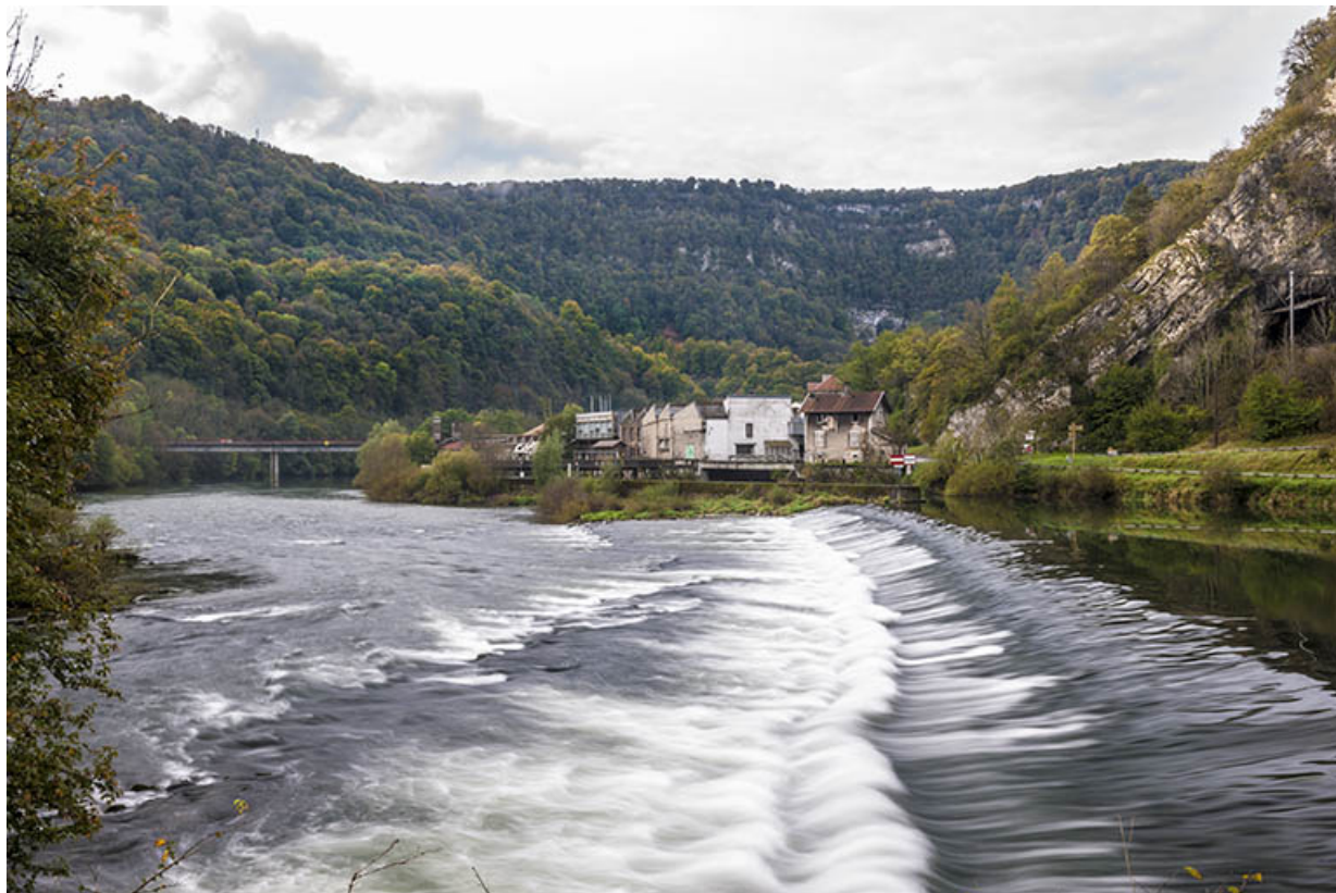
Vue d'ensemble depuis l'extrémité orientale du barrage.
