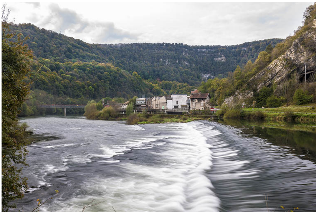
Vue d'ensemble depuis l'extrémité orientale du barrage.
