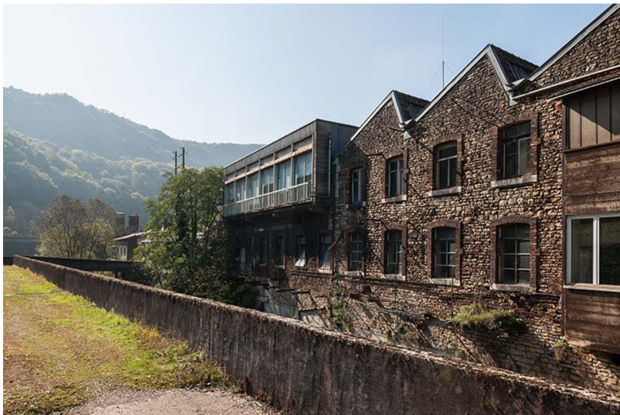
Façade des ateliers depuis la passerelle du canal.
