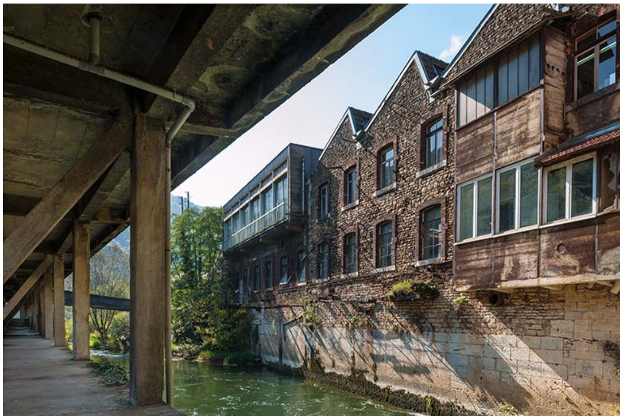
Façade des ateliers sur le canal de fuite.
