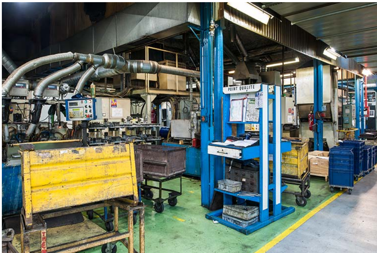
Atelier de traitement thermique. Vue rapprochée. 25, Laissey rue Elysée Bost
