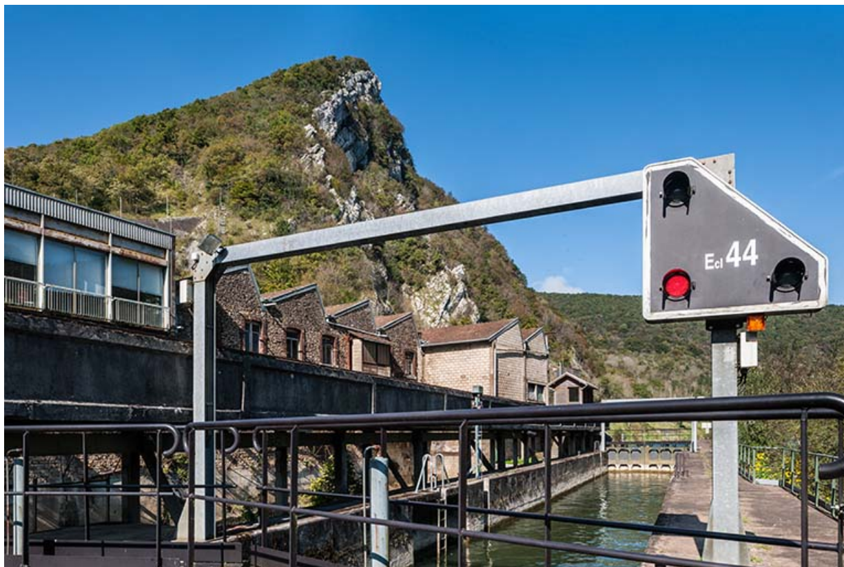
Ecluse construite parallèlement au canal de fuite de l'usine. 25, Laissey rue Elysée Bost
