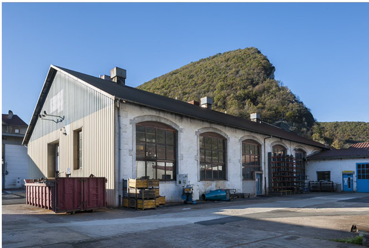
Atelier de forge, depuis la cour.
