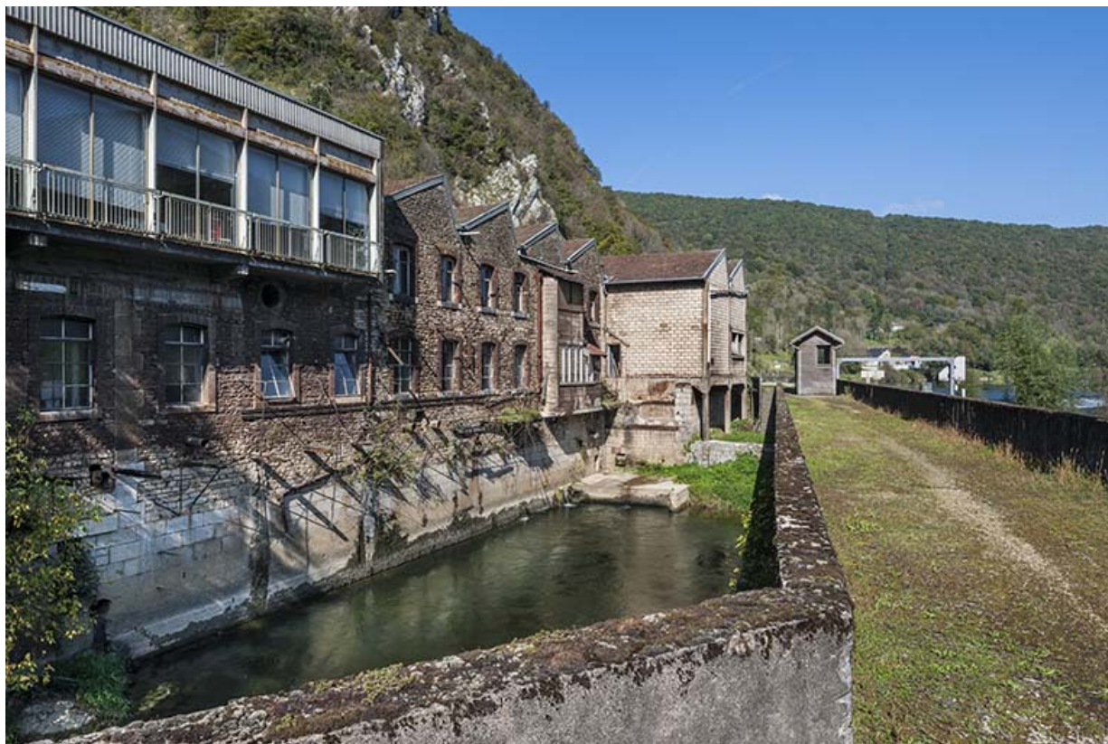
Façade est des ateliers depuis la passerelle du canal. Vue d'ensemble. 25, Laissey rue Elysée Bost
