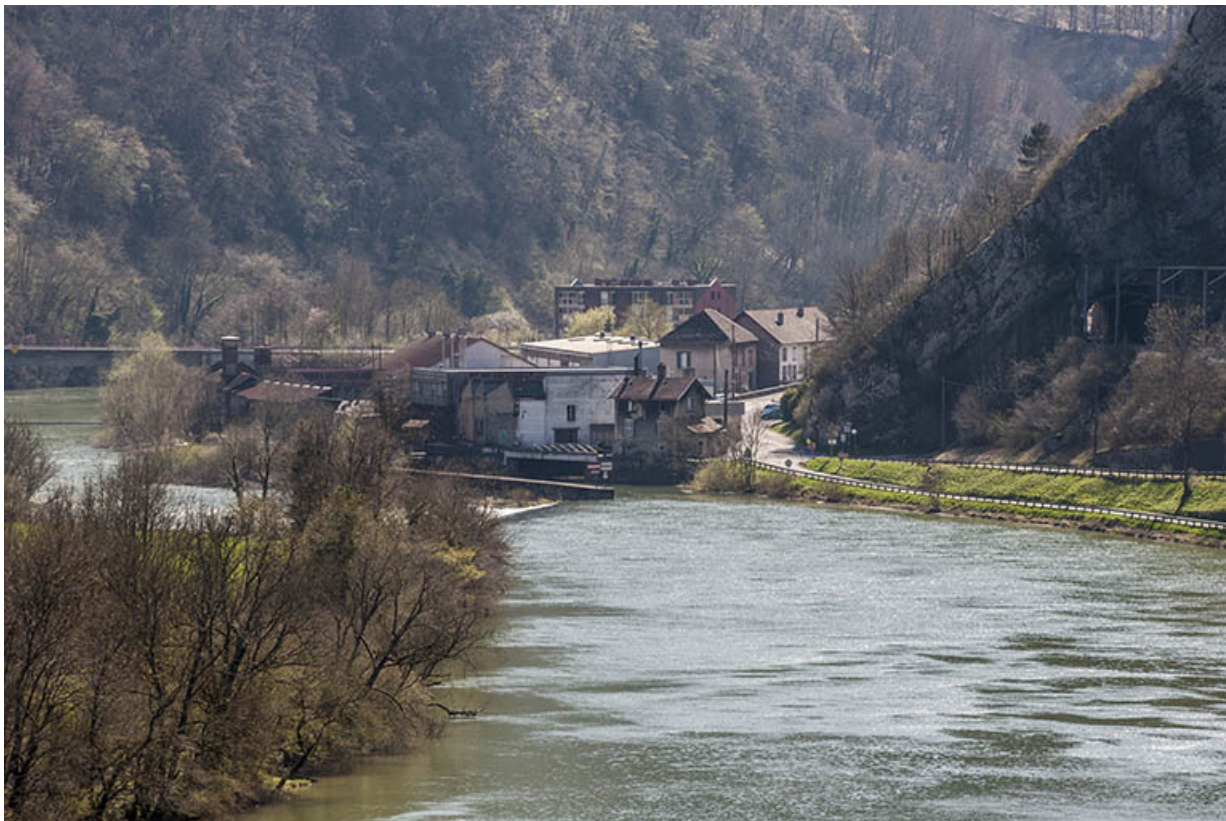
L'usine vue depuis l'amont.
