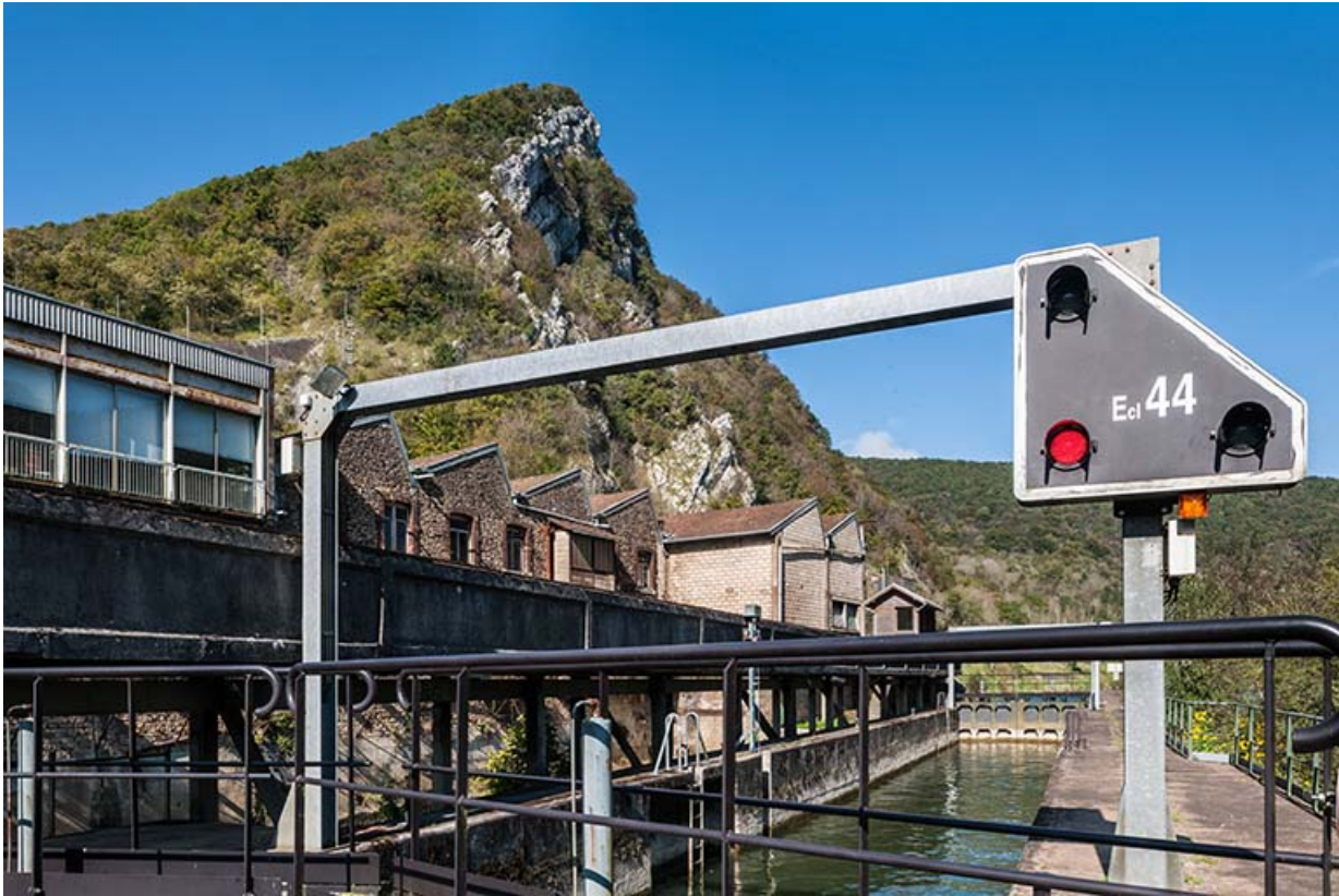
Ecluse construite parallèlement au canal de fuite de l'usine.
