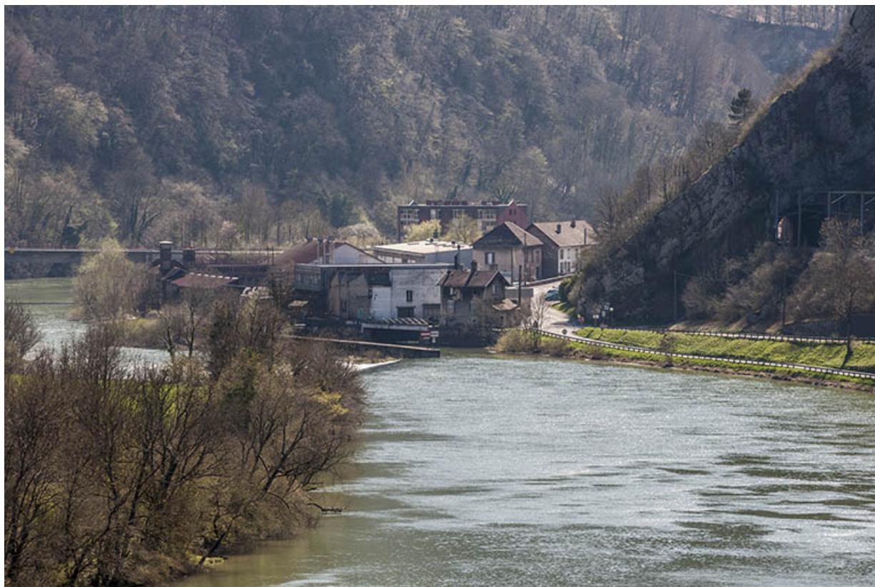
L'usine vue depuis l'amont.
