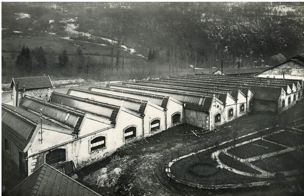
Vue plongeante depuis le nord-est, fotogr., s.d. [début 20e siècle].
