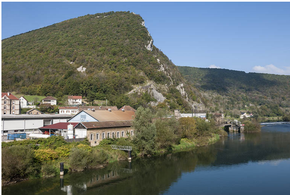
Vue d'ensemble depuis le pont en 2014.
