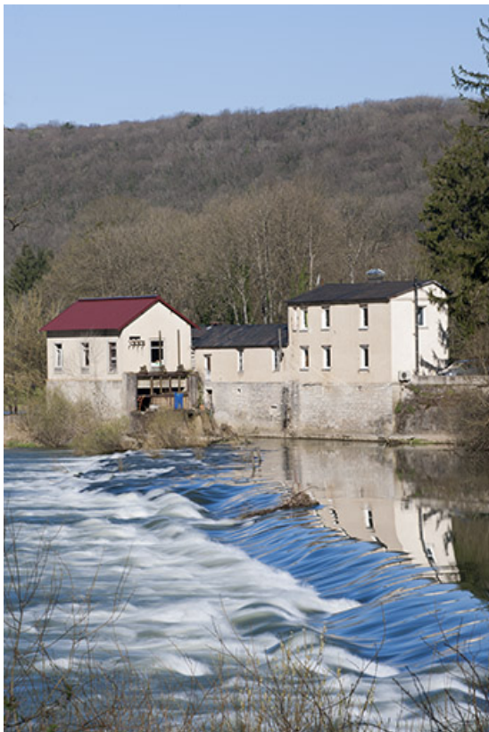
Vue depuis la rive gauche du barrage.
