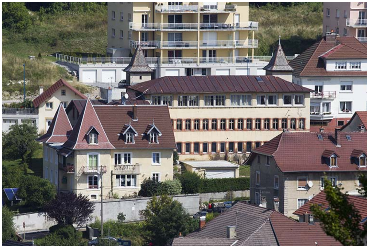
Vue d'ensemble plongeante, depuis le sud. 25, Maîche, 7-9 rue du Mont
