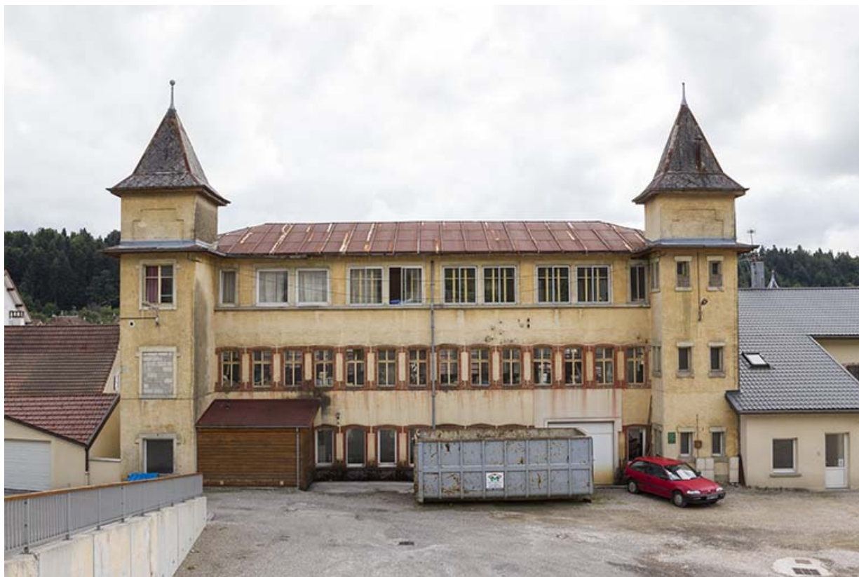
Usine : façade postérieure. 25, Maîche, 7-9 rue du Mont
