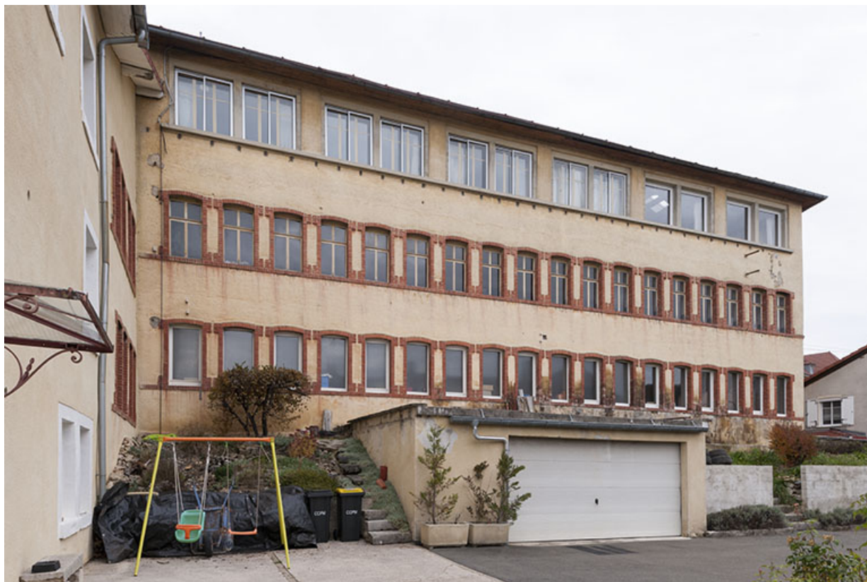
Usine : façade antérieure (sud). 25, Maîche, 7-9 rue du Mont
