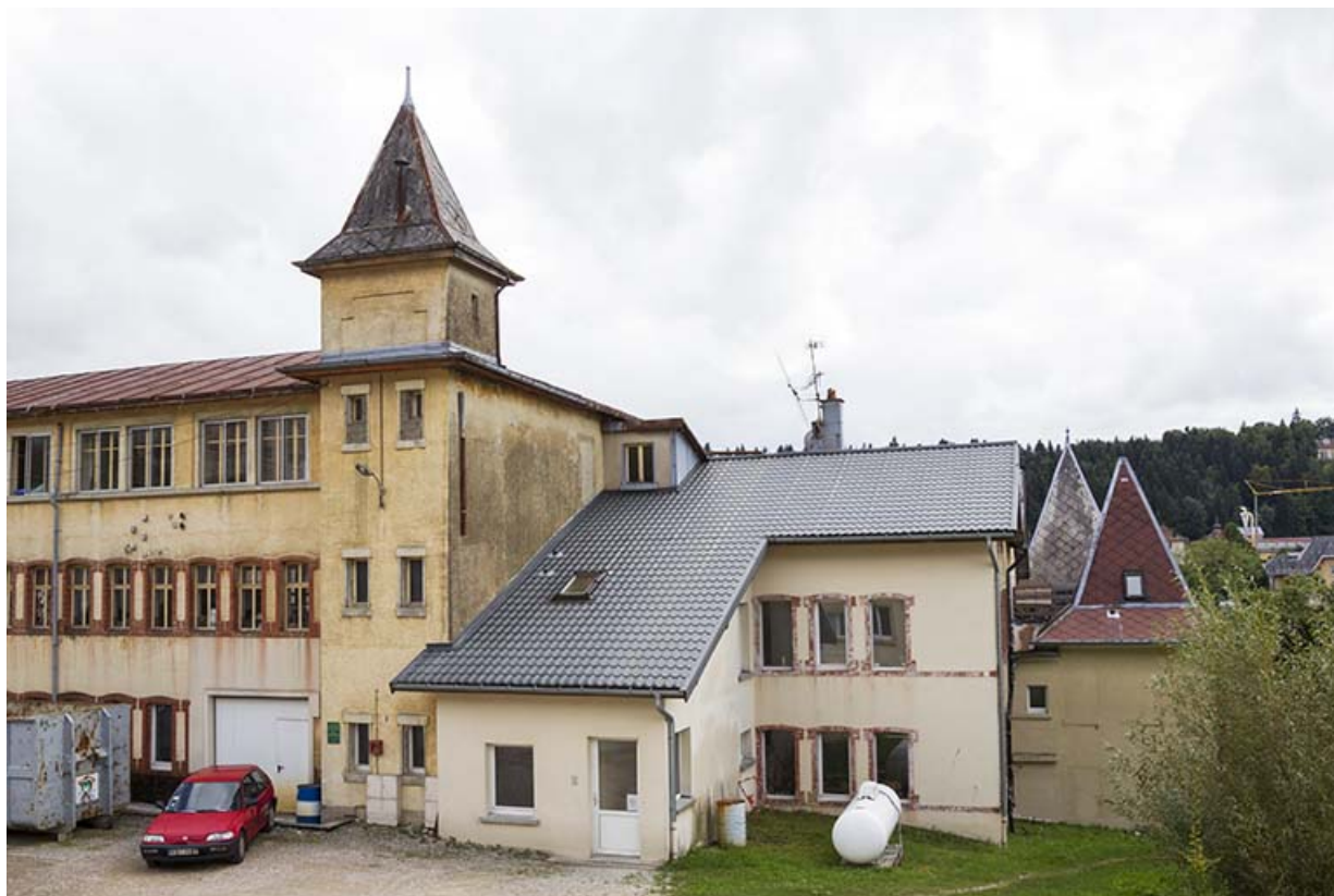
Atelier : façade nord.
