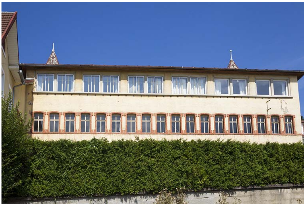
Usine : façade antérieure (sud), depuis la rue du Mont. Seuls les deux étages carrés sont visibles. 25, Maîche, 7-9 rue du Mont
