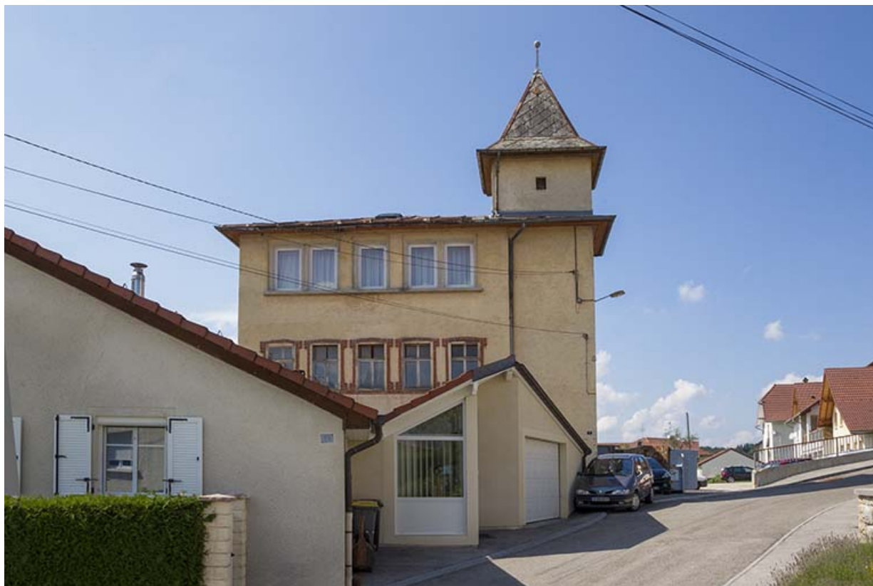
Usine : façade latérale droite.
