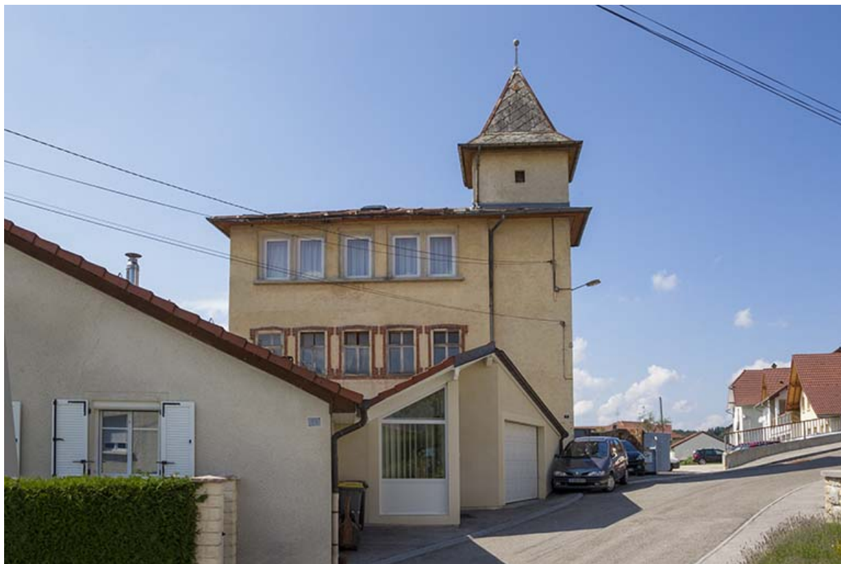
Usine : façade latérale droite.
