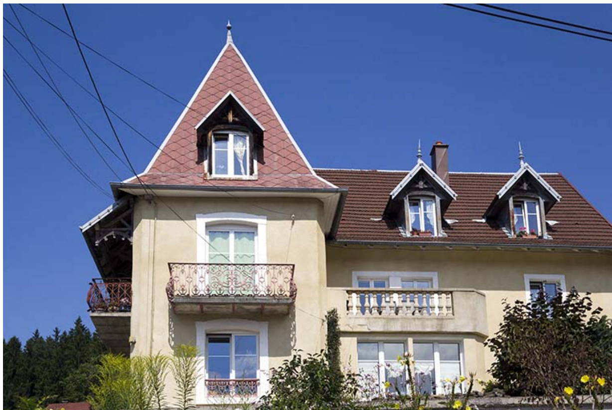
Logement patronal : façade latérale gauche, depuis la rue du Mont. 25, Maîche, 7-9 rue du Mont
