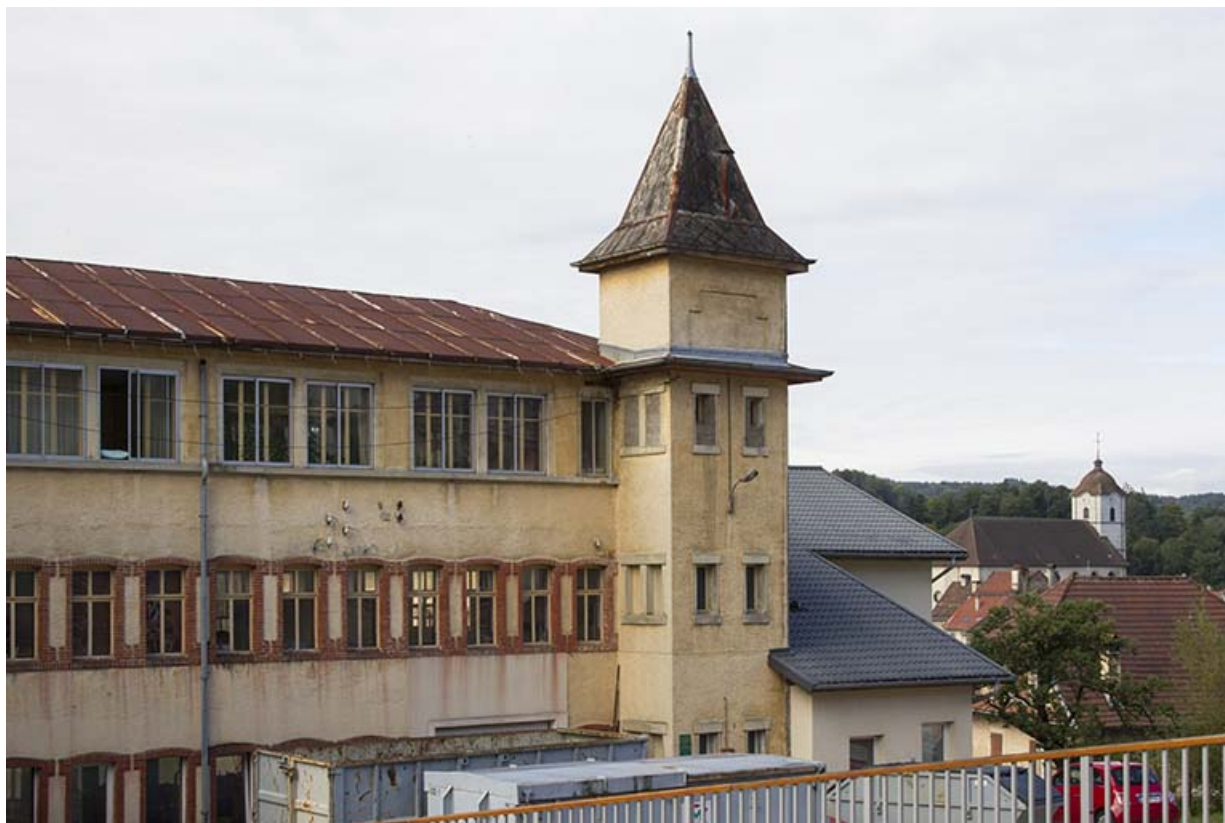
Usine, façade postérieure : tour occidentale. 25, Maîche, 7-9 rue du Mont
