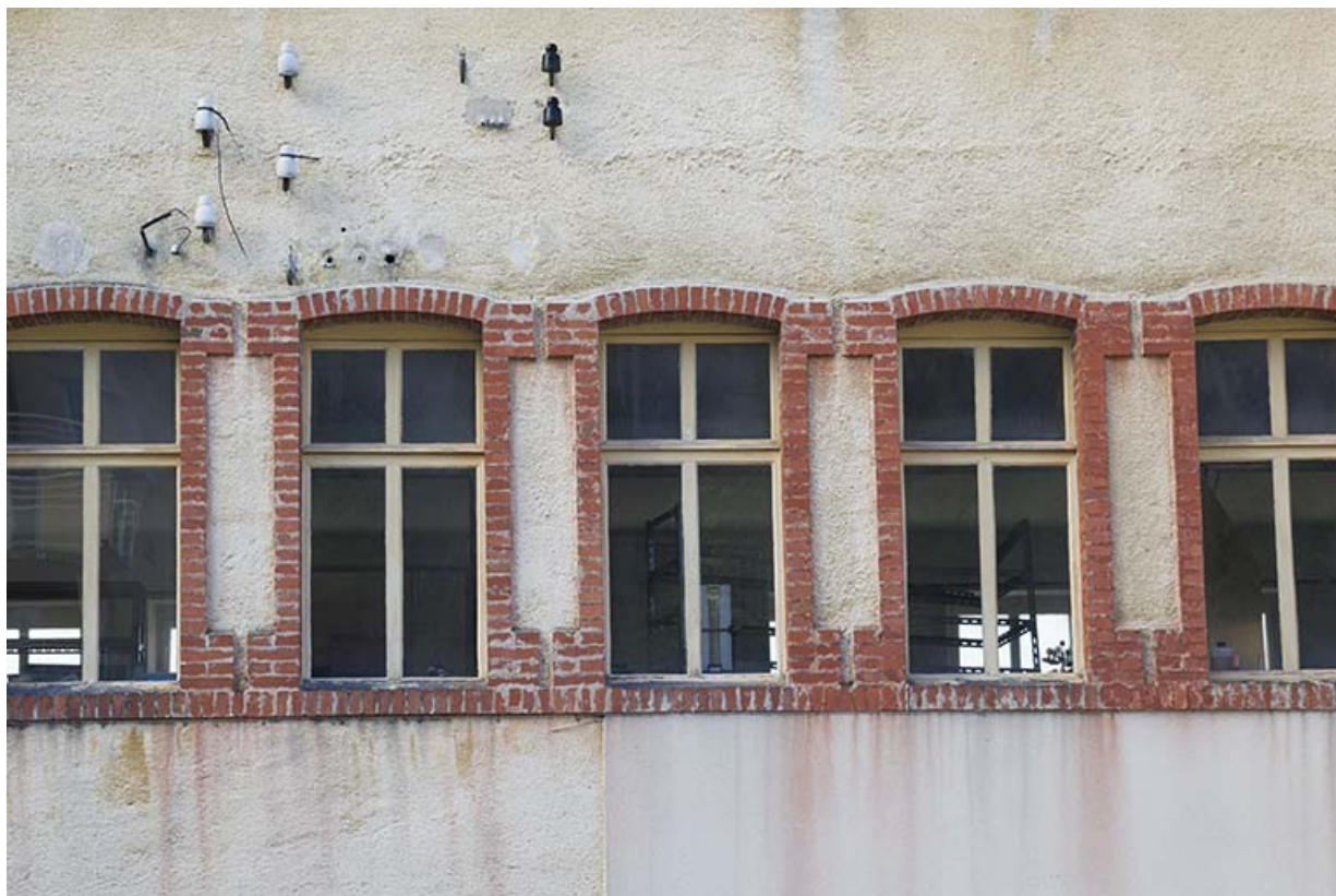
Usine, façade postérieure : fenêtres multiples. 25, Maîche
