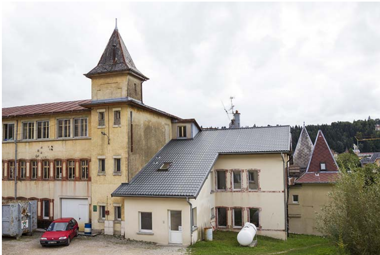
Atelier : façade nord.
