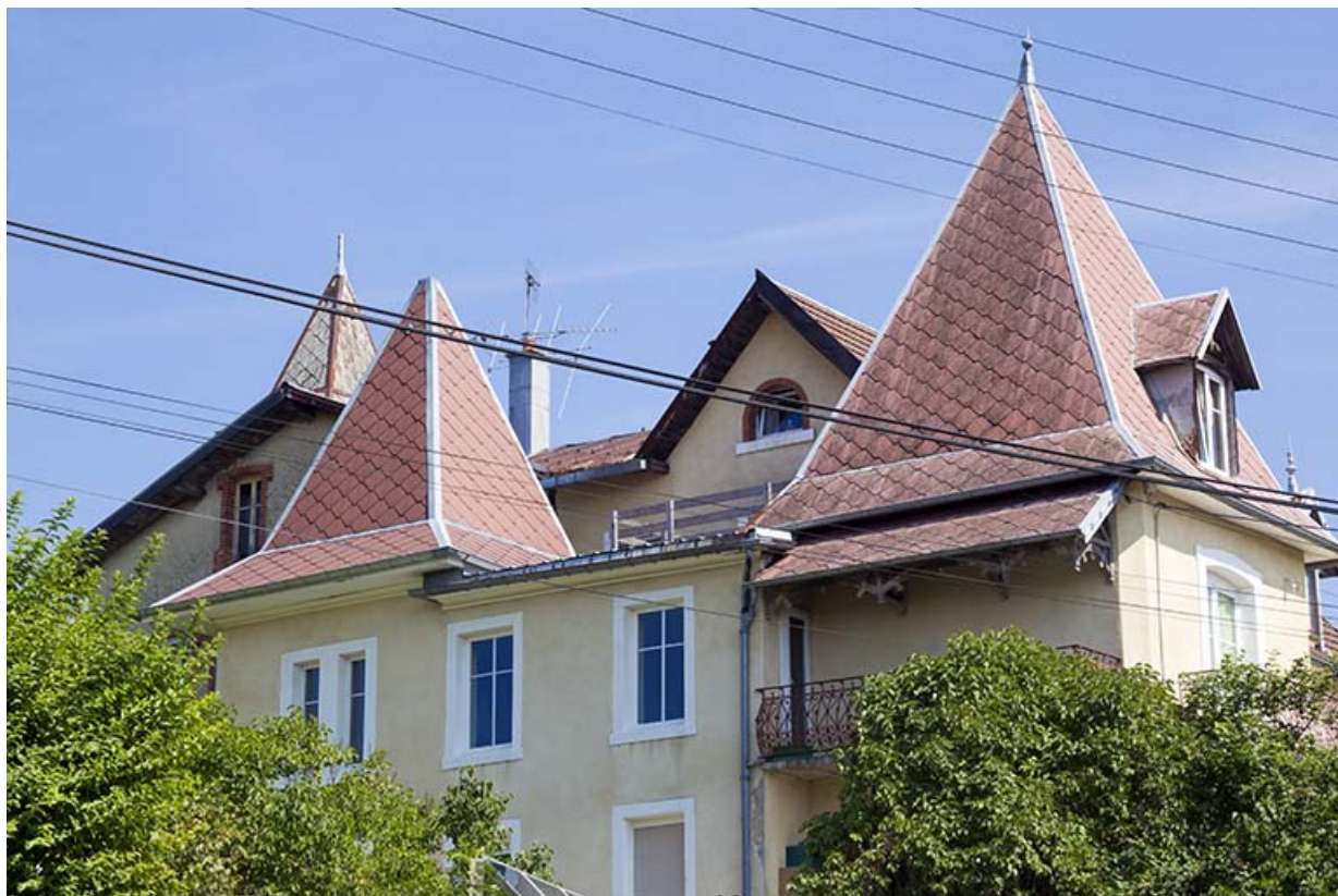
Logement patronal, façade postérieure : étage carré et flèches des tours. 25, Maîche, 7-9 rue du Mont
