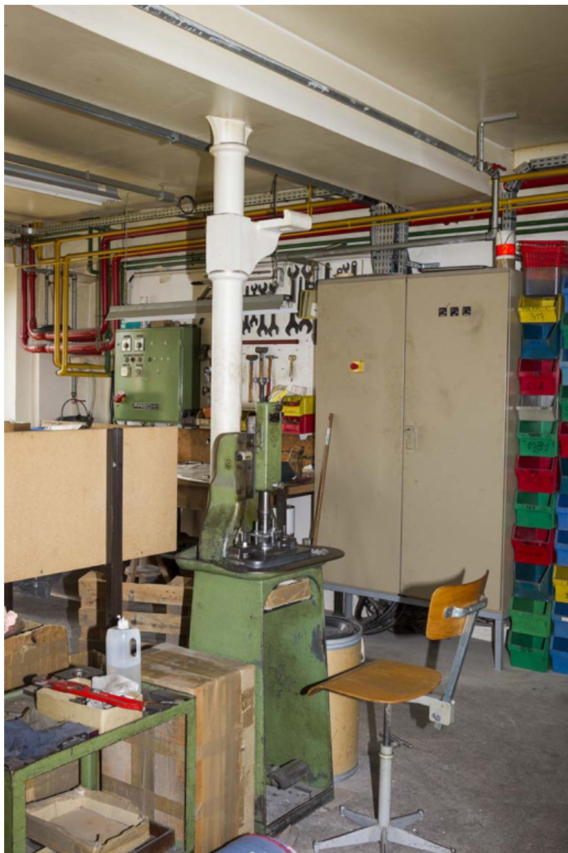
Usine, rez-de-chaussée : poteau de soutènement de l'étage.
