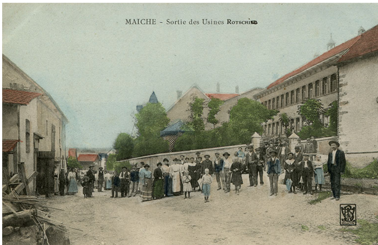
Maïche - Sortie des usines Rotschild [sic] [façade antérieure, de trois quarts droite, de l'usine dotée d'un seul étage carré], entre 1904 et 1909.
