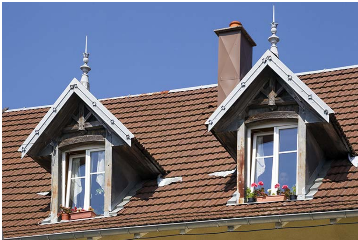
Logement patronal, façade latérale gauche : lucarnes.
