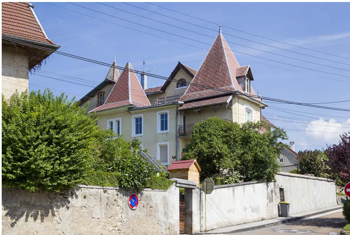
Logement patronal : façade postérieure, de trois quarts droite, depuis la rue du Mont. 25, Maîche, 7-9 rue du Mont
