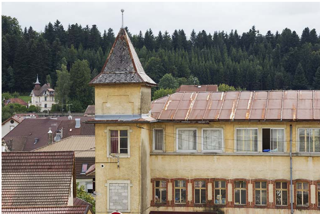
Usine, façade postérieure : tour orientale.
