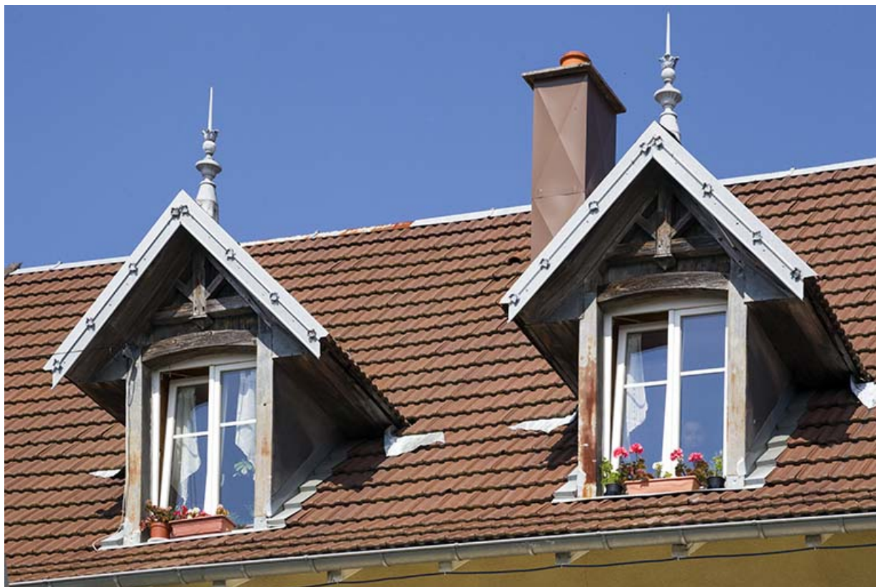
Logement patronal, façade latérale gauche : lucarnes.
