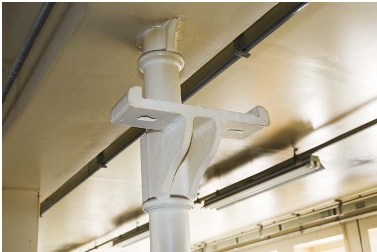
Usine, rez-de-chaussée : support des transmissions sur le poteau de soutènement. 25, Maîche, 7-9 rue du Mont
