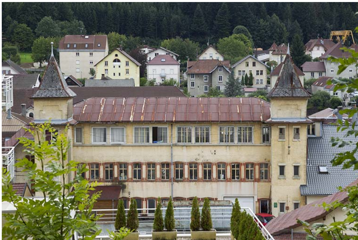
Usine : façade postérieure, vue en plongée. 25, Maîche, 7-9 rue du Mont
