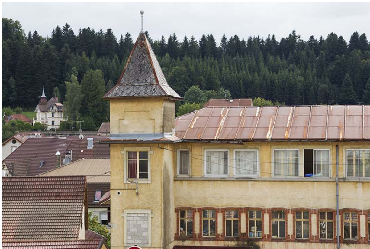
Usine, façade postérieure : tour orientale.
