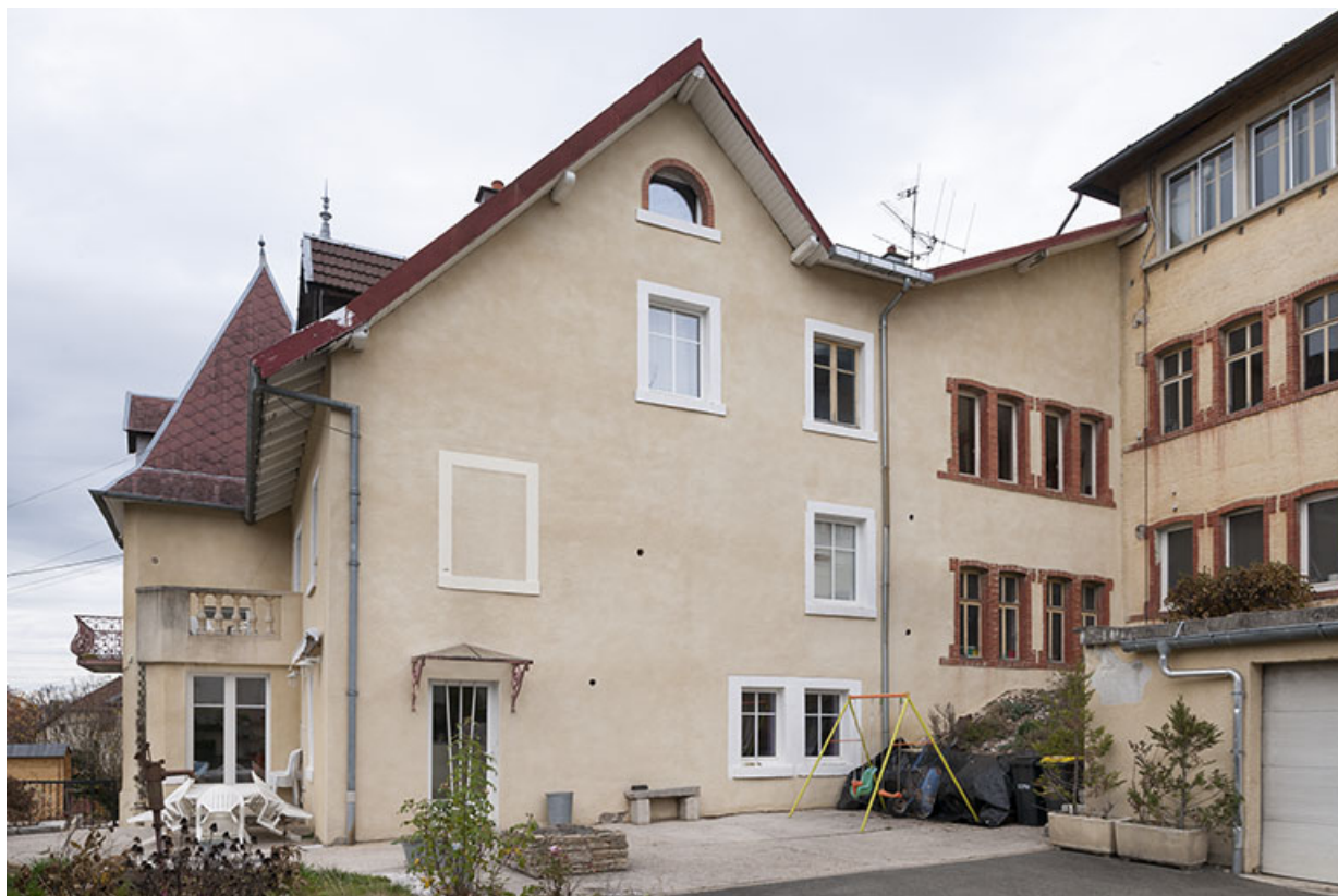
Façade est du logement patronal, depuis la rue du Mont à l'est. 25, Maîche, 7-9 rue du Mont
