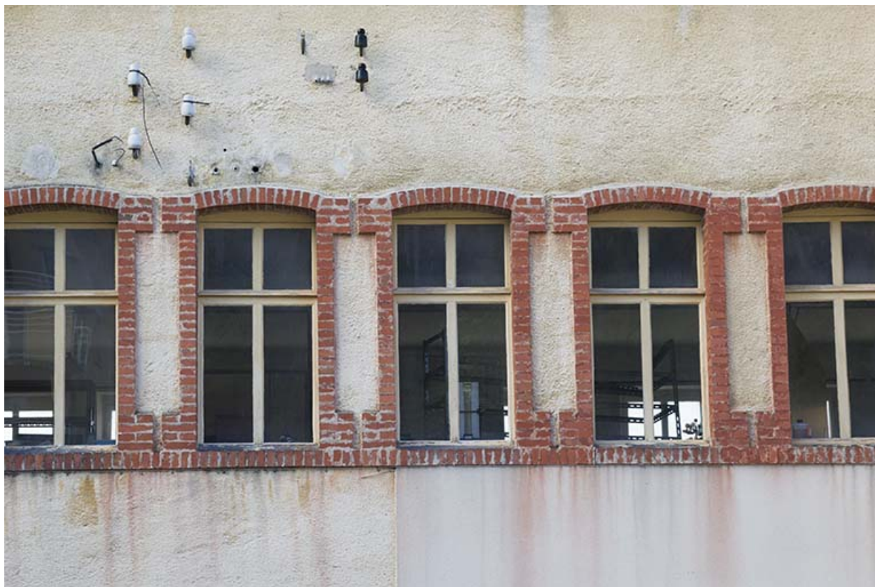
Usine, façade postérieure : fenêtres multiples.
