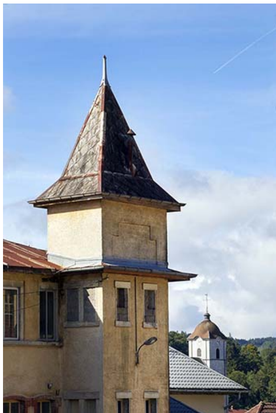
Usine, façade postérieure : tour occidentale (vue rapprochée). 25, Maîche, 7-9 rue du Mont
