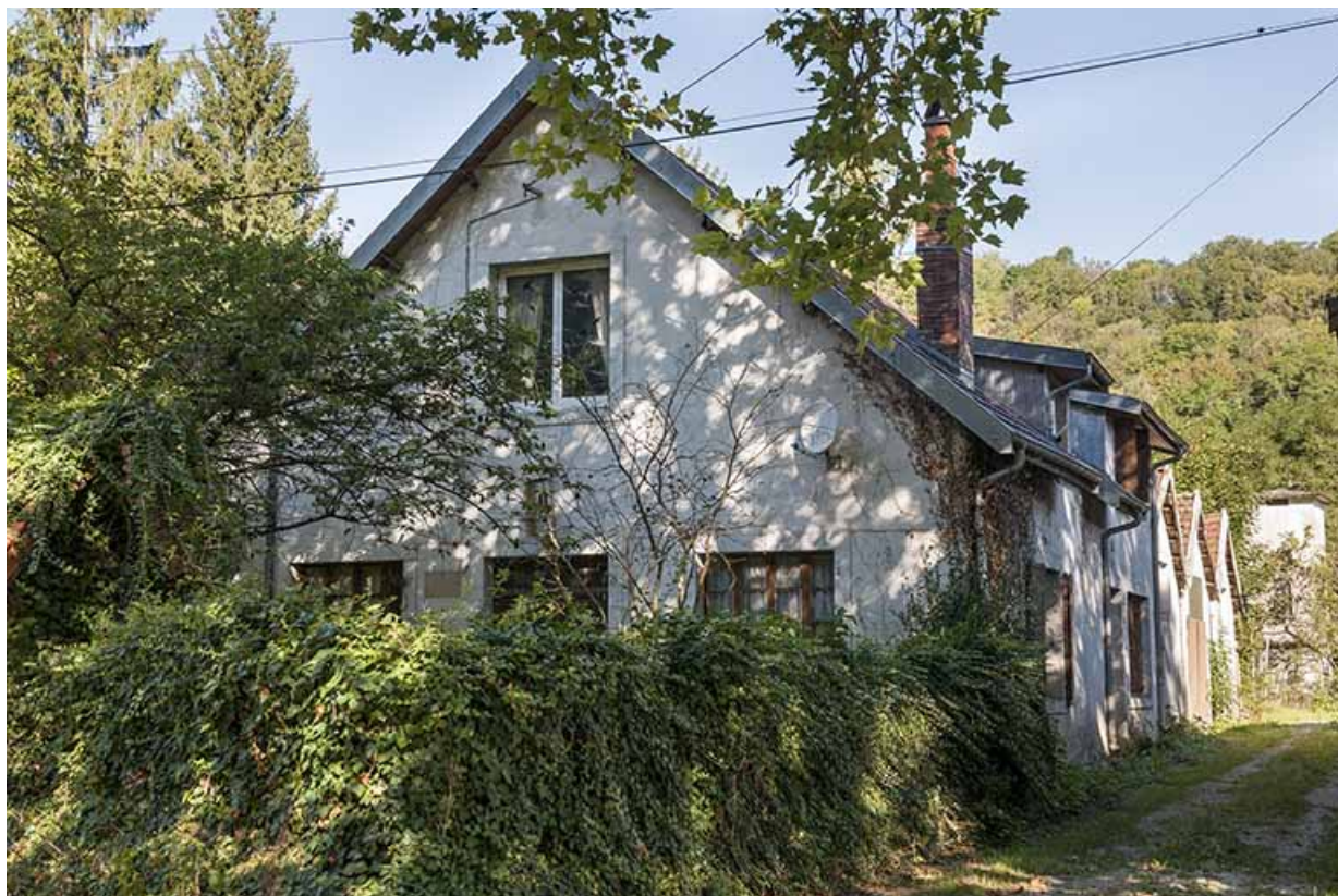
Bureau et magasin industriel. Vue depuis la route.
