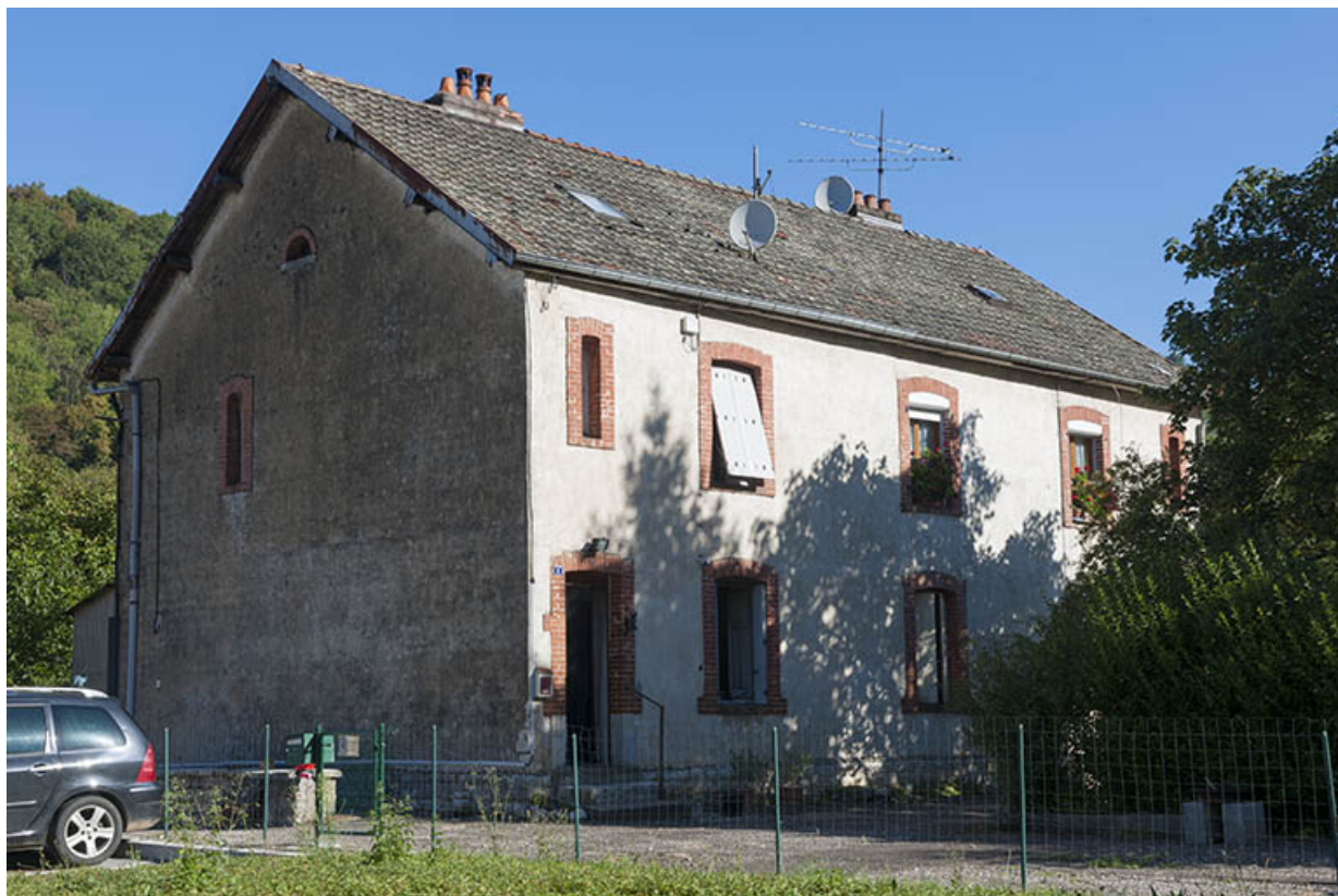
Logement ouvrier (nord) à 4 appartements. Vue depuis le sud.
