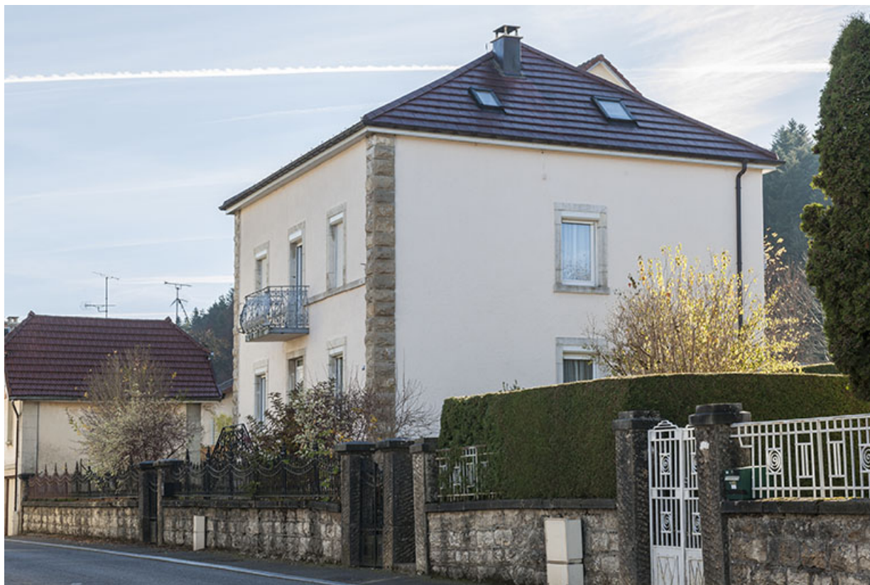
Maison au n° 16 : façades antérieure et latérale droite.
