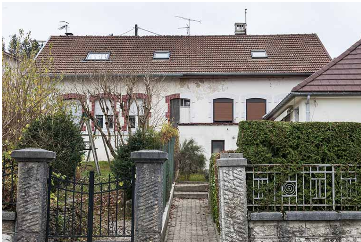
Atelier de fabrication : façade antérieure.
