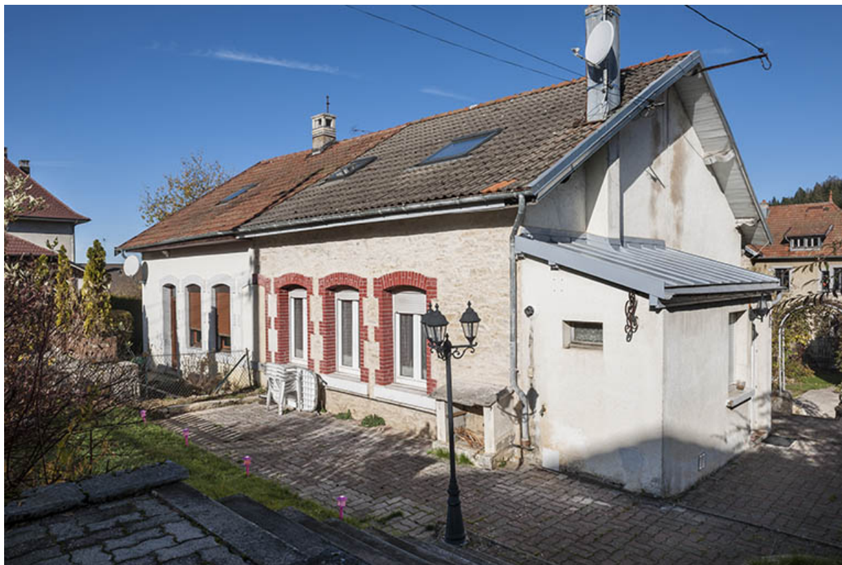
Atelier de fabrication : façades postérieure et latérale gauche. 25, Maîche
