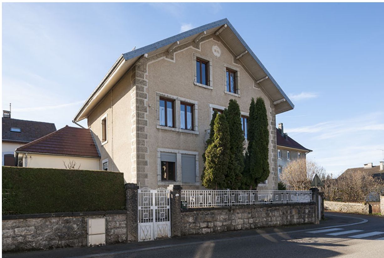
Maison au n° 14 : façades antérieure et latérale gauche.
