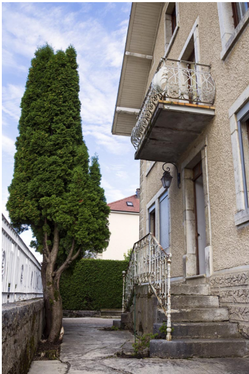
Maison au n° 14, façade antérieure : escalier et balcon, vus en enfilade.
