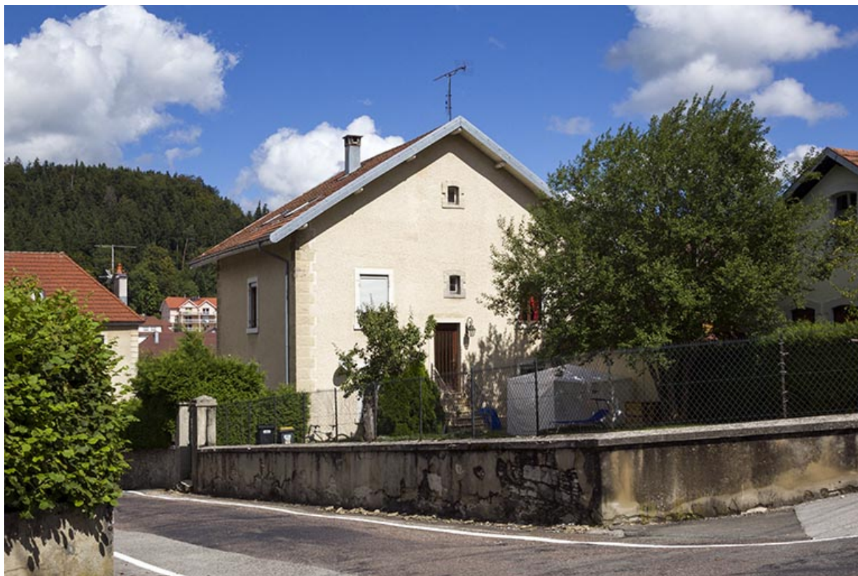
Maison au n° 14 : façades postérieure et latérale droite.
