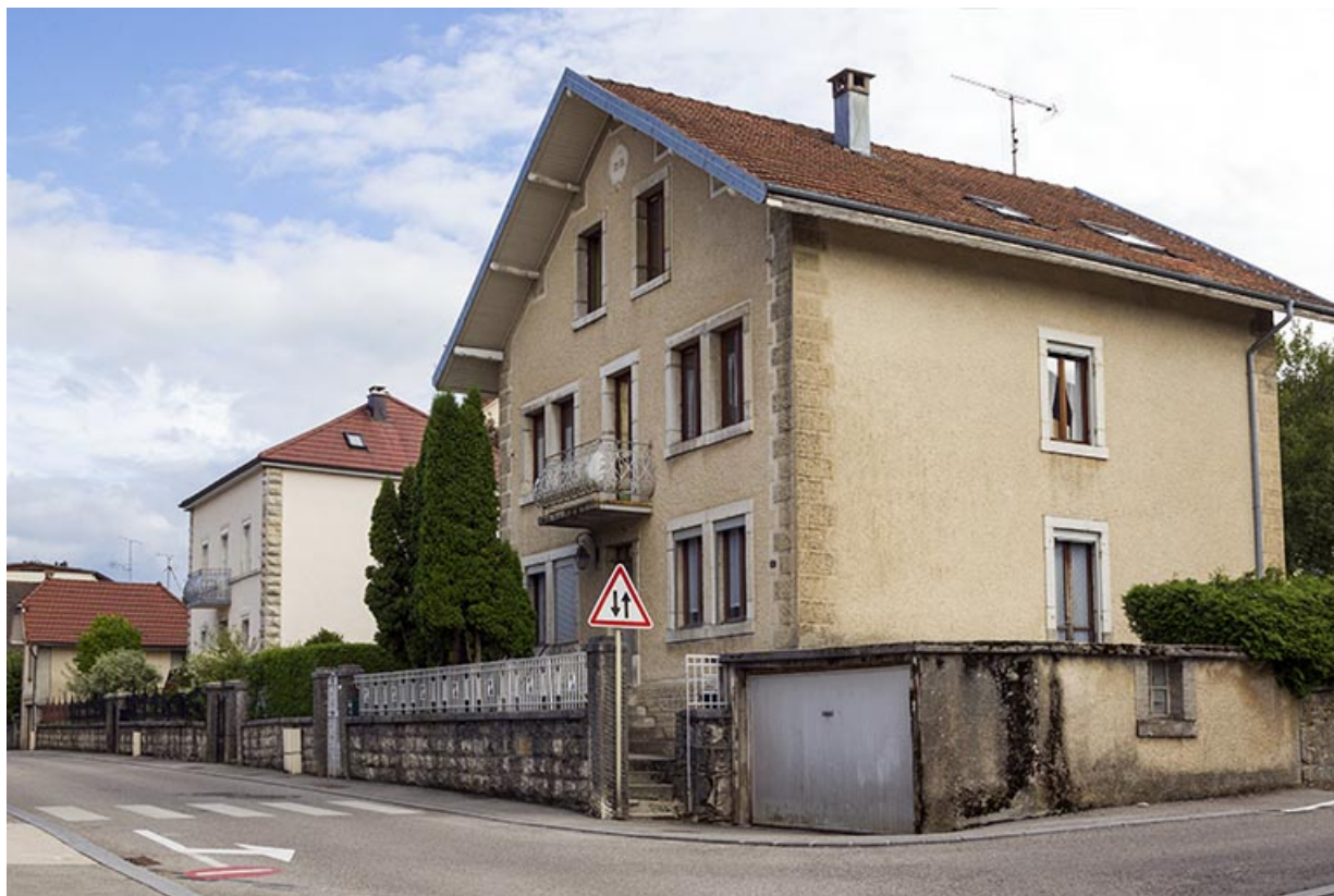
Vue d'ensemble du site, depuis l'ouest. 25, Maîche
