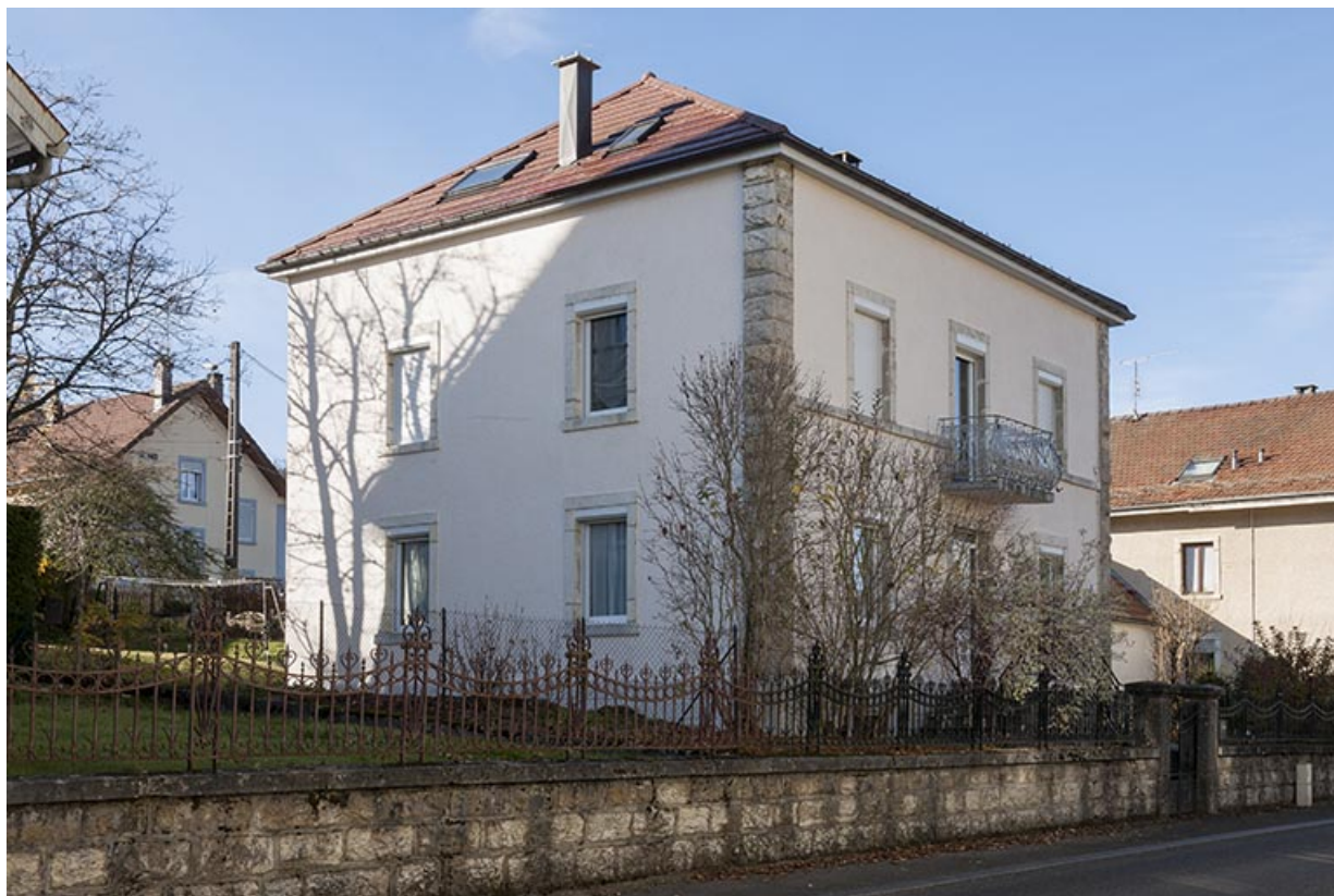
Maison au n° 16 : façades antérieure et latérale gauche.
