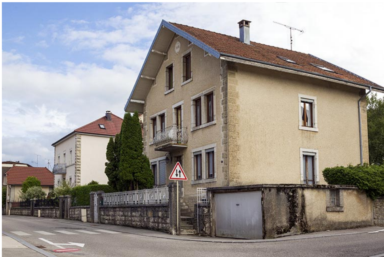
Vue d'ensemble du site, depuis l'ouest. 25, Maîche
