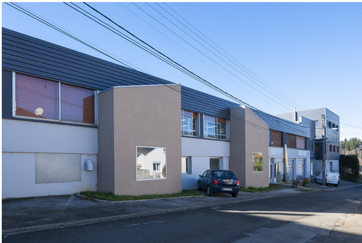
Façade postérieure (sur la rue de Mérode), vue en enfilade. 25, Maîche, 8 rue de la Batheuse
