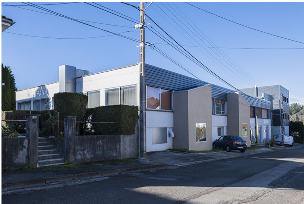
Façades postérieure et latérale droite.
