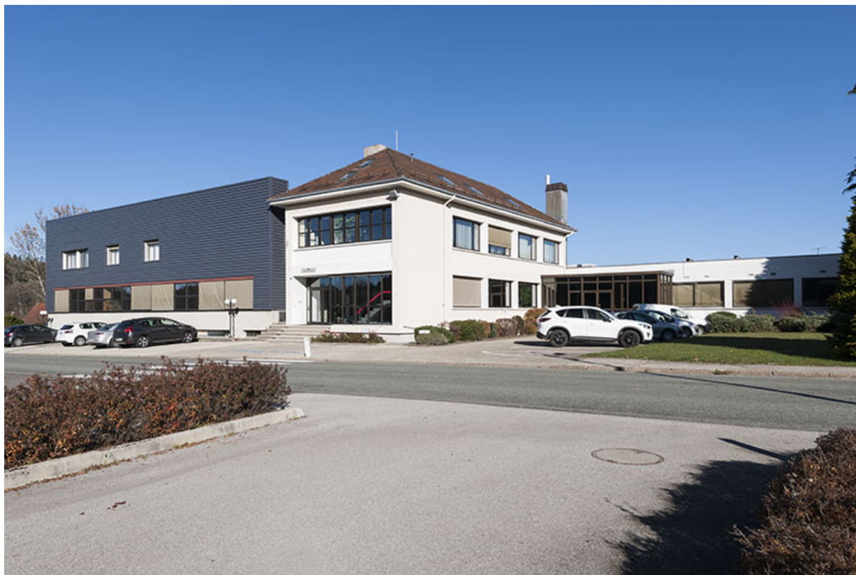
Façade antérieure, de trois quart droite.
