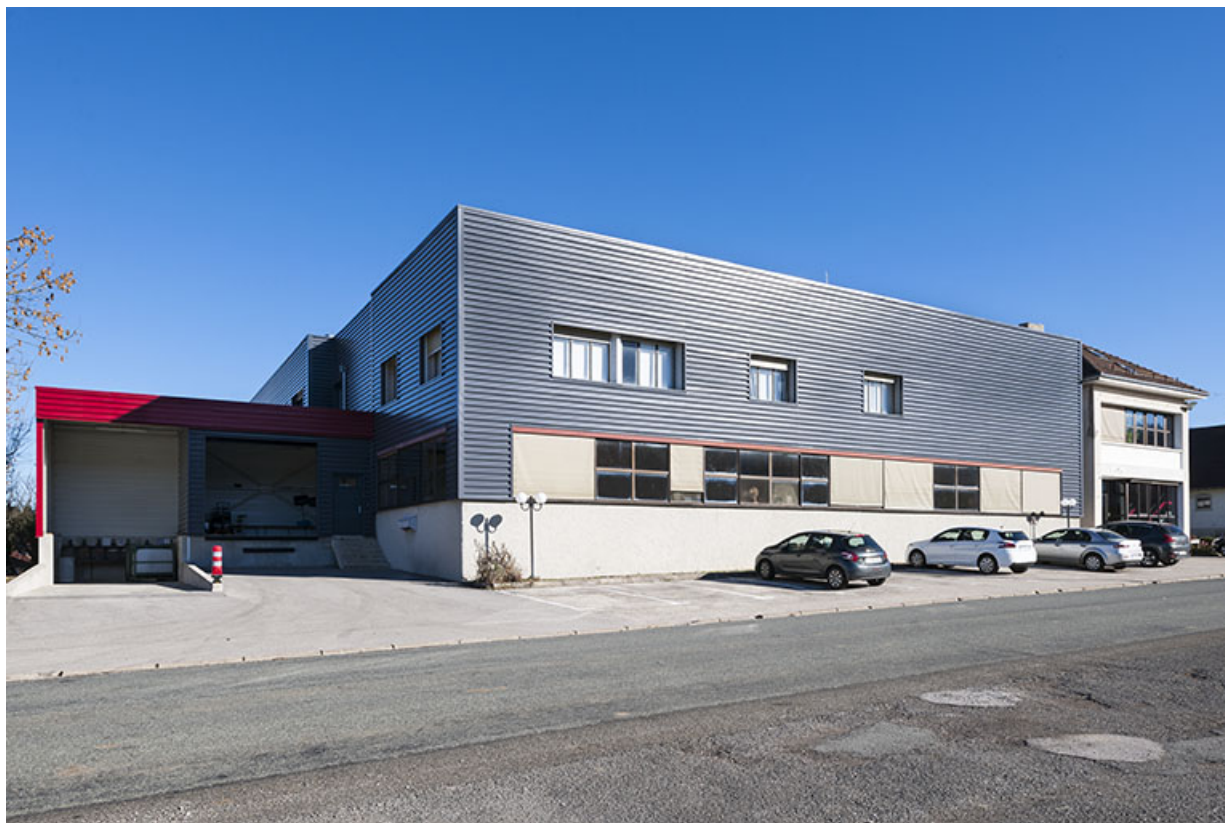
Façade antérieure : ateliers ouest.
