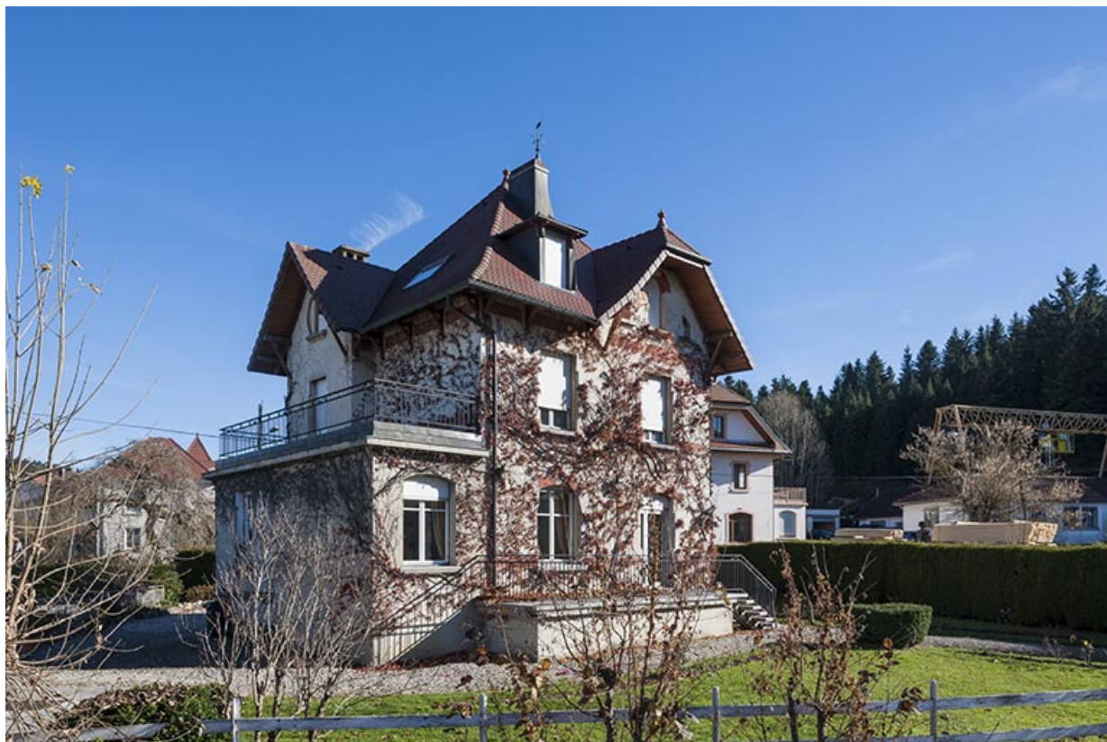
Villa Mascotte : façades postérieure et latérale droite.
