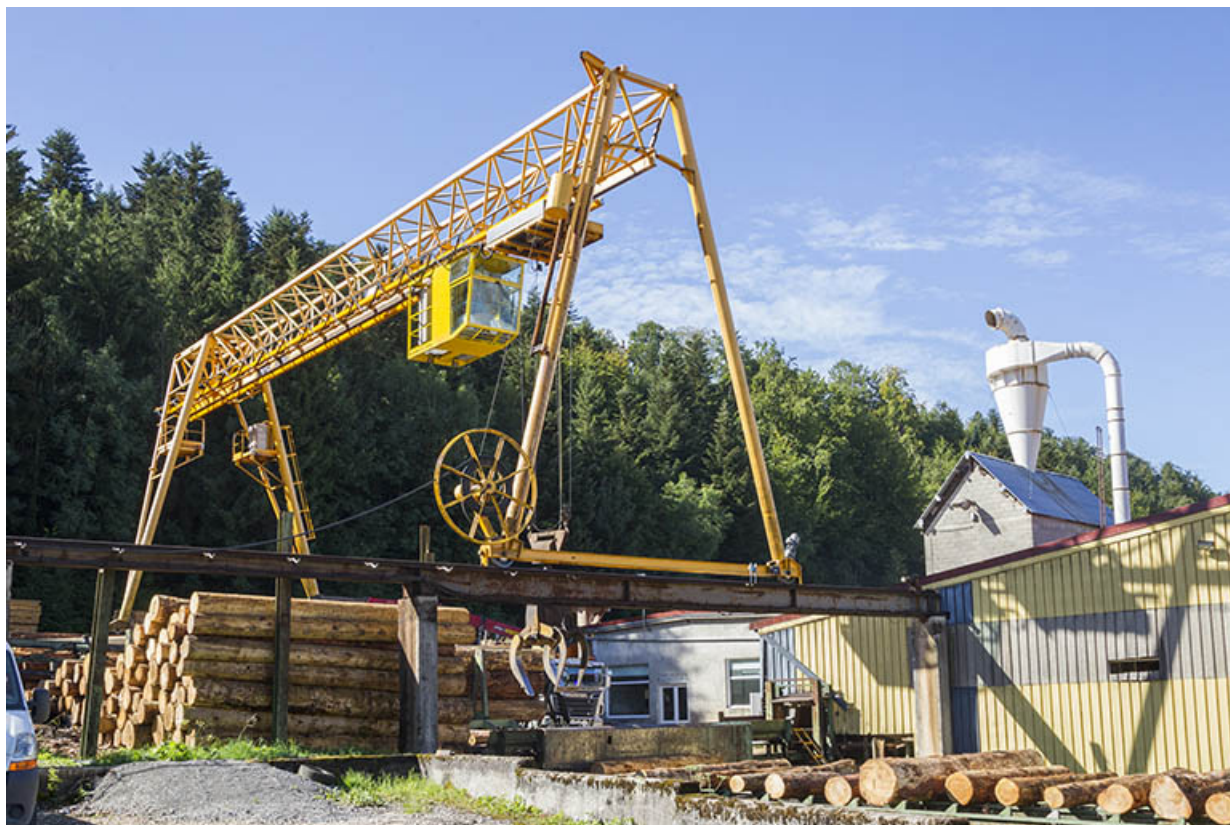
Le portique roulant sur son chemin de roulement. A droite l'atelier de débitage (M). 25, Maîche rue de la Scierie
