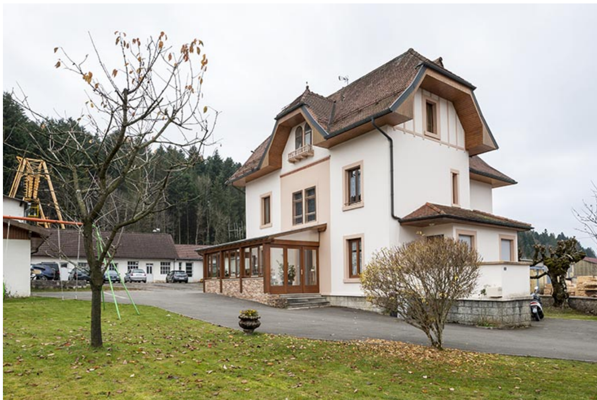
Logement patronal : façades nord et est.
