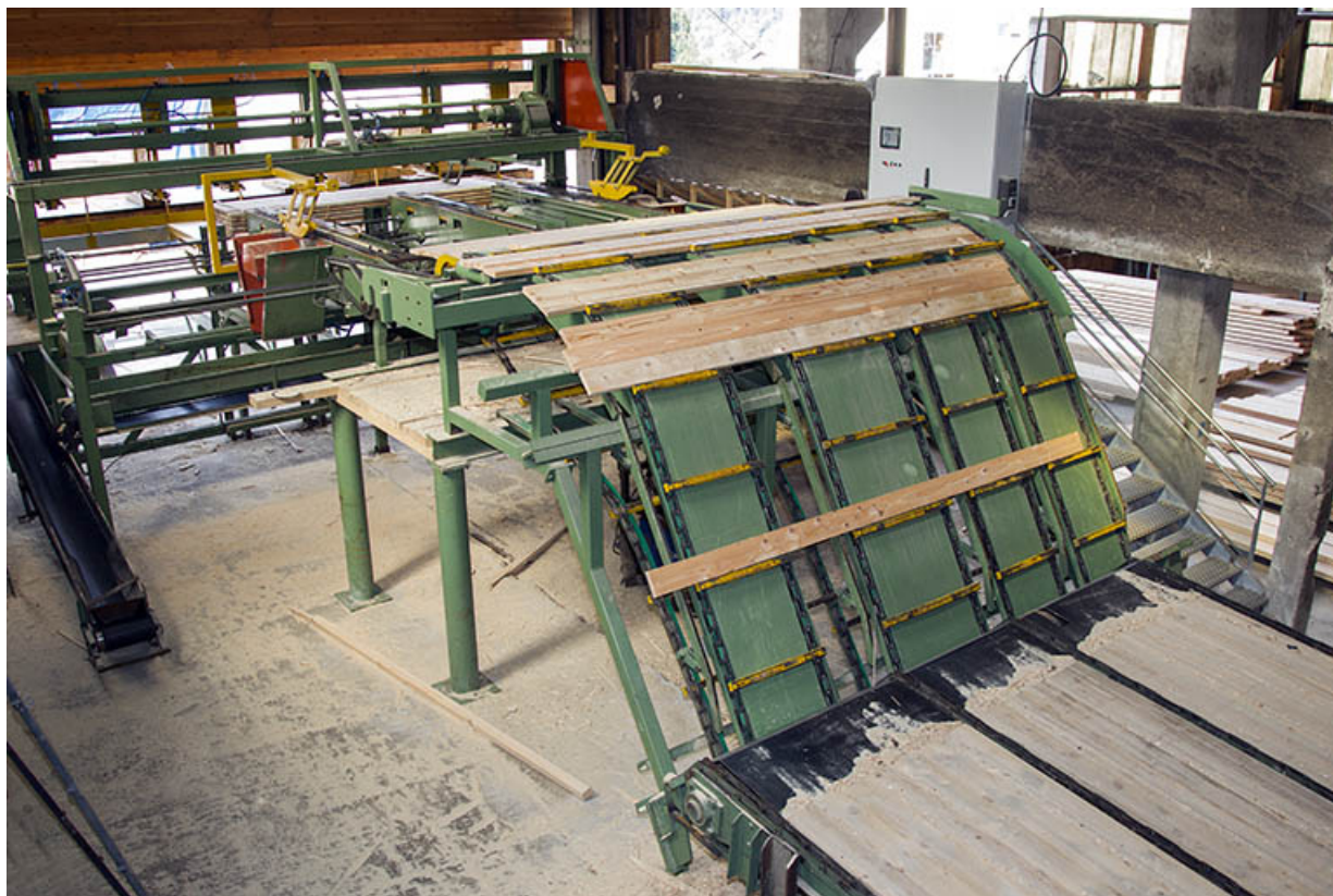
Atelier de triage et d'empilage (F) : empileuse. 25, Maïche rue de la Scierie
