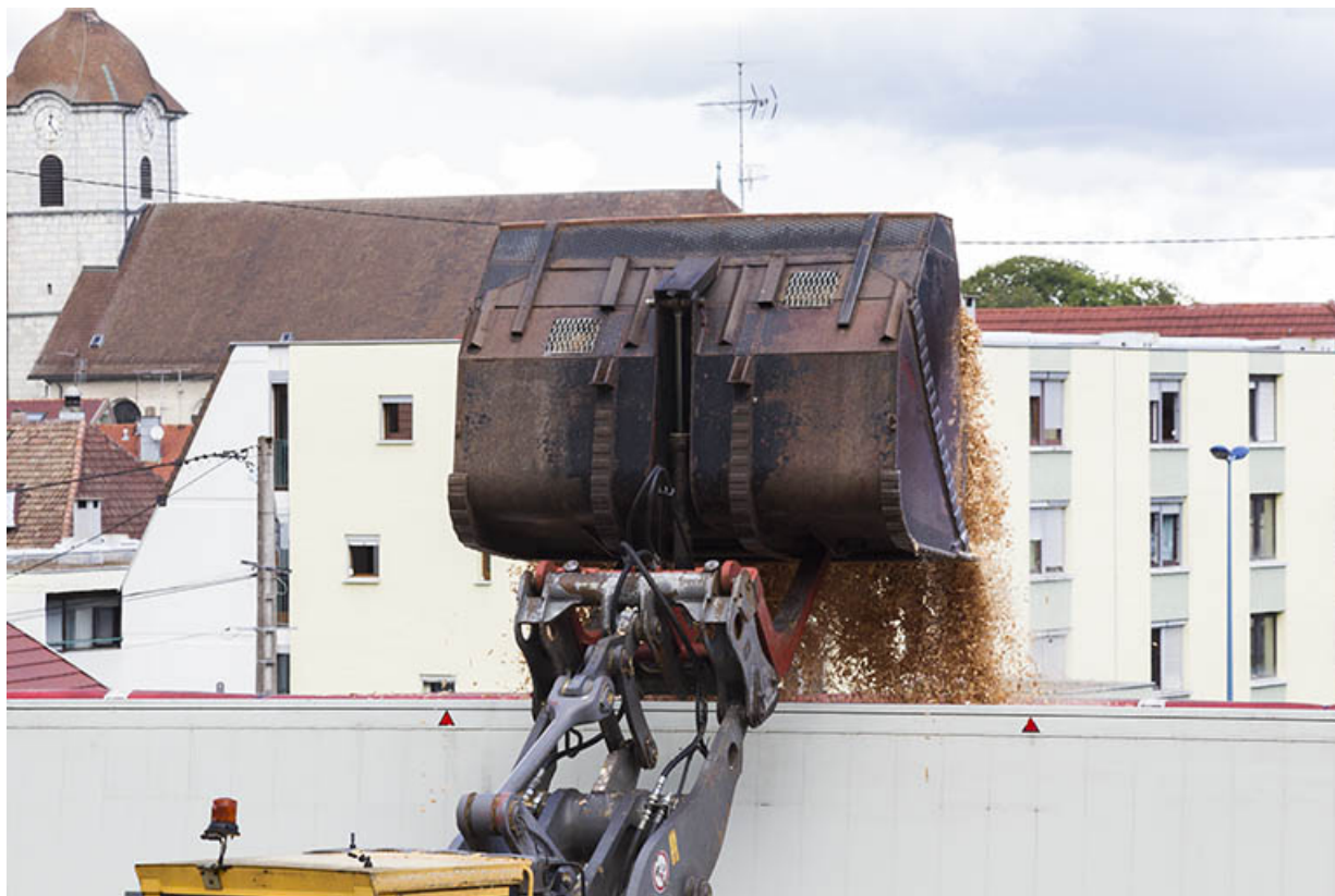
Silos à copeaux (B) : godet du chargeur. 25, Maïche rue de la Scierie
