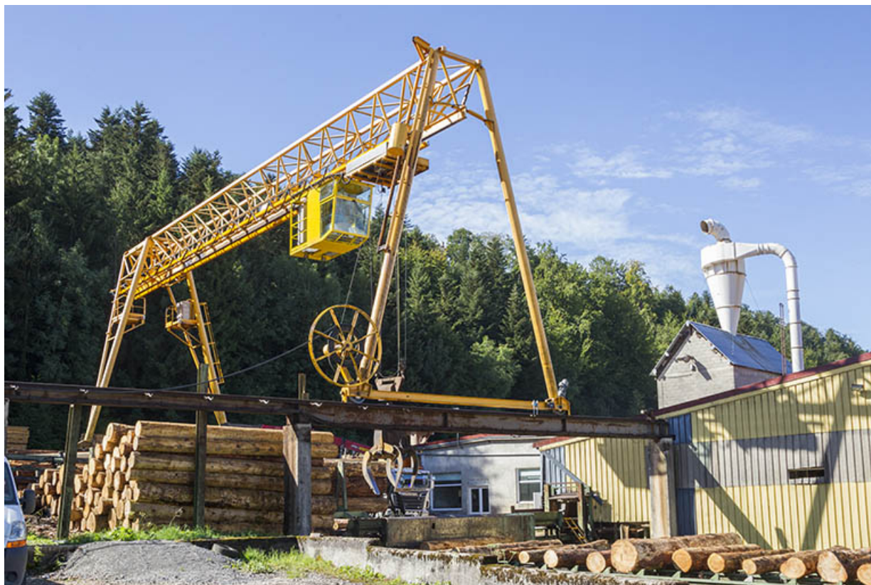
Le portique roulant sur son chemin de roulement. A droite l'atelier de débitage (M). 25, Maïche rue de la Scierie
