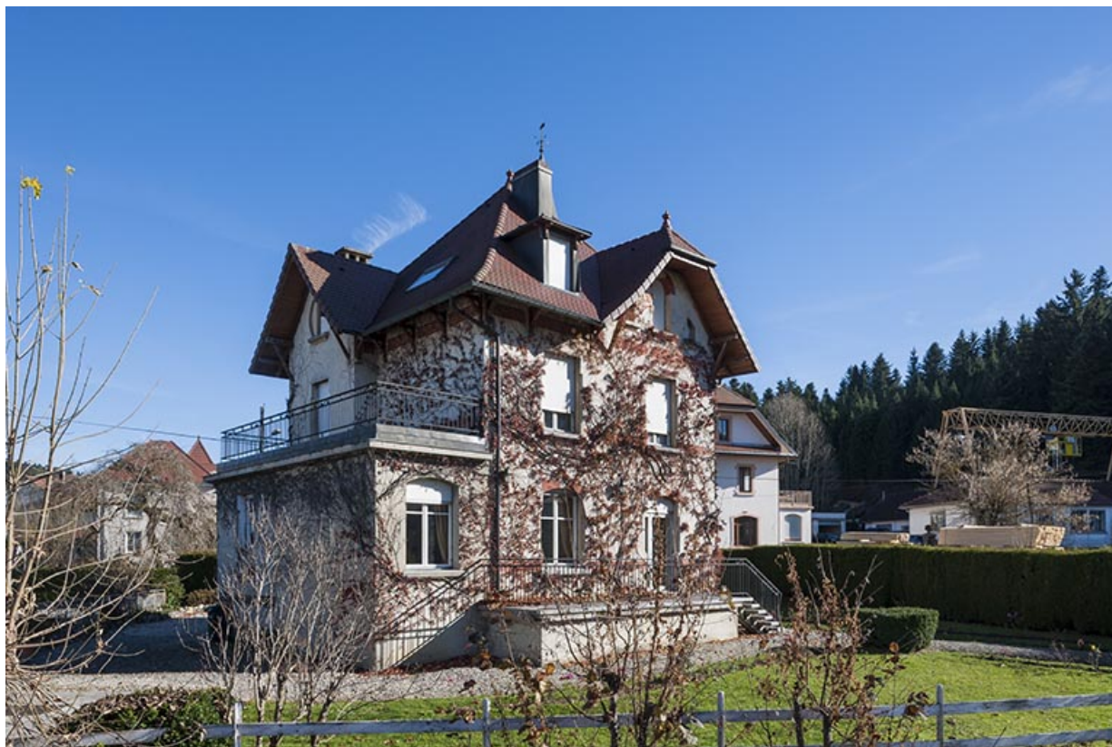
Villa Mascotte : façades postérieure et latérale droite.
