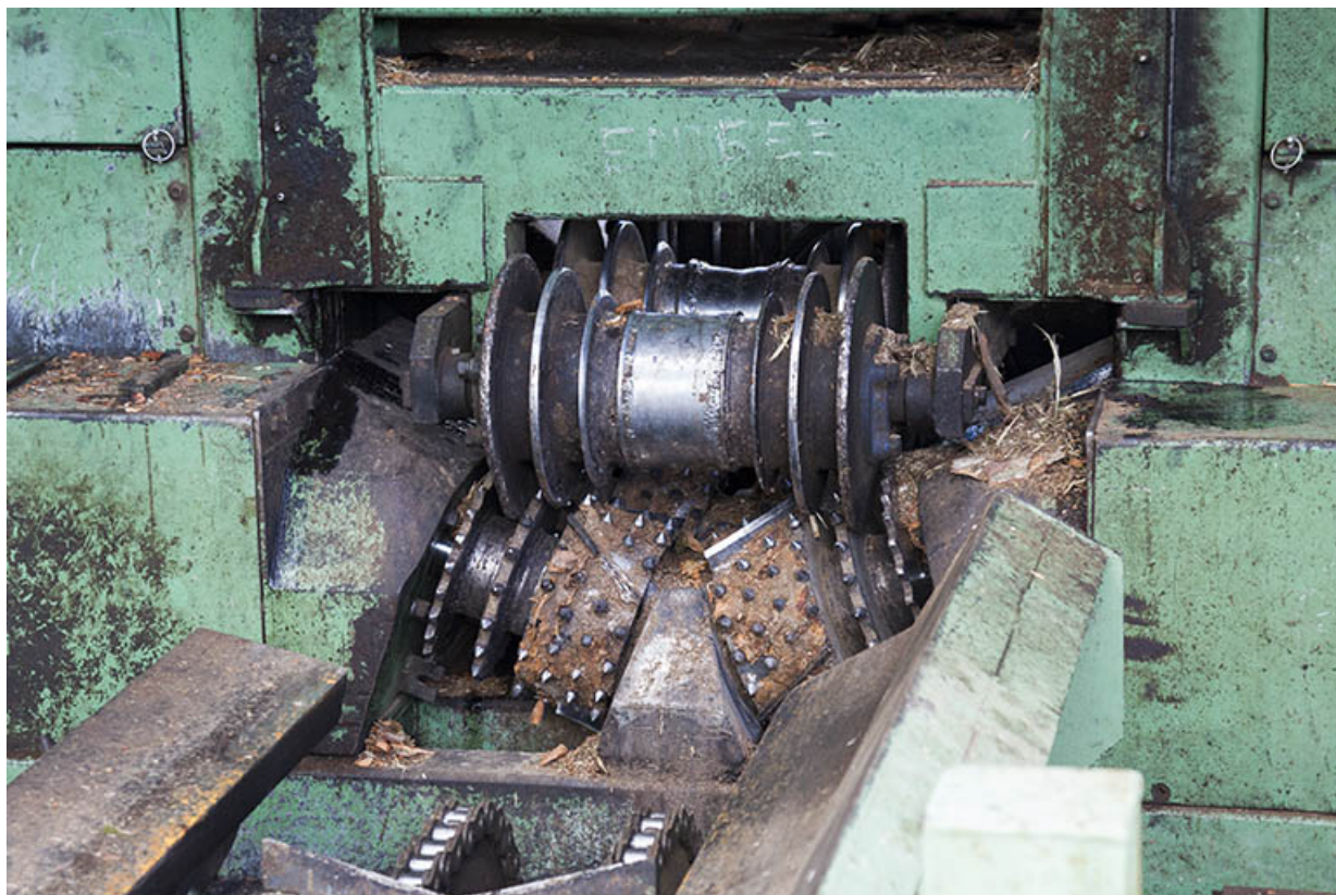
Installation de billonnage : détail des rouleaux. 25, Maïche rue de la Scierie
