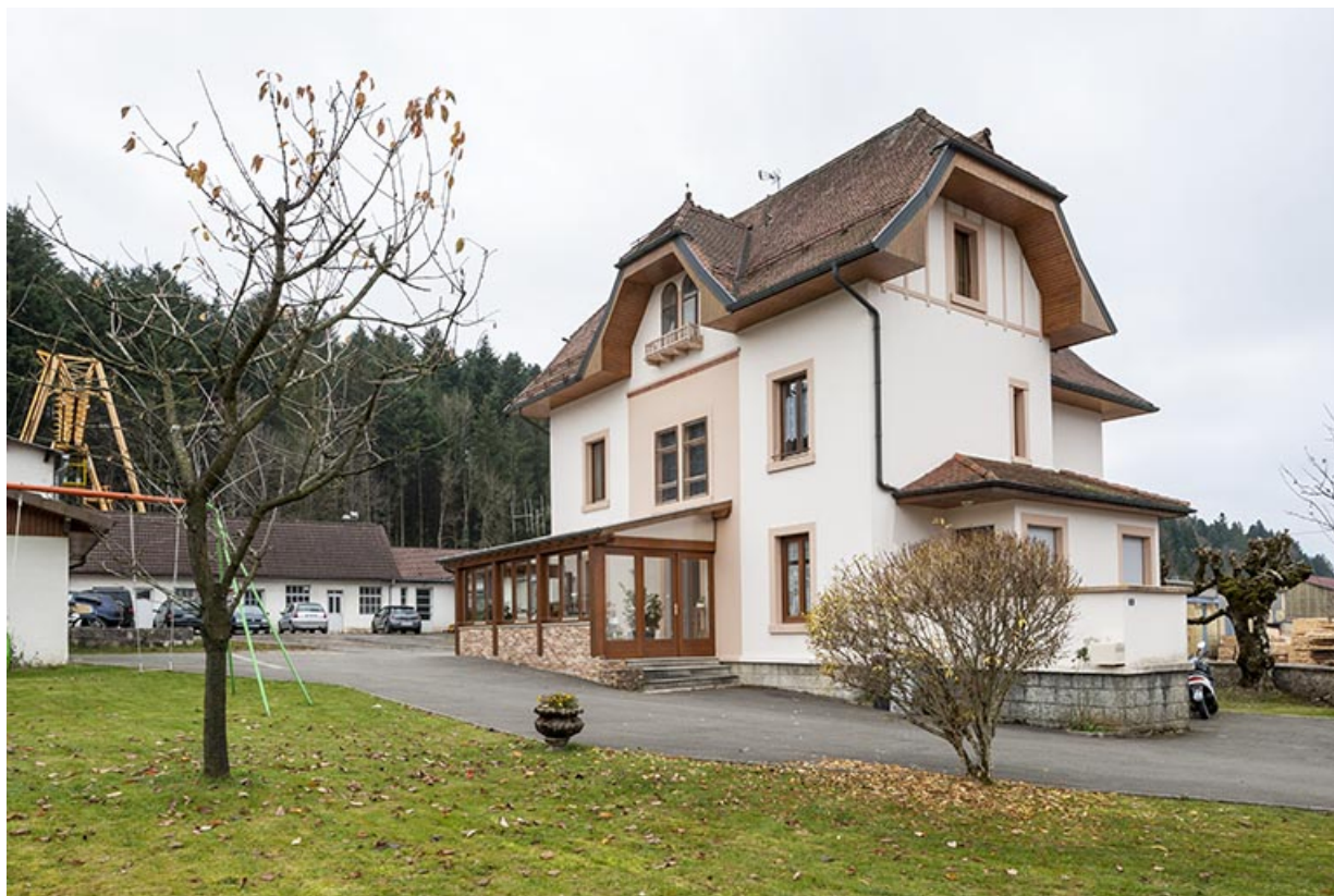
Logement patronal : façades nord et est.
