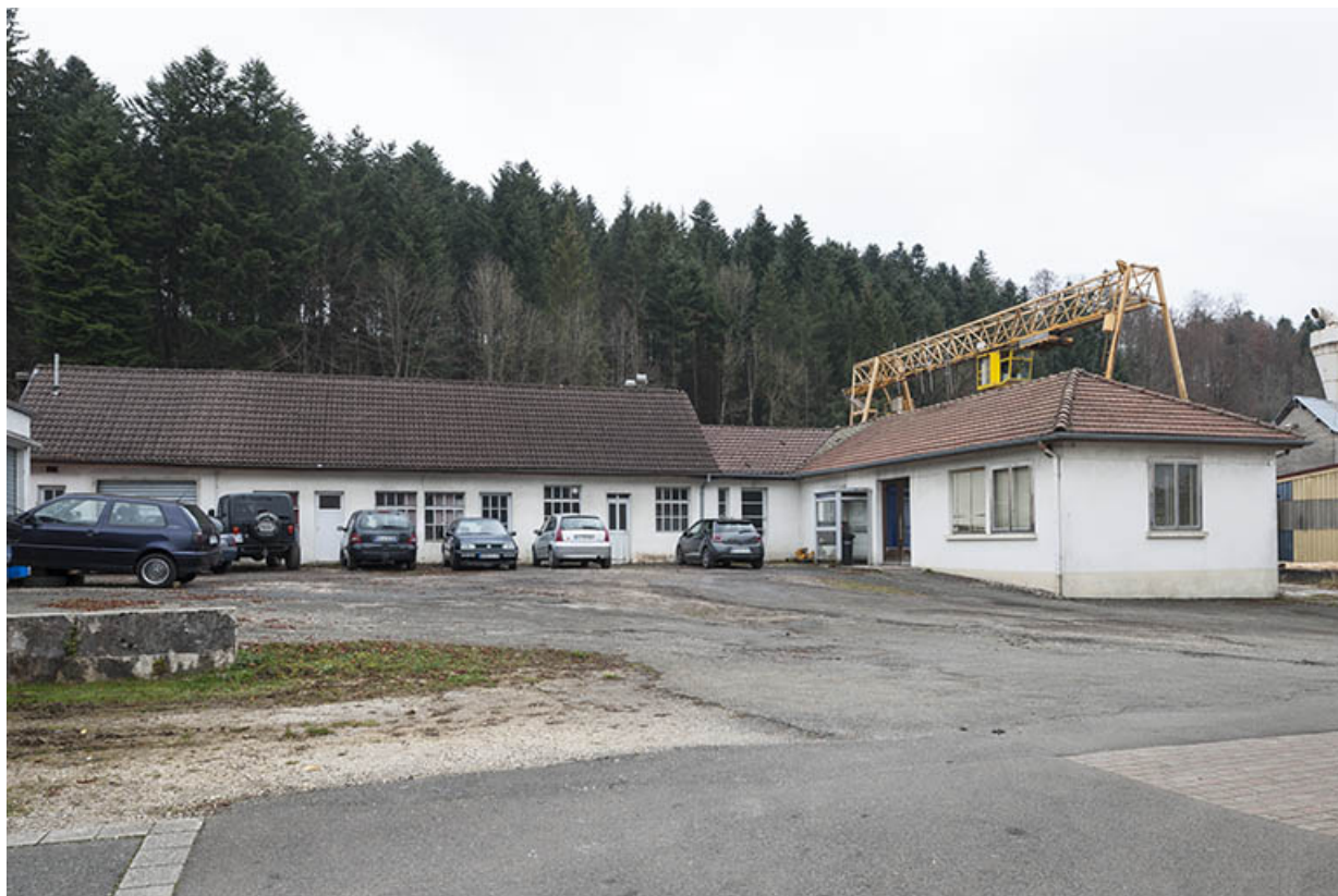
Site du logement patronal : ensemble bureau, logement, garages et atelier de réparation, vu du nord. 25, Maïche rue de la Scierie
