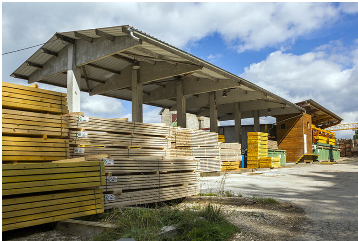
Séchoir à planches et ateliers de trempage (I et J).
