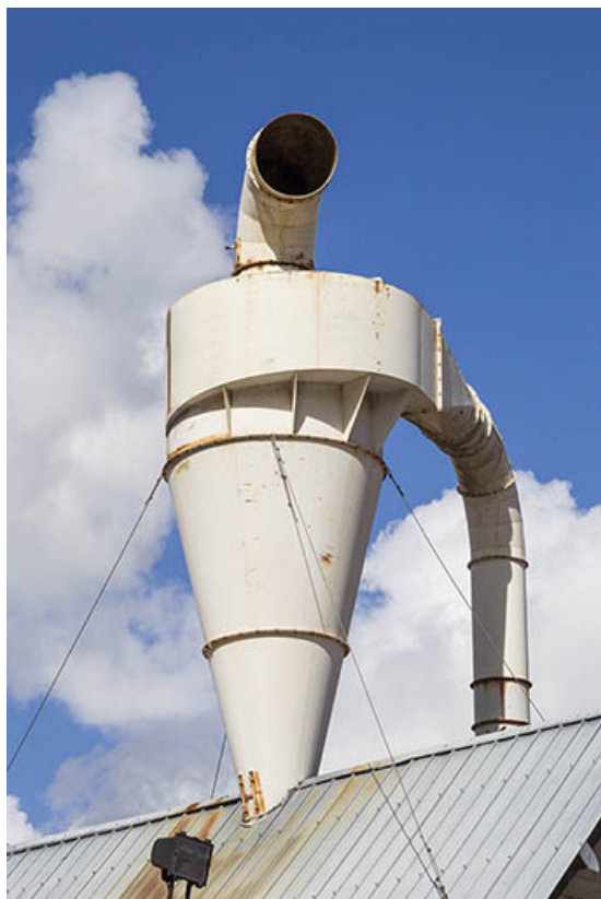
Silo à sciure (L) : cyclone. 25, Maïche rue de la Scierie
