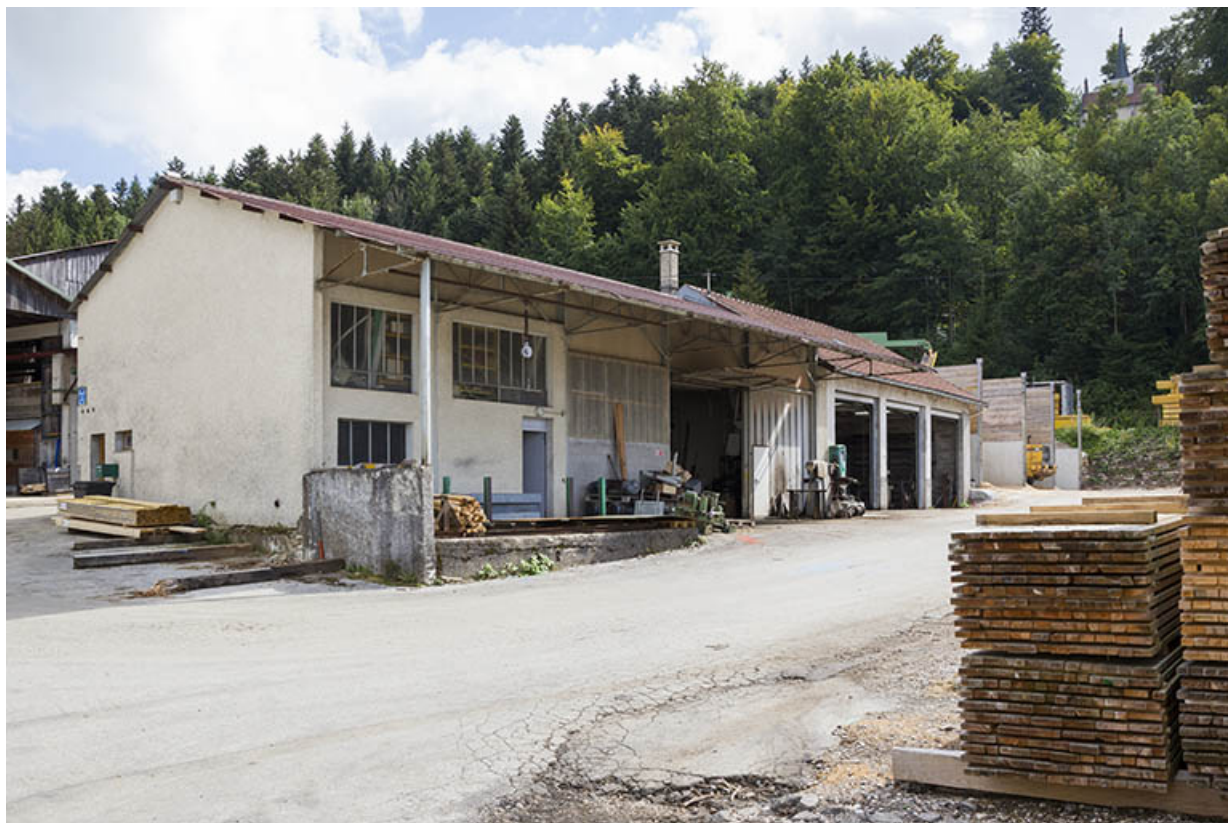
Ateliers de réparation (D et C) et silos à copeaux (B), de trois quarts gauche. 25, Maïche rue de la Scierie
