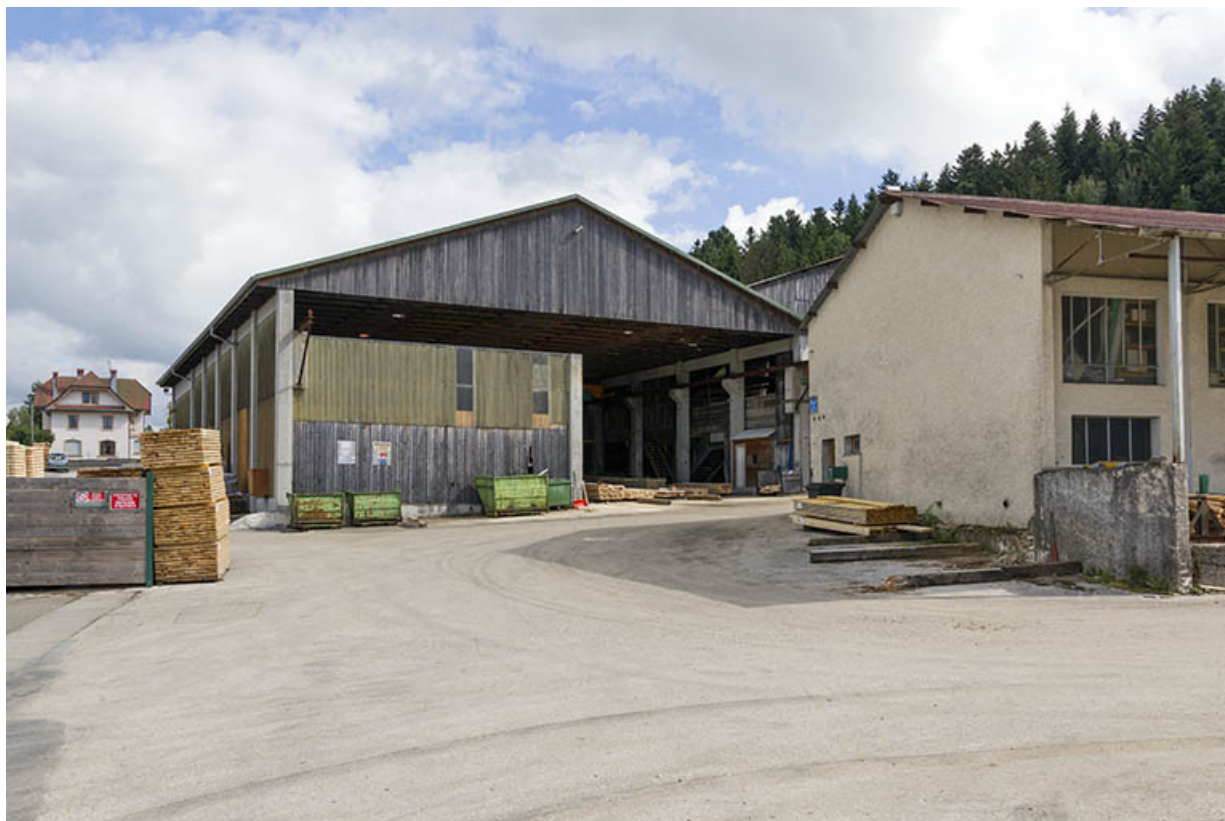
Atelier de triage et d'empilage (E), depuis l'entrée à l'ouest. A gauche la villa Thidric, à droite l'atelier de réparation (D). 25, Maïche rue de la Scierie
