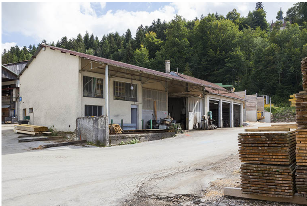
Ateliers de réparation (D et C) et silos à copeaux (B), de trois quarts gauche. 25, Maïche rue de la Scierie
