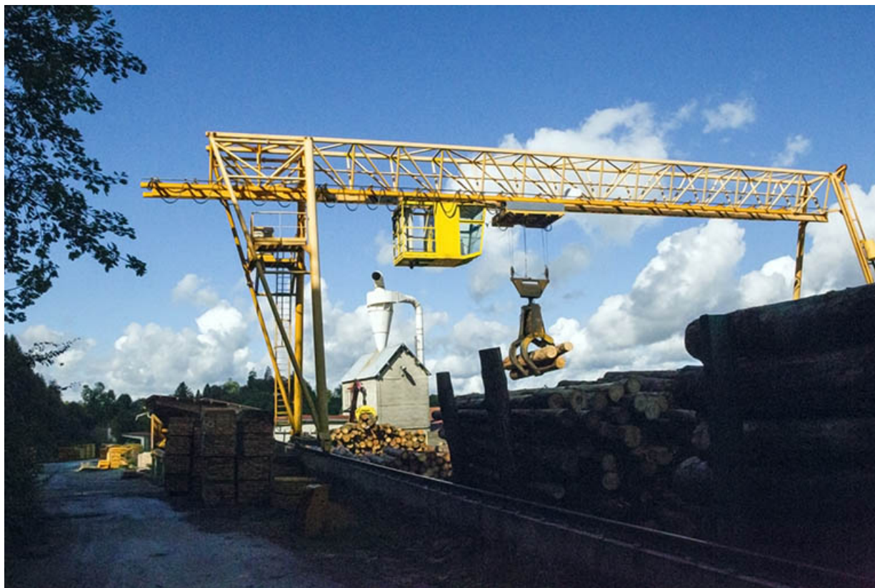
Le portique roulant, depuis l'aire des matières premières (à l'est). 25, Maïche rue de la Scierie
