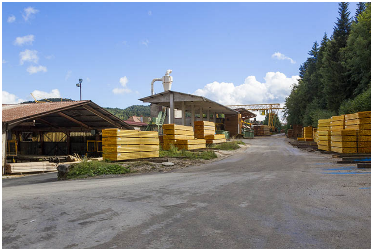
Extrémité sud de l'atelier de triage et d'empilage (G), séchoir à planches et ateliers de trempage (I et J). 25, Maïche rue de la Scierie
