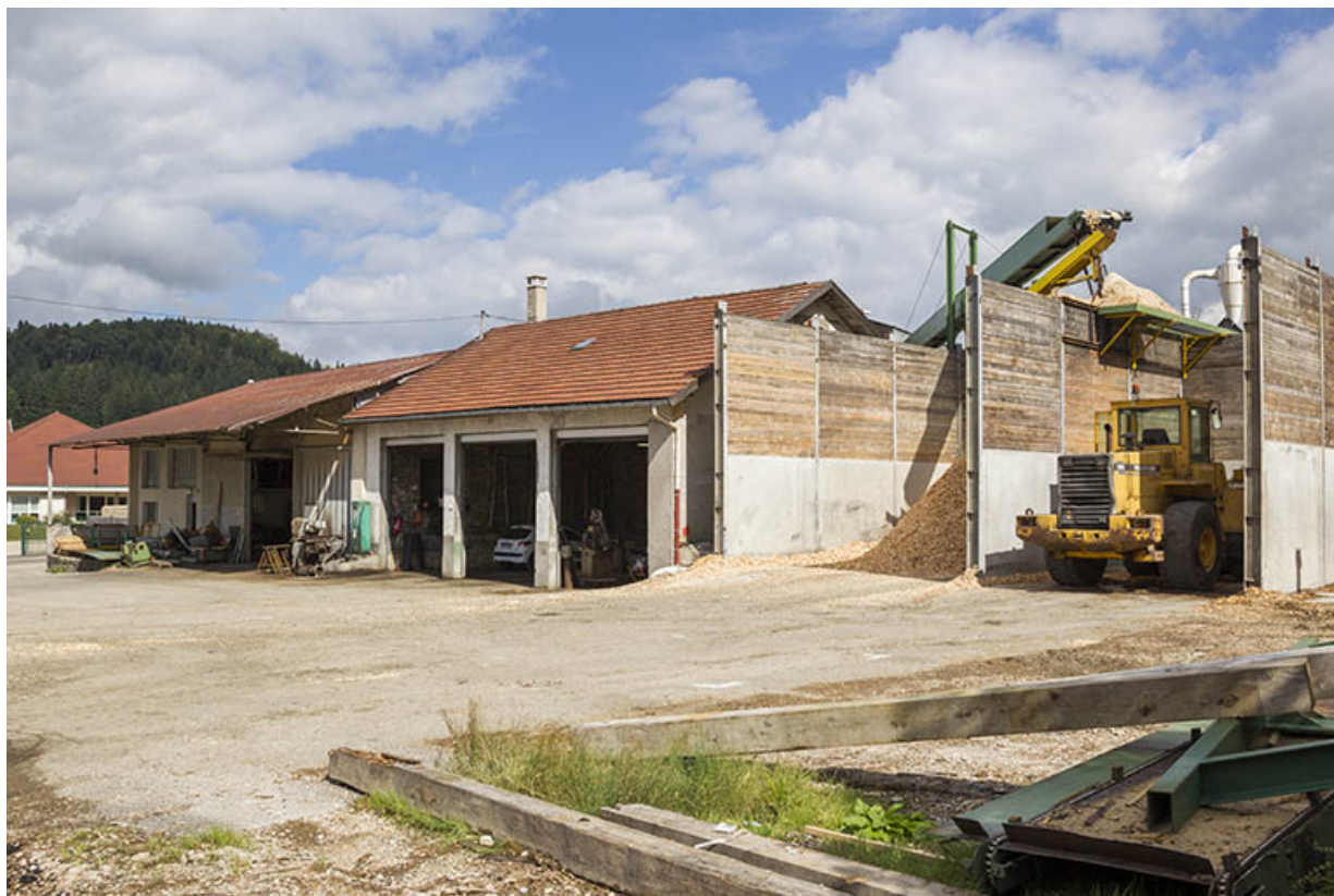
Silos à copeaux (B) et ateliers de réparation (C et D), de trois quarts droite. 25, Maïche rue de la Scierie
