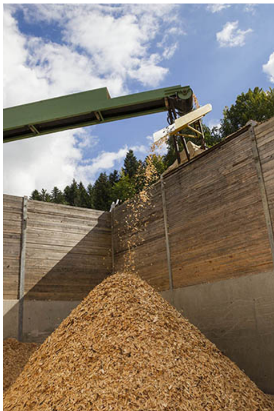
Silos à copeaux (B) : système d'amenée des copeaux. 25, Maïche rue de la Scierie
