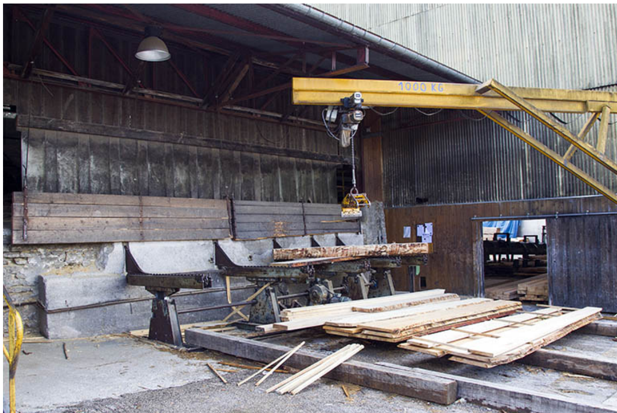
Atelier de débitage (M) : extrémité nord. C'est l'un des bâtiments anciens du site. 25, Maïche rue de la Scierie
