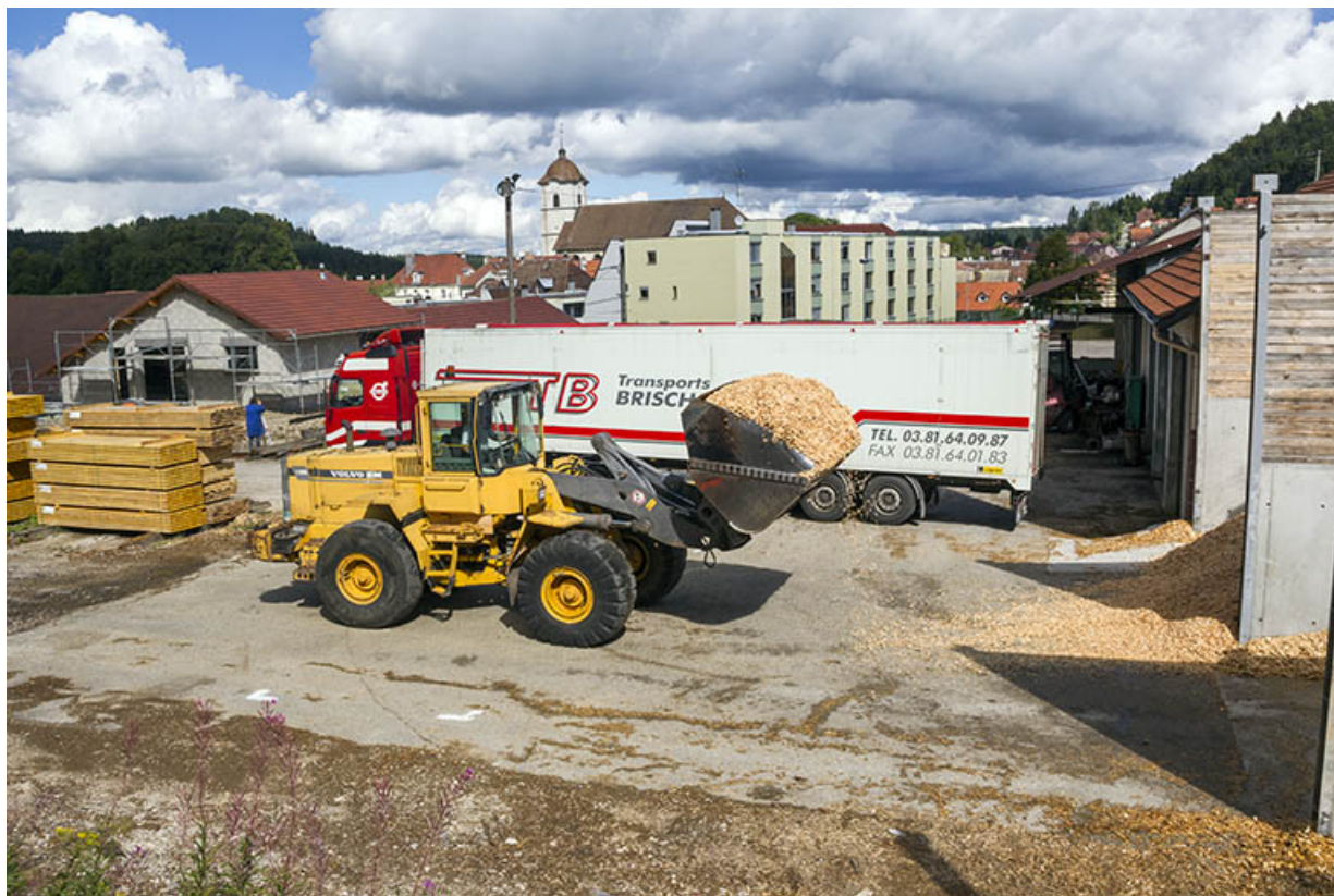
Silos à copeaux (B) : chargement d'un camion. 25, Maïche rue de la Scierie
