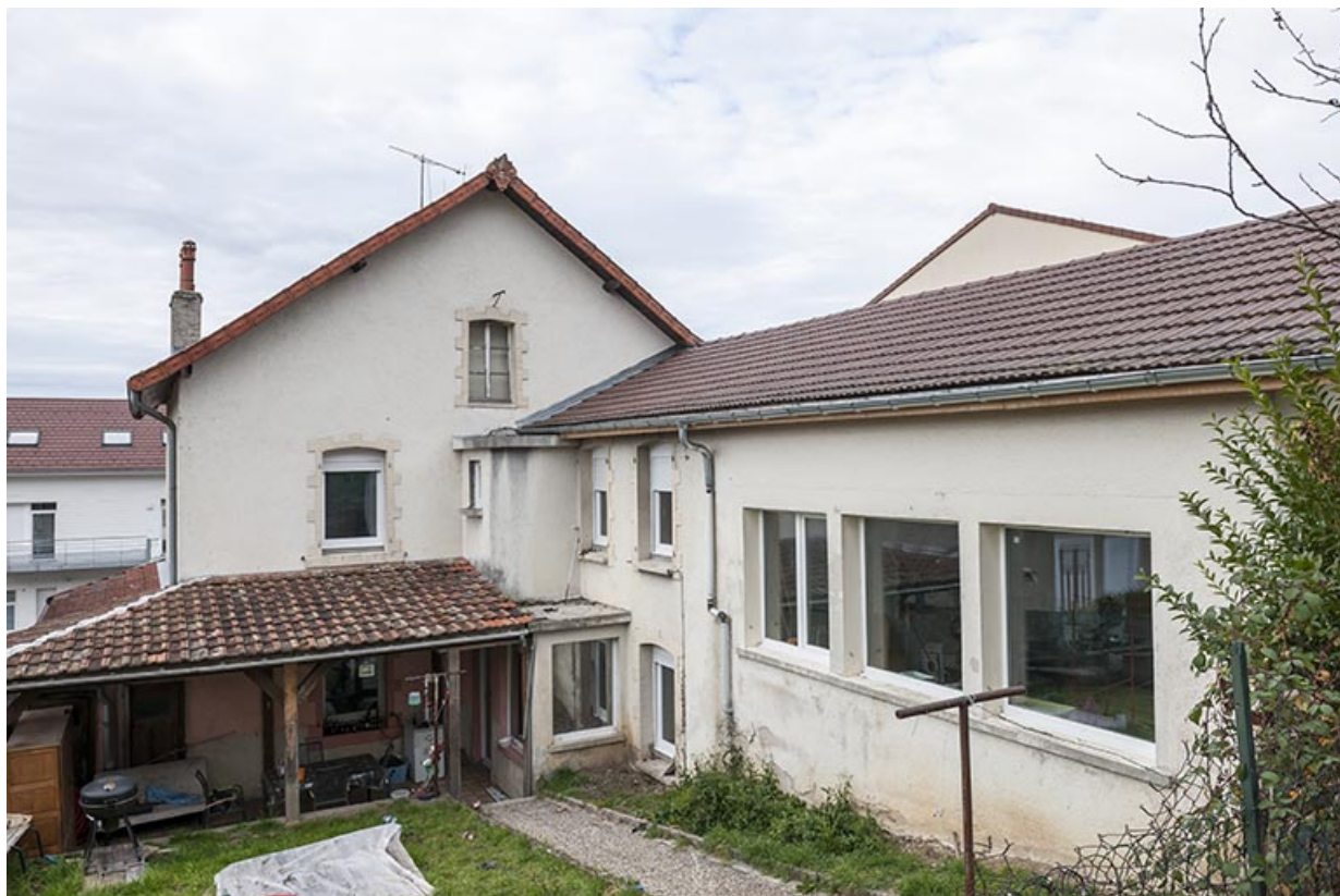
Logement (façade postérieure) et atelier.
