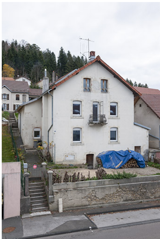
Logement : façade antérieure, de trois quarts gauche. 25, Maîche, 22 rue de Saint-Hippolyte
